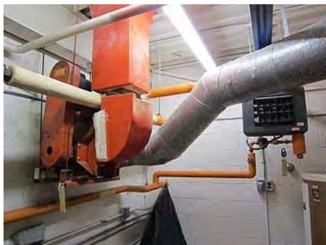
Washroom exhaust fan EF 101
