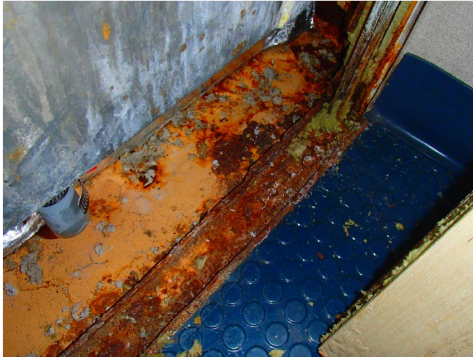
Figure 16 : Rigole de fixation et plancher corrodé
