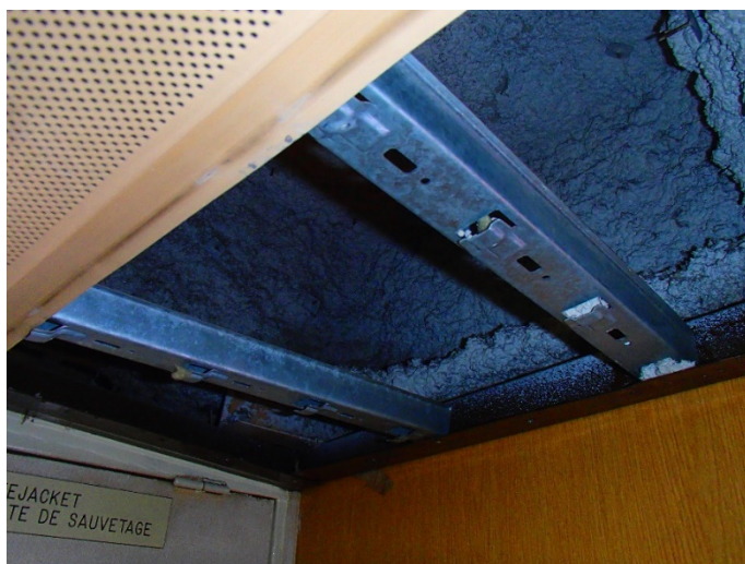
Figure 15 : Plafond suspendu typique
