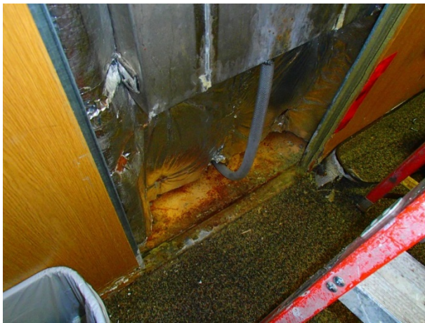
Figure 18 : tuyau de drainage du bassin sous la fenêtre
