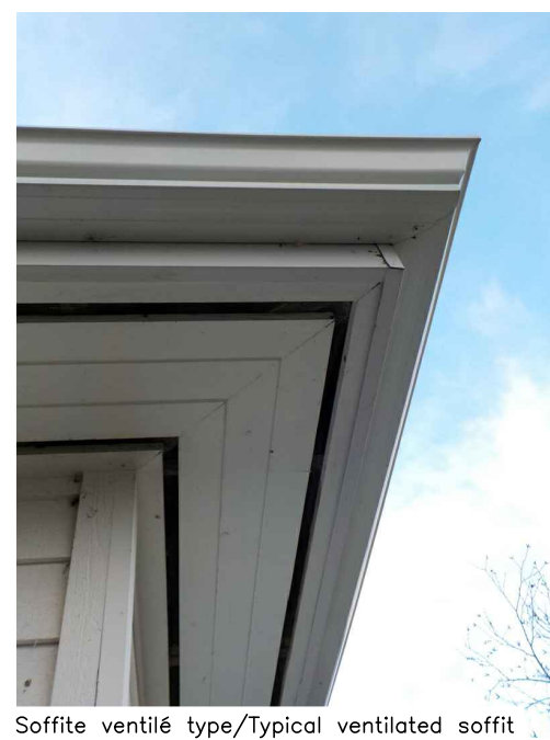
Soffite ventilé type/Typical ventilated soffit
