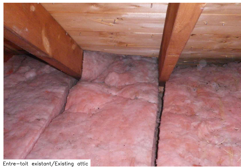
Entre-toit existant/Existing attic
