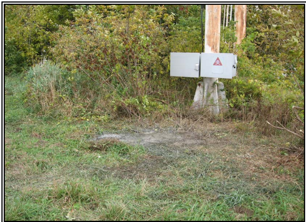
Photographie no 4: État des lieux après la réalisation du forage F-01.
