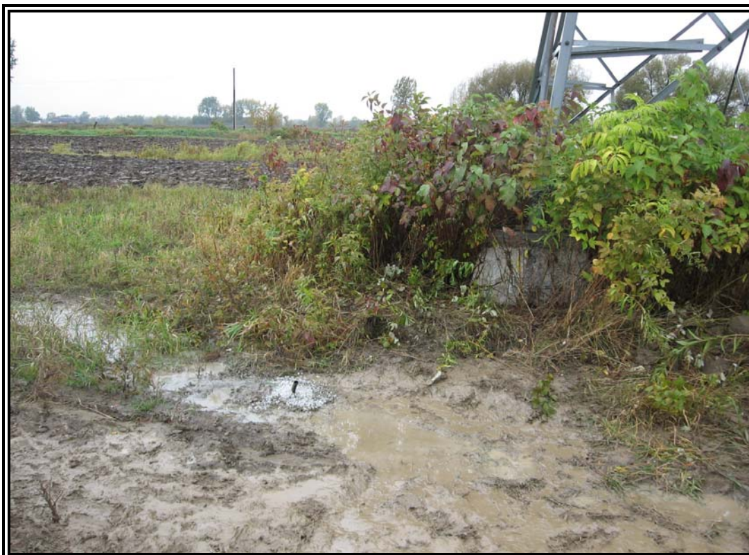
Photographie no 4: État des lieux après la réalisation du forage F-02.
