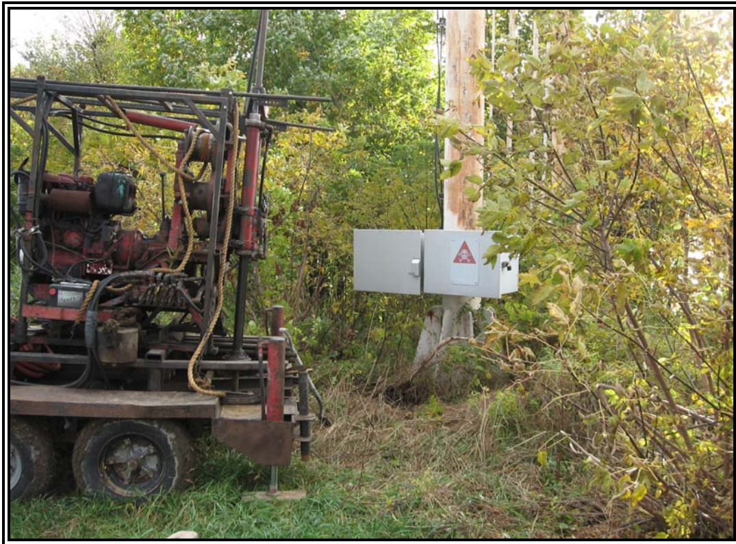
Photographie no 3: Emplacement de la foreuse pour la réalisation du forage F-01.
