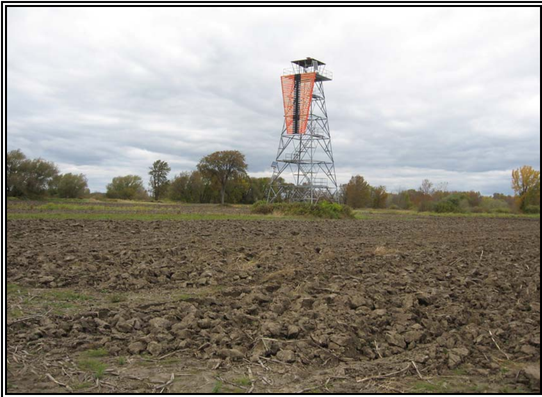
Photographie no 1: Vue en direction nord du feu d'alignement postérieur pour la navigation (FP) sur l'Île Bouchard.
