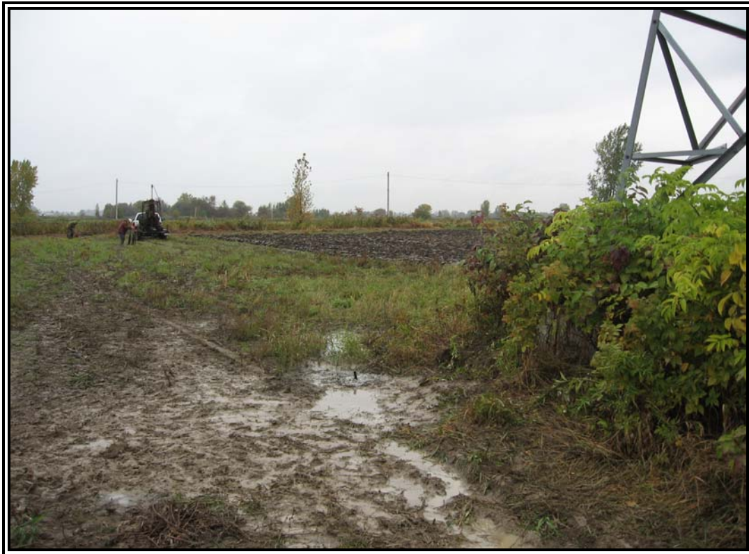
Photographie no 3: État des lieux après la réalisation du forage F-02.
