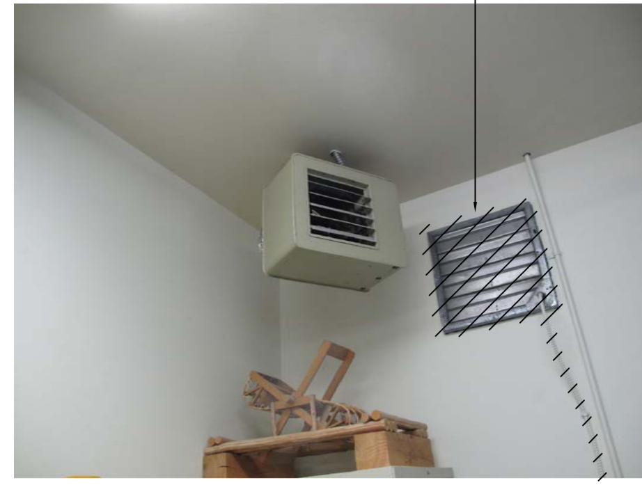
2 HATCHERY - UNIT HEATER Scale: N.T.S.
