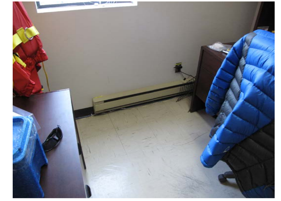
5 HATCHERY - OFFICE HEATER Scale: N.T.S.
