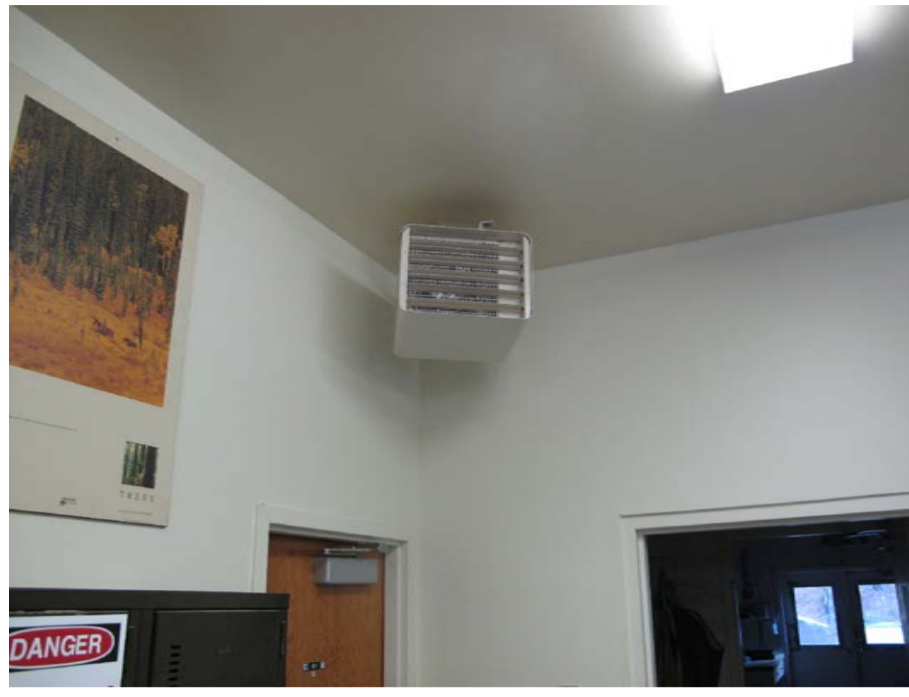
1 HATCHERY - UNIT HEATER Scale: N.T.S.
