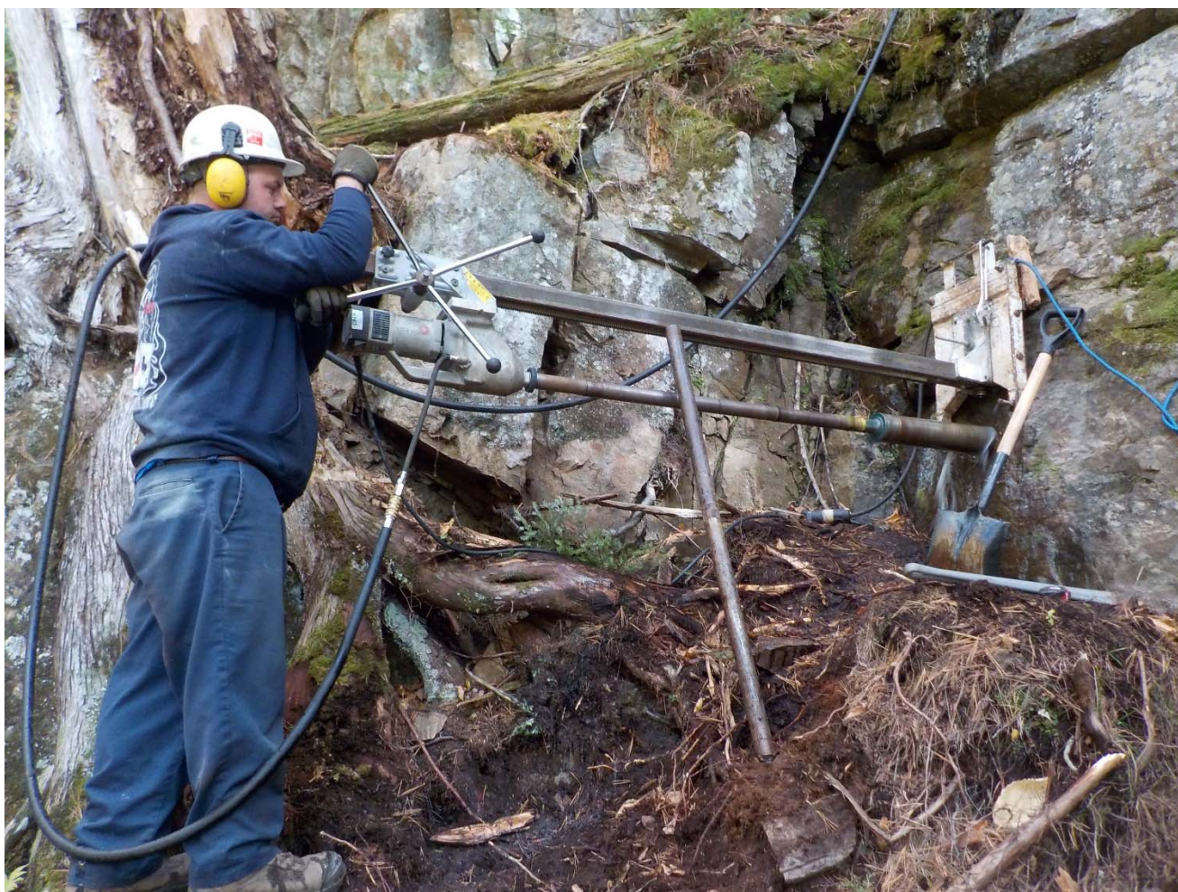
Figure 2 Réalisation d'un des forages horizontaux (TF-03-16)
