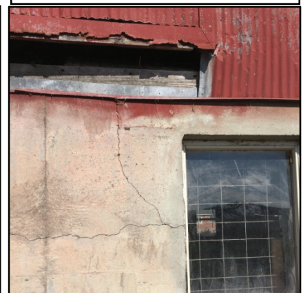
Photo 14: Contour de rive endommagé
