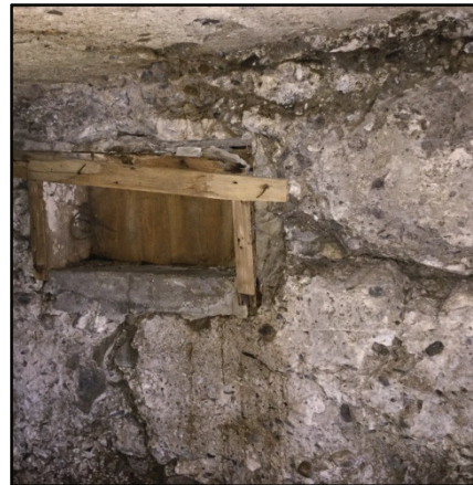
Photo 26: Détériorations du mur de fondations
