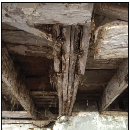
Photo 12: Dommage à l'attache
