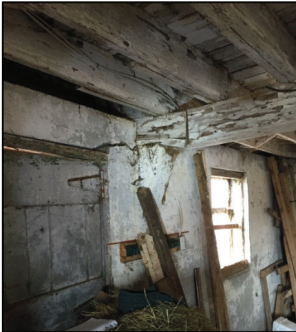
Photo 3: Mur de fondation en béton et structure de bois.
