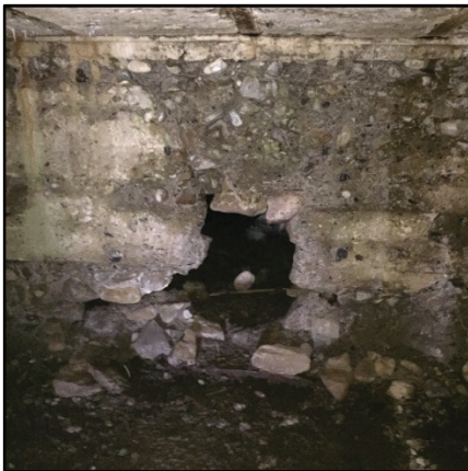
Photo 25: Effondrement du mur de béton
