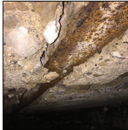
Photo 24: Aucune adhésion entre béton et acier
