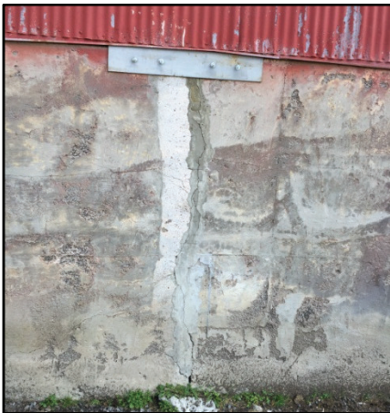
Photo 21: Réparations typique du mur
