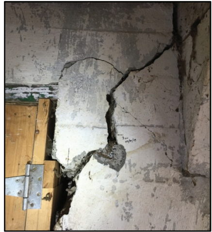
Photo 17: Fissur aux ouvertures
