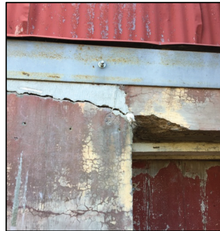
Photo22: Fissure dans le mortier de réparations
