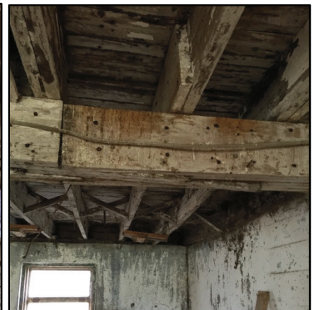
Photo 11: Support manquant à la poutre
