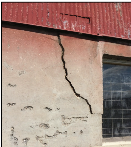
Photo 18: Fissure aux ouverture
