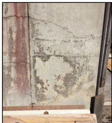
Photo 20: dommages au mur de fondations.
