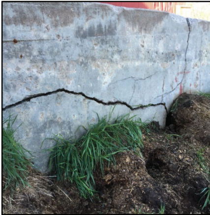
Photo 23: Fissure mur de fondations
