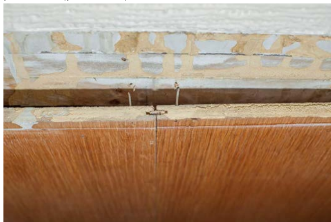
Figure 39 : Joint d'extrémité à languettes des panneaux et fixation au mur par clouage en biais (cimaise de protection enlevée).
