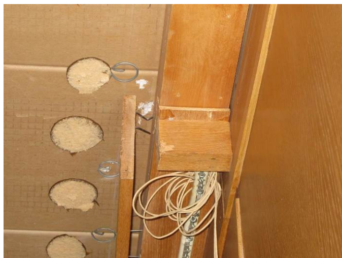
Figure 37 : Coupe transversale du logement du store à ressort de la fenêtre. Note : corniche enlevée et face avant décollée en partie. (photographie : Direction de la conservation du patrimoine, 2016)
