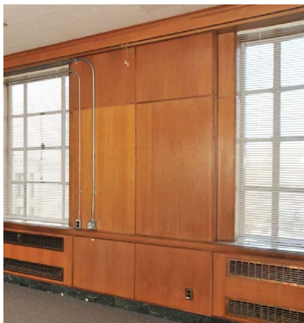
Figure 33 : Lambris sur toute la hauteur du mur sur la face intérieure du mur extérieur où sont les fenêtres. (Photographie : Direction de la conservation du patrimoine, 2016)
