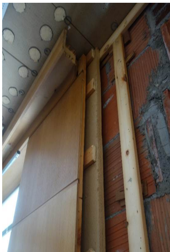
Figure 34 : Coupe transversale du mur et du logement du store à ressort de la fenêtre (corniche en bois enlevée) (Photographie : Direction de la conservation du patrimoine, 2016).
