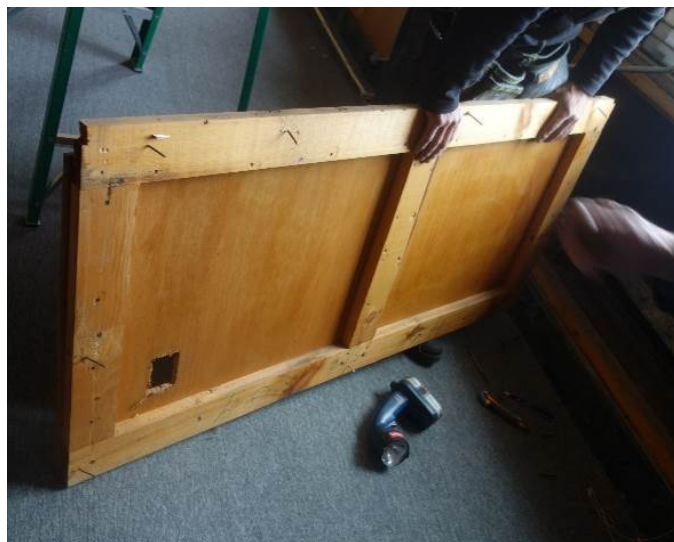
Figure 36 : Partie arrière du panneau inférieur (enlevé) illustrant l'ossature de support.
