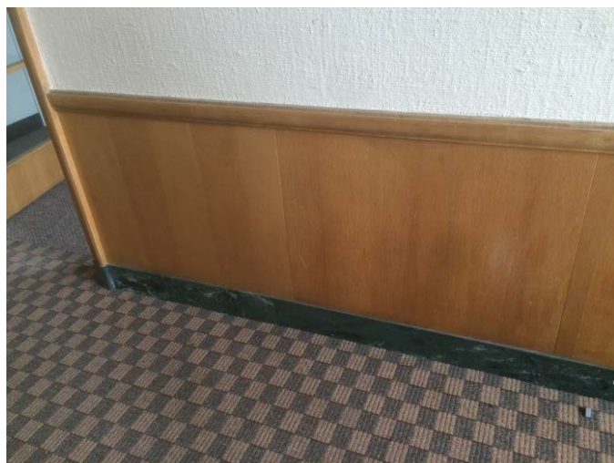
Figure 38 : Exemple de la boiserie et de la cimaise de protection (pièce 5014).
