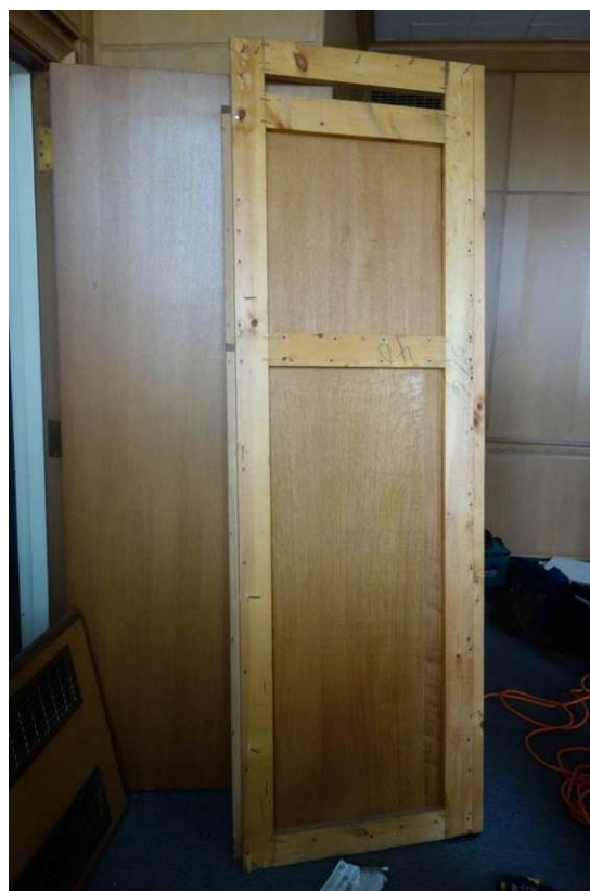
Figure 35 : Partie arrière du panneau supérieur (enlevée) illustrant l'ossature de support.
