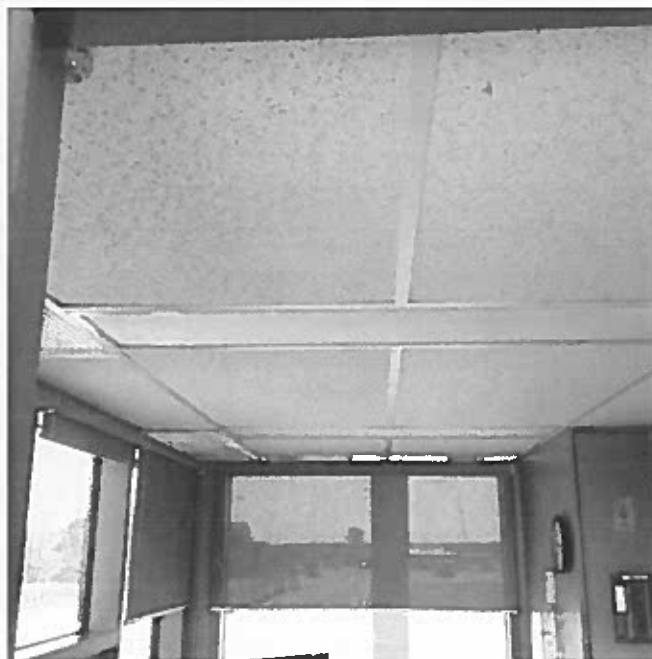
Photo 40 – Petite cabine – Rez-de-chaussée – Tuile acoustique 2'X4' avec points et petites traces, #1
