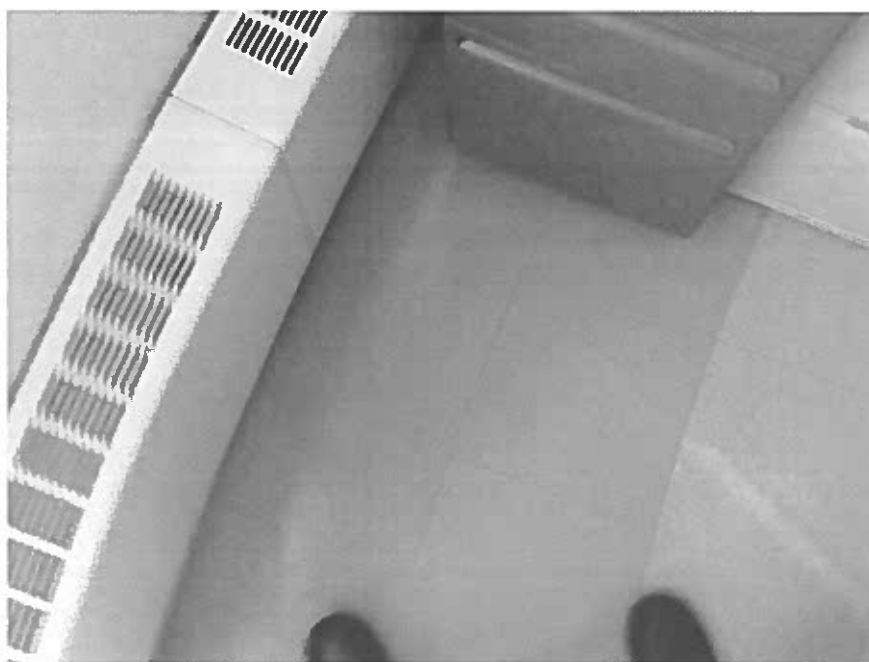
Photo 38 – Local I-211 – 2 e étage – Tuile de vinyle 1'X1' grise, sans amiante, #8
