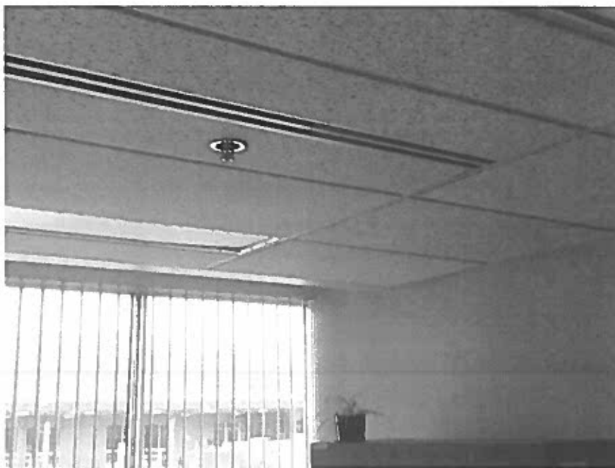
Photo 25 – Local C-124 – Rez-de-chaussée (section rénovée) – Tuile acoustique 2'X4' avec lignes et trous concentrés, sans amiante, #11
