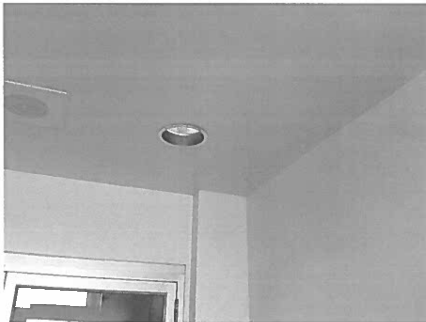
Photos 17 et 18 – Locaux C-124, C-121, C-131, C-128 – Rez-de-chaussée (section rénovée) – Composé à joint sur placoplâtre sur mur et plafond, sans amiante, #6-A à 6-I
