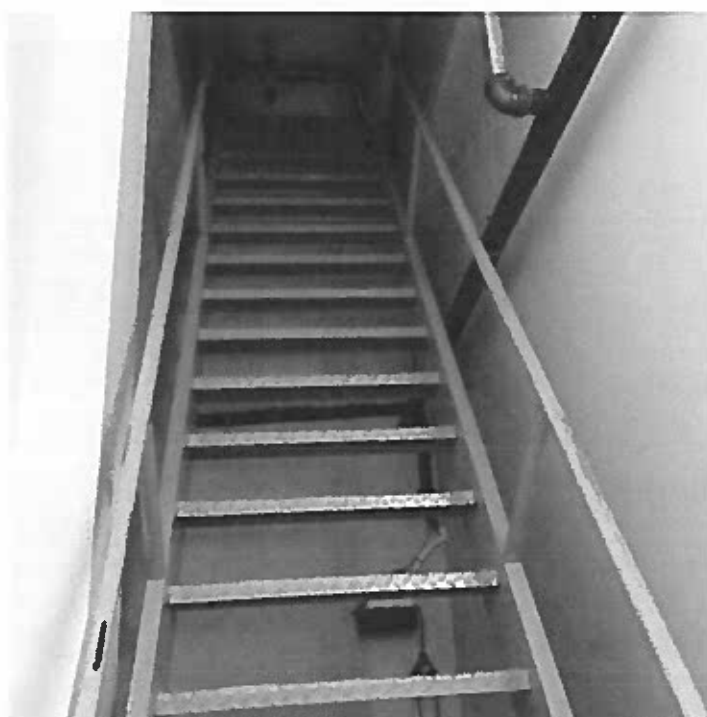
Photo 68 – RDC – Escalier métallique recouvert d'une peinture grise au plomb (échantillon P-9)
