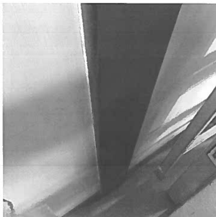
Photo 73 – 2 e étage, salle mécanique – Colonne métallique recouverte d'une peinture rouge (échantillon P-3)
