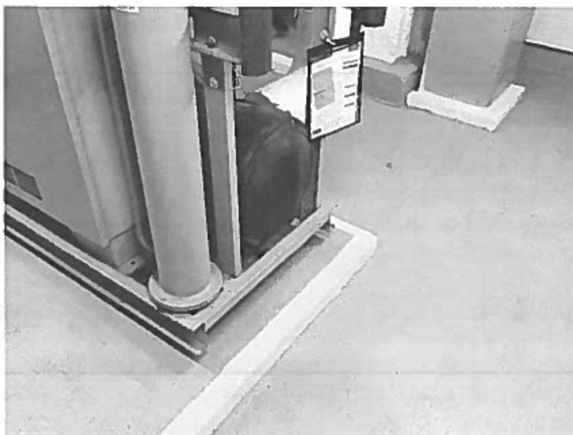
Photo 61 – Sous-sol, Salle mécanique – Plancher recouvert d'une peinture jaune et une peinture grise (échantillon P-2)
