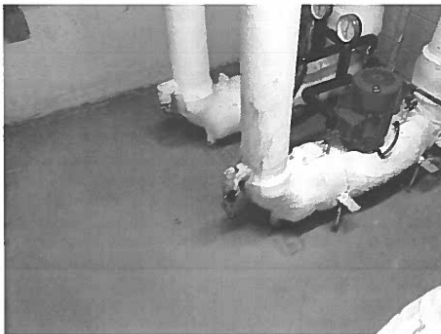
Photo 95 – C-001 - Rez-de-chaussée – Isolant sans contamination fongique (échantillon VR-1)
