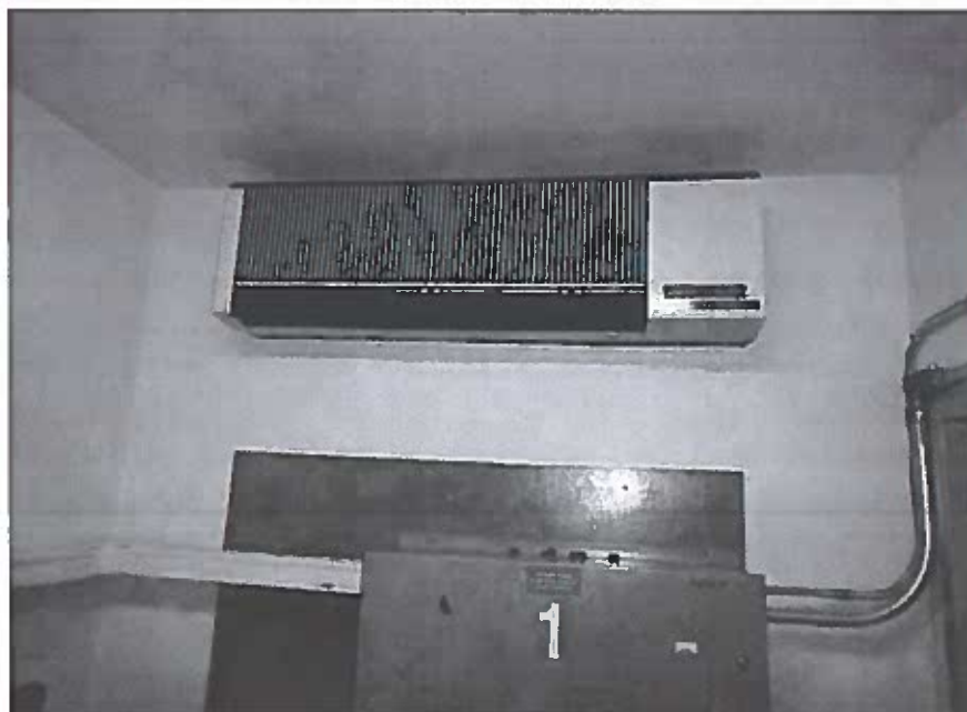
Photo 91 – Unité de condensation de type « split » contenant un réfrigérant de type R-22, un halocarbure
