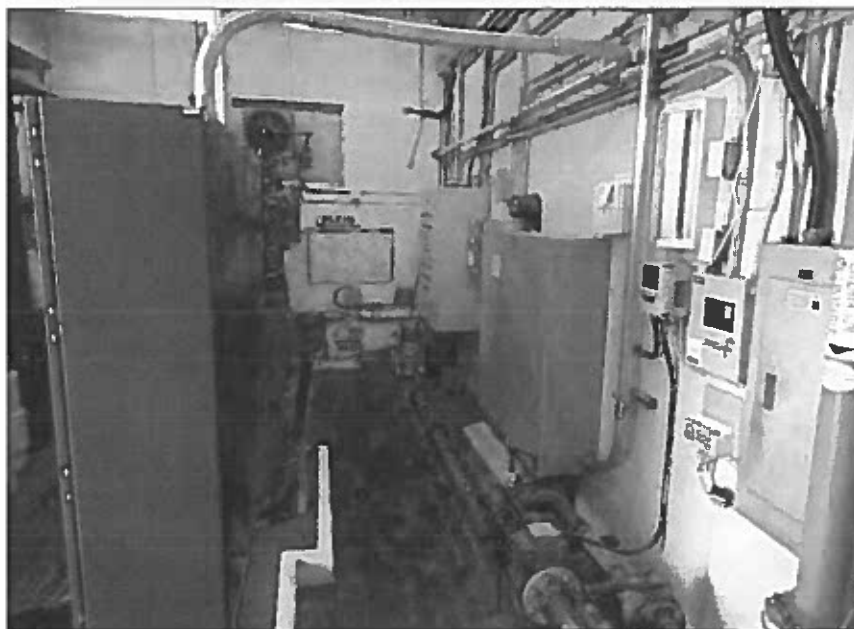
Photo 50 – Mur derrière les compresseurs recouvert de peinture au plomb (échantillon no. 04)
