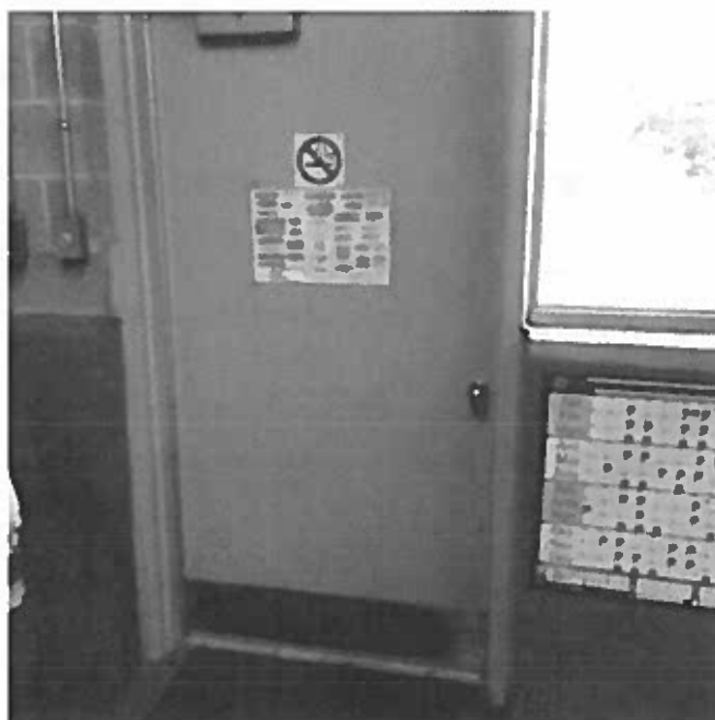
Photo 57 – Porte et cadrage métallique recouverts d'une peinture grise au plomb (échantillon P-1)
