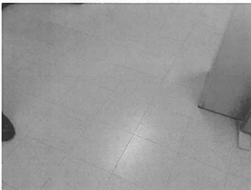
Photo 36 – Local I-201 – 2 e étage – Tuile de vinyle 1'X1' blanche avec points noirs, sans amiante, #6
