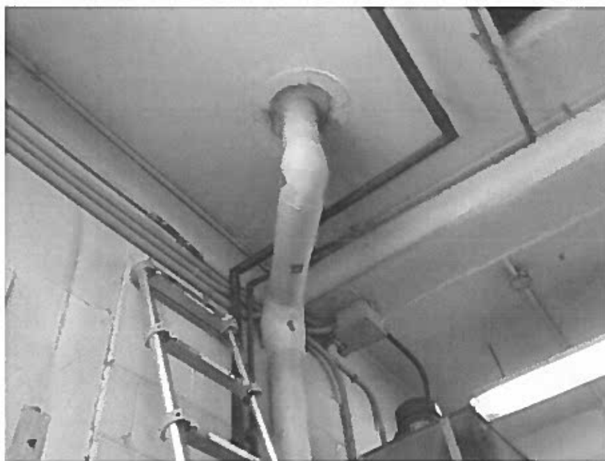
Photo 2 – Rez-de-chaussée – Isolant sur sections régulières et irrégulières de tuyauterie, sans amiante, #1-A, 1-B, 1-C
