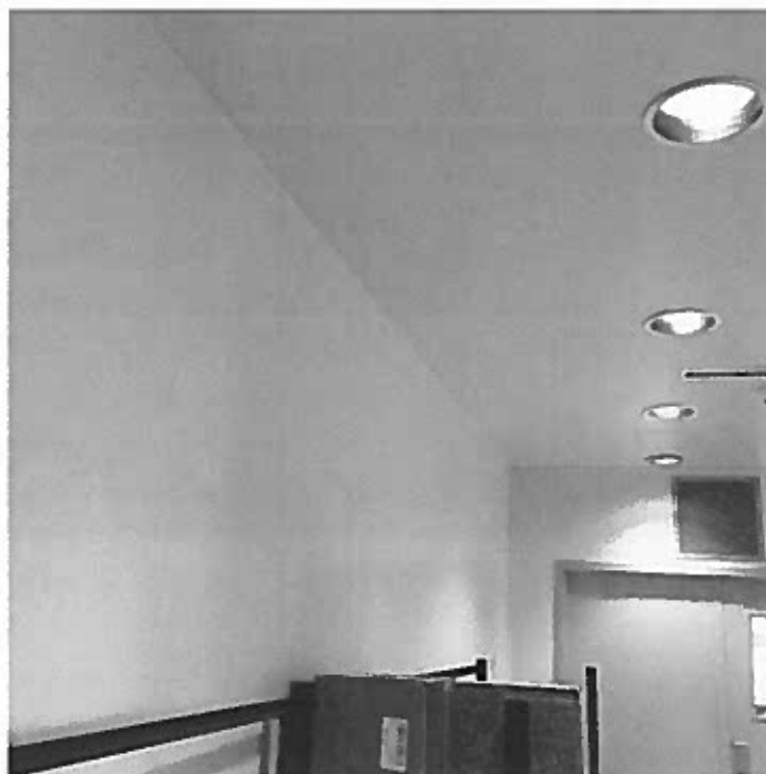
Photo 67 – RDC – Mur et plafond en placoplâtre recouvert d'une peinture blanche (échantillon P-8)
