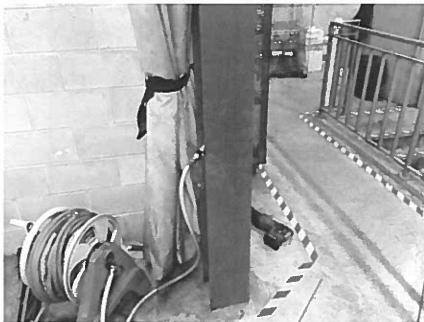
Photo 63 – Sous-sol, garage – Colonne métallique recouverte d'une peinture rouge au plomb (échantillon P-4)
