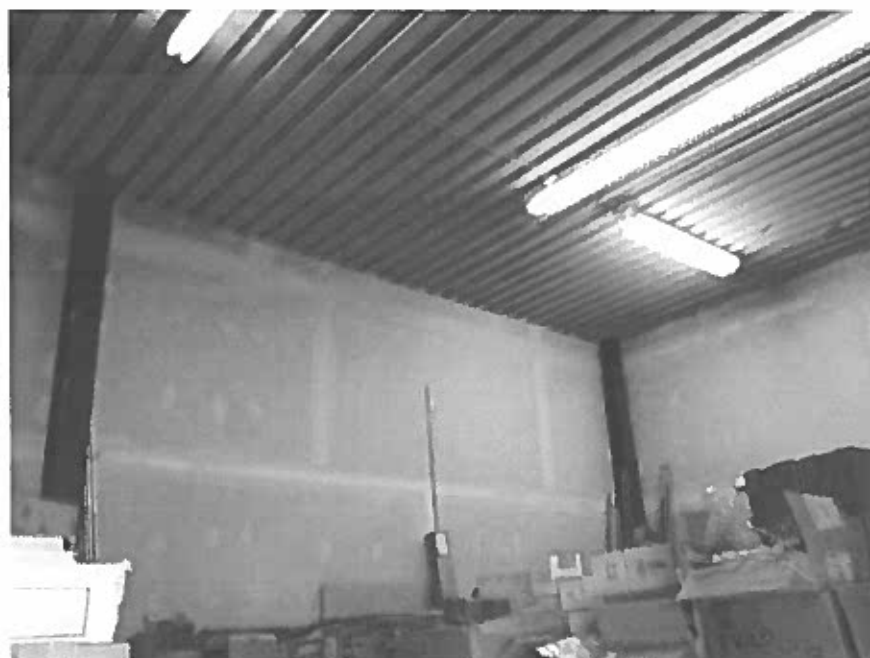
Photo 46 – Bâtiment – Rez-de-chaussée – Composé à joint sur placoplâtre sur mur, sans amiante, #4-A à 4-C
