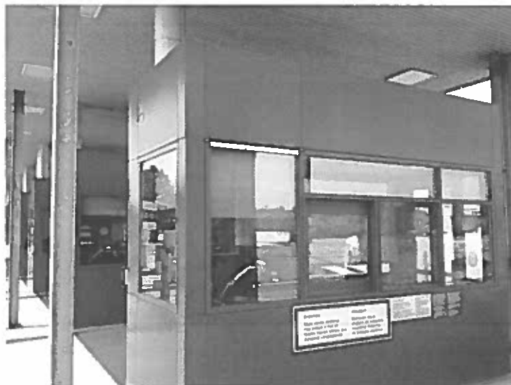
Photo 80 – Extérieur – Mur de plastique recouvert d'une peinture grise (échantillon 08)
