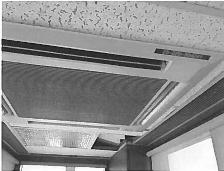
Photo 43 – Petite cabine – Rez-de-chaussée – Tuile acoustique 2'X4' avec lignes et trous, #1
