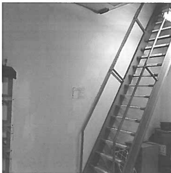
Photo 74 – 2 e étage, salle mécanique – Mur en placoplâtre recouvert d'une peinture blanche (échantillon P-4)
