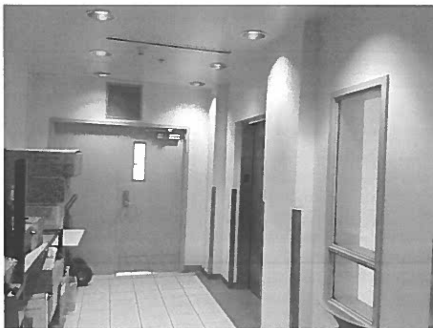
Photo 21 – Locaux C-147, C-141, C-125, C-137, cage d'escalier – Rez-de-chaussée (section ajoutée Terminus d'autobus) – Composé à joint sur placoplâtre sur mur et plafond, sans amiante, #7-B à 7-F
