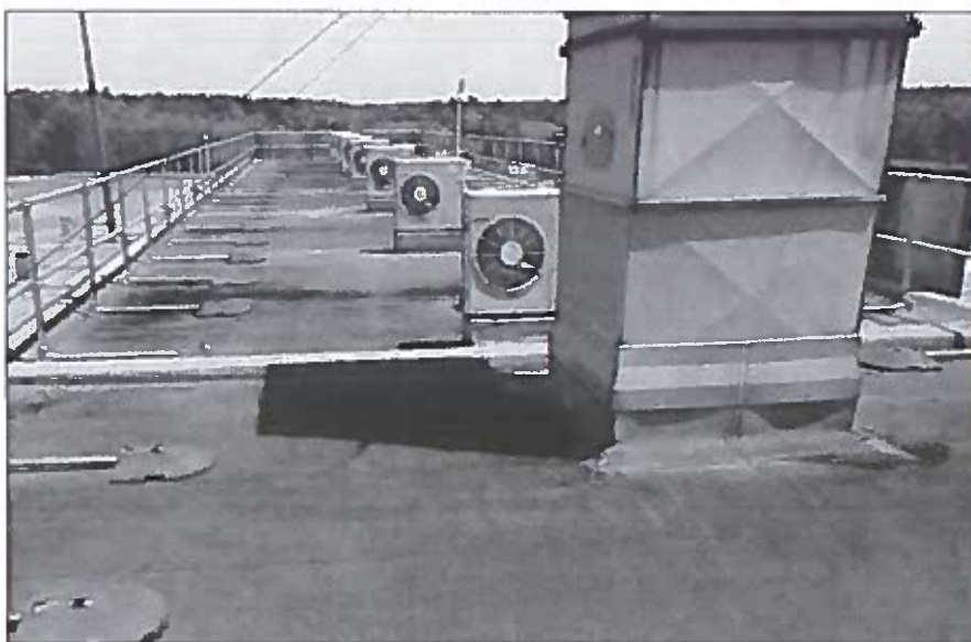
Photo 98 – Toit du bâtiment – Unités de condensation individuelles contenant des halocarbures
