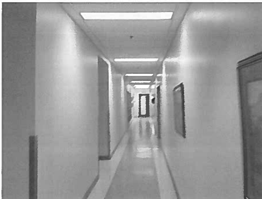
Photo 35 – Local I-209 – 2 e étage – Tuile de vinyle 1'X1' grise avec points bleus, sans amiante, #5
