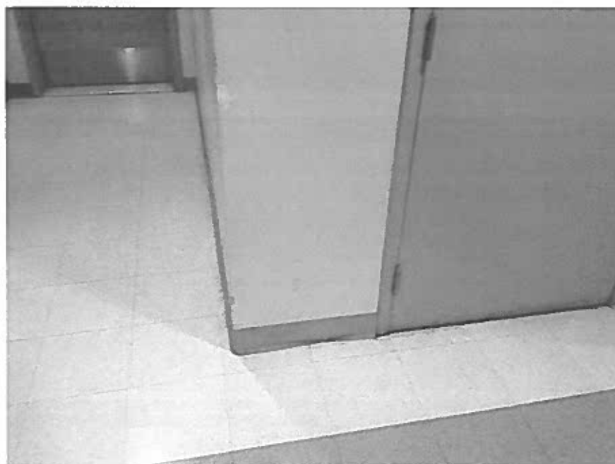
Photo 14 – Local C-019 – Sous-sol (section ajoutée et quais) – Tuile de vinyle 1'X1' blanche avec points noirs, sans amiante, #5
