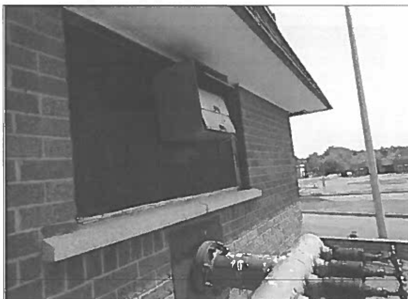
Photo 89 – Présence d'un nid d'oiseaux occupé dans la prise d'air. Présence probable de fiente d'oiseaux
