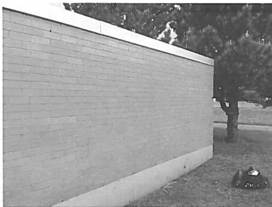
Photo 26 – Extérieur – Rez-de-chaussée – Crépi cimentaire, sans amiante, #12-A à 12-C
