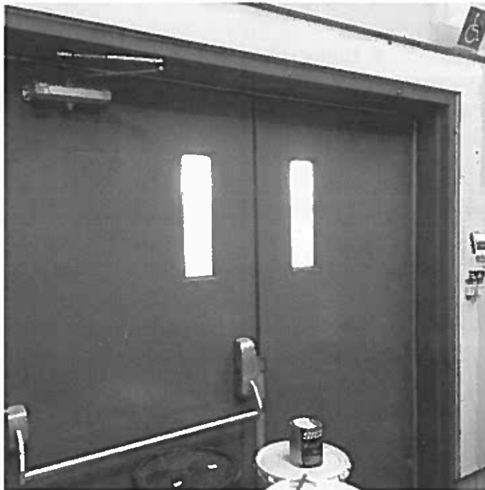
Photo 86 – Porte et cadrage métallique recouvert d'une peinture mauve au plomb (échantillon P-8)
