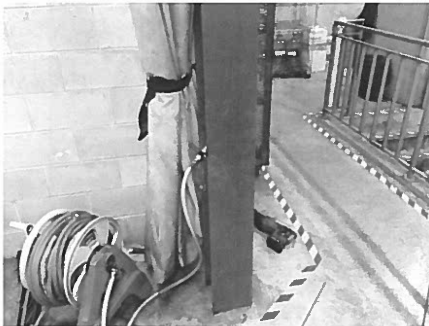
Photo 63 – Sous-sol, garage – Colonne métallique recouverte d'une peinture rouge au plomb (échantillon P-4)
