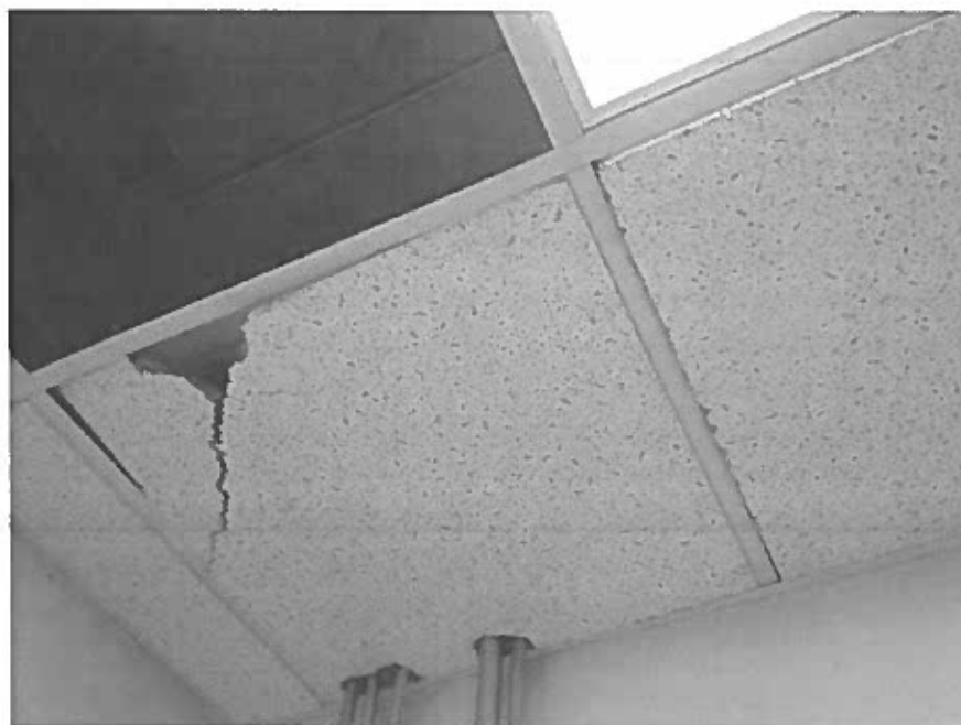
Photo 9 – Local C-019 – Sous-sol (section ajoutée) – Tuile acoustique 2'X4' avec lignes et trous, sans amiante, #1
