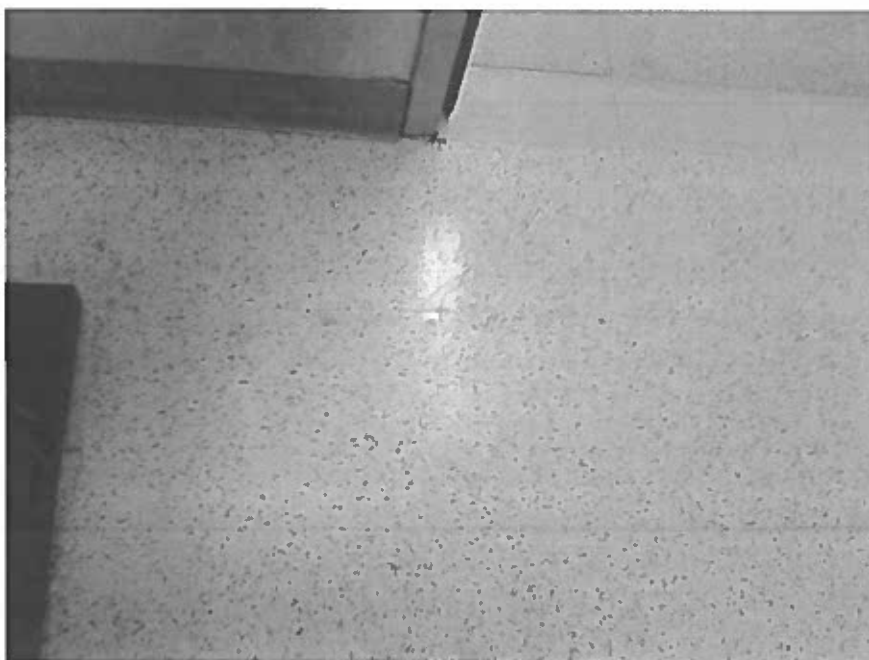
Photo 37 – Local I-221 – 2 e étage – Tuile de vinyle 1'X1' blanche avec taches bleues, sans amiante, #7
