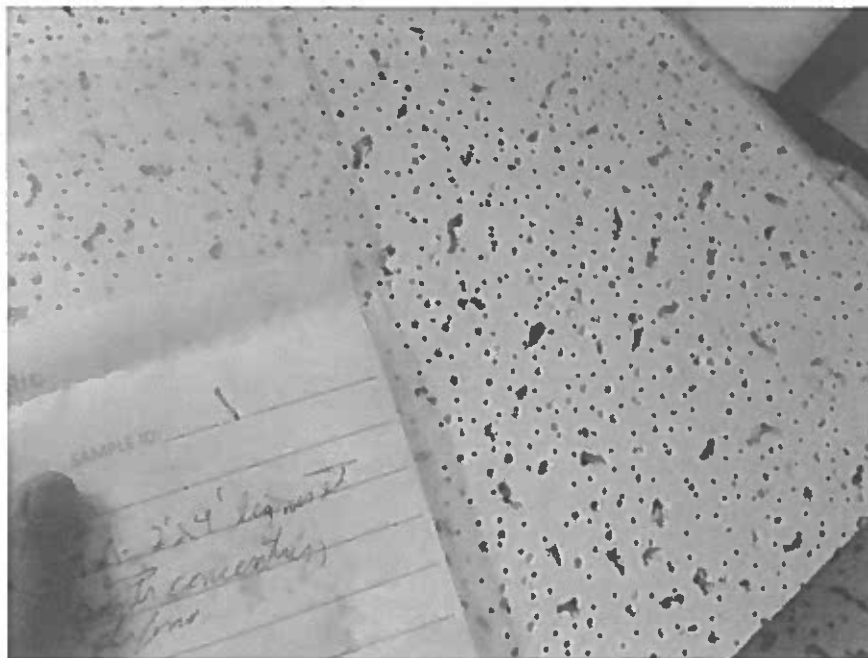
Photo 30 – Local I-222 – 2 e étage – Tuile acoustique 2'X4' avec lignes et points concentrés (entposée), sans amiante, #1
