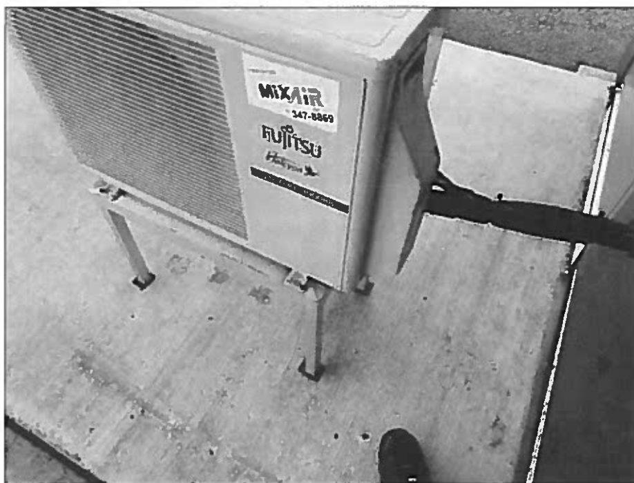
Photo 97 – Toit du bâtiment – Unité de condensation de type « split » contenant un réfrigérant de type R-410A, un halocarbure
