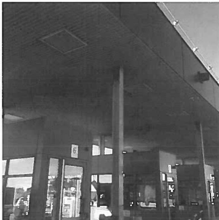
Photo 83 – Extérieur – Colonne métallique recouverte d'une peinture grise au plomb (échantillon P-5)
