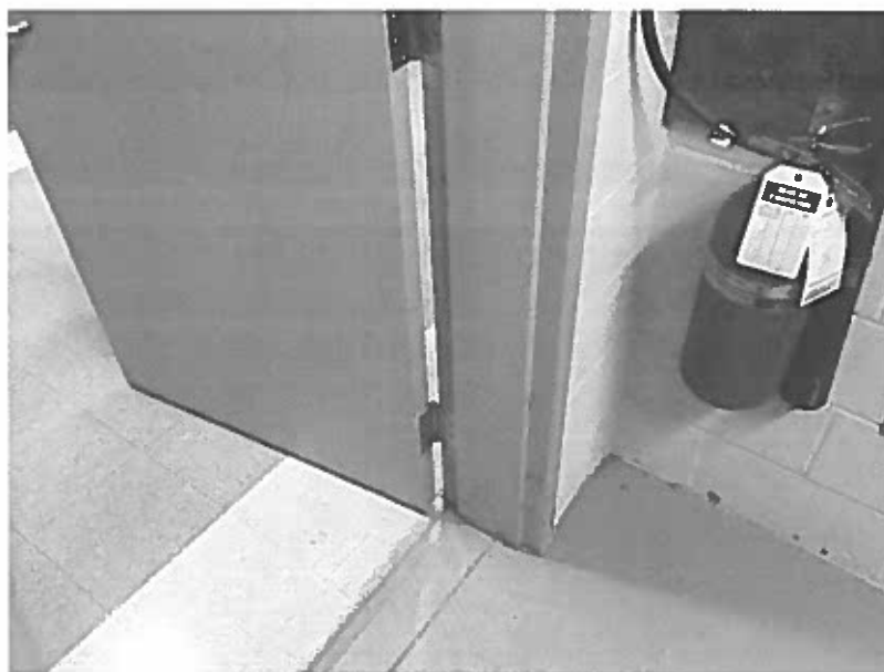
Photo 62 – Sous-sol, Corridor – Portes et cadrages métalliques recouverts d'une peinture grise (échantillon P-3)
