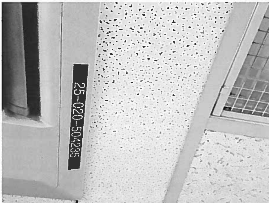
Photo 44 – Petite cabine – Rez-de-chaussée – Tuile acoustique 2'X4' avec lignes et petits trous, #2
