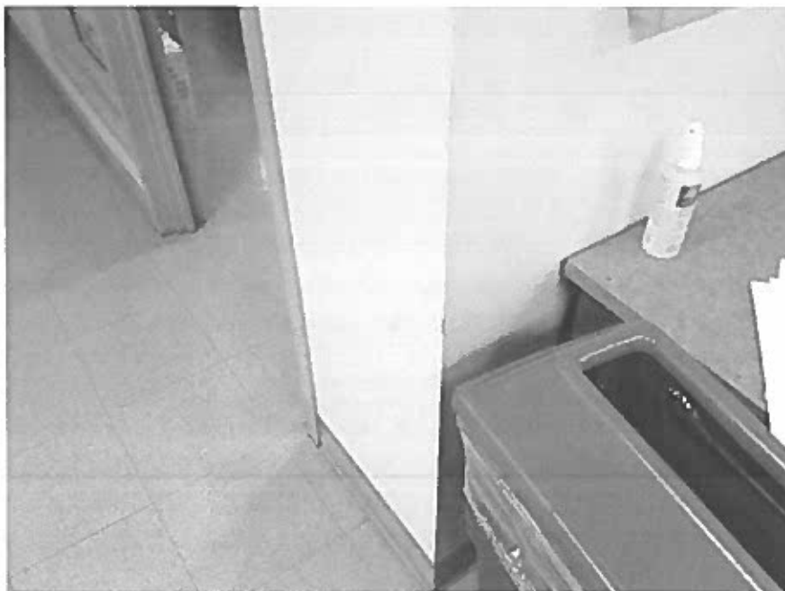
Photo 13 – Local C-019 – Sous-sol (section ajoutée et quais) – Tuile de vinyle 1'X1' grise avec points bleus, sans amiante, #4
