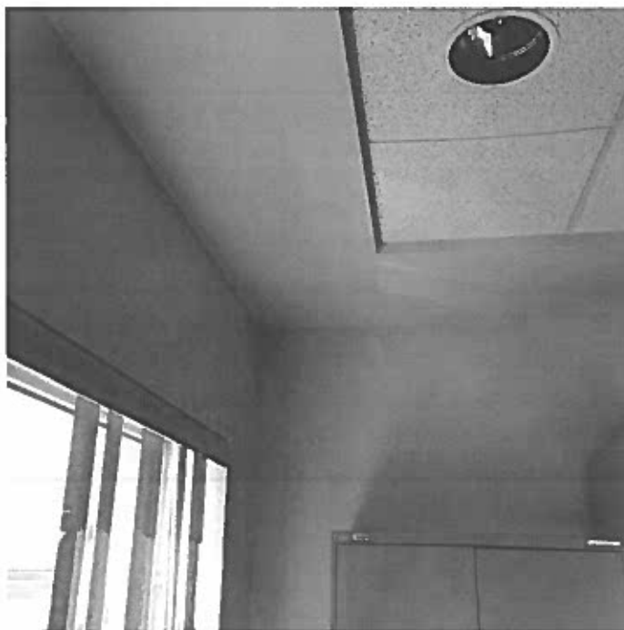
Photo 77 – 2 e étage, salle à diner – Mur en placoplâtre recouvert d'une peinture grise (échantillon P-7)
