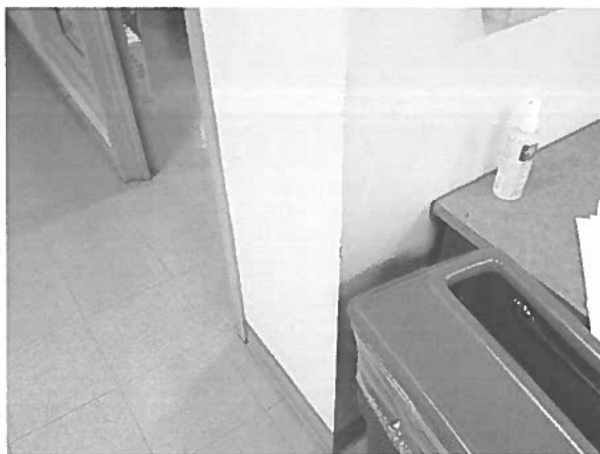
Photo 34 – Local C-019 – Sous-sol (section ajoutée et quais) – Tuile de vinyle 1'X1' grise avec points bleus, sans amiante, #4
