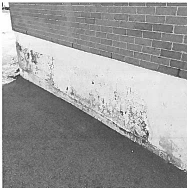
Photo 51 – Extérieur – Fondation de béton recouverte d'une peinture blanche (échantillon no. 03) et bleue pâle, (échantillon P-1)
