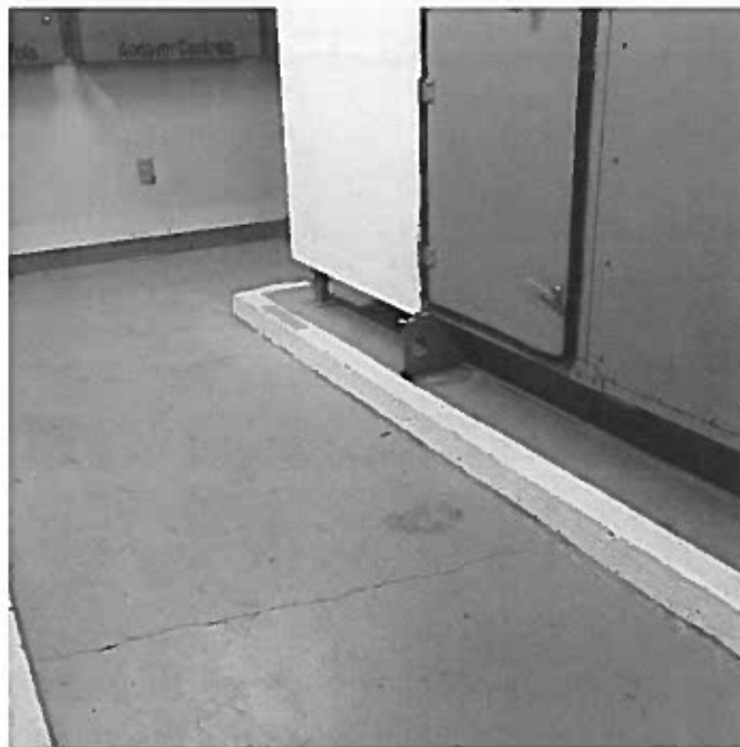
Photo 71 – 2 e étage, salle mécanique – Plancher de béton recouvert d'une peinture jaune et grise (échantillon P-1 et P-2)
