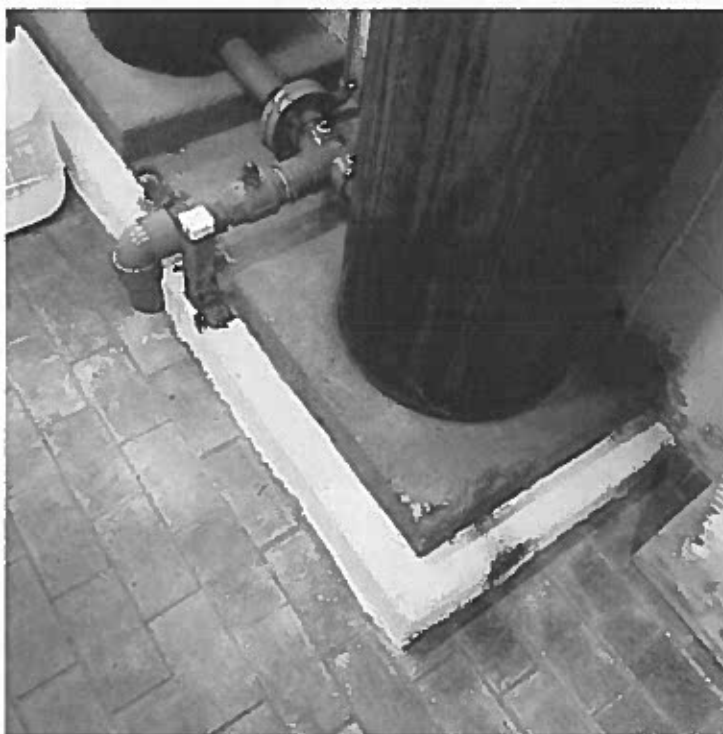
Photo 53 – Les dalles de bétons au plancher sont recouvertes d'une peinture jaune (échantillon P-3) et grise foncée (échantillon P-4)
