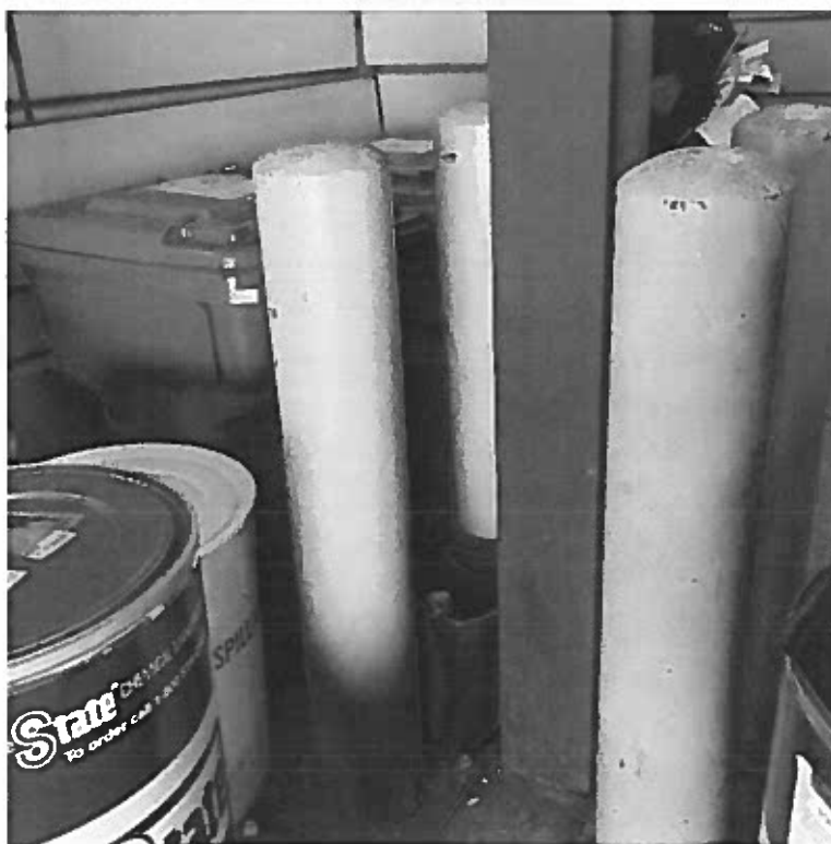
Photo 64 – Sous-sol, garage – Poteau métallique recouvert d'une peinture jaune-orange au plomb (échantillon P-5)
