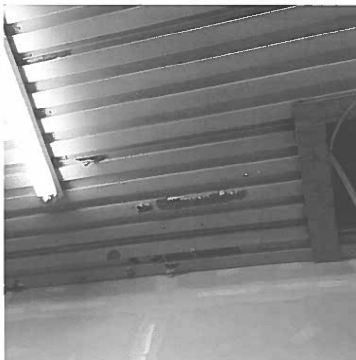
Photo 85 – Plafond métallique recouvert d'une peinture beige au plomb (échantillon P-7)
