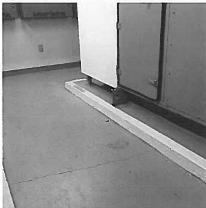
Photo 72 – 2 e étage, salle mécanique – Plancher de béton recouvert d'une peinture jaune (échantillon P-1) et grise (échantillon 01 et P-2)
