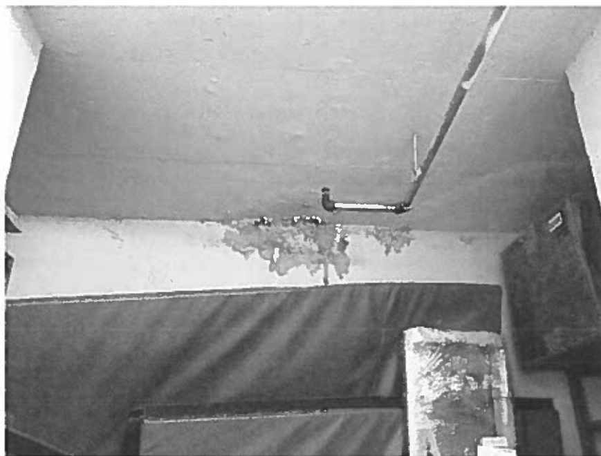
Photo 94 – C-005 – Sous-sol – Peinture sur le béton sans contamination fongique
