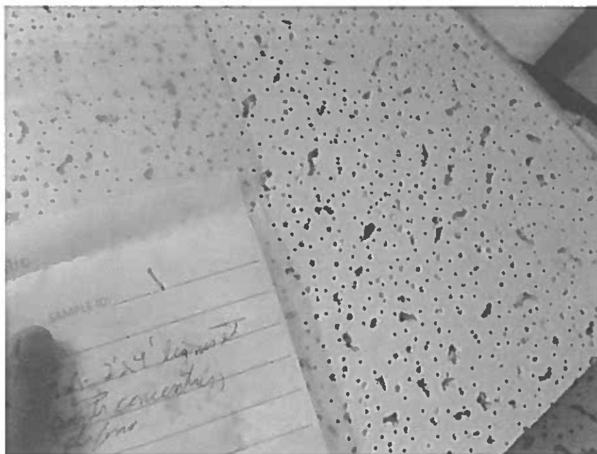
Photo 30 – Local I-222 – 2 e étage – Tuile acoustique 2'X4' avec lignes et points concentrés (entrepasée), sans amiante, #1
