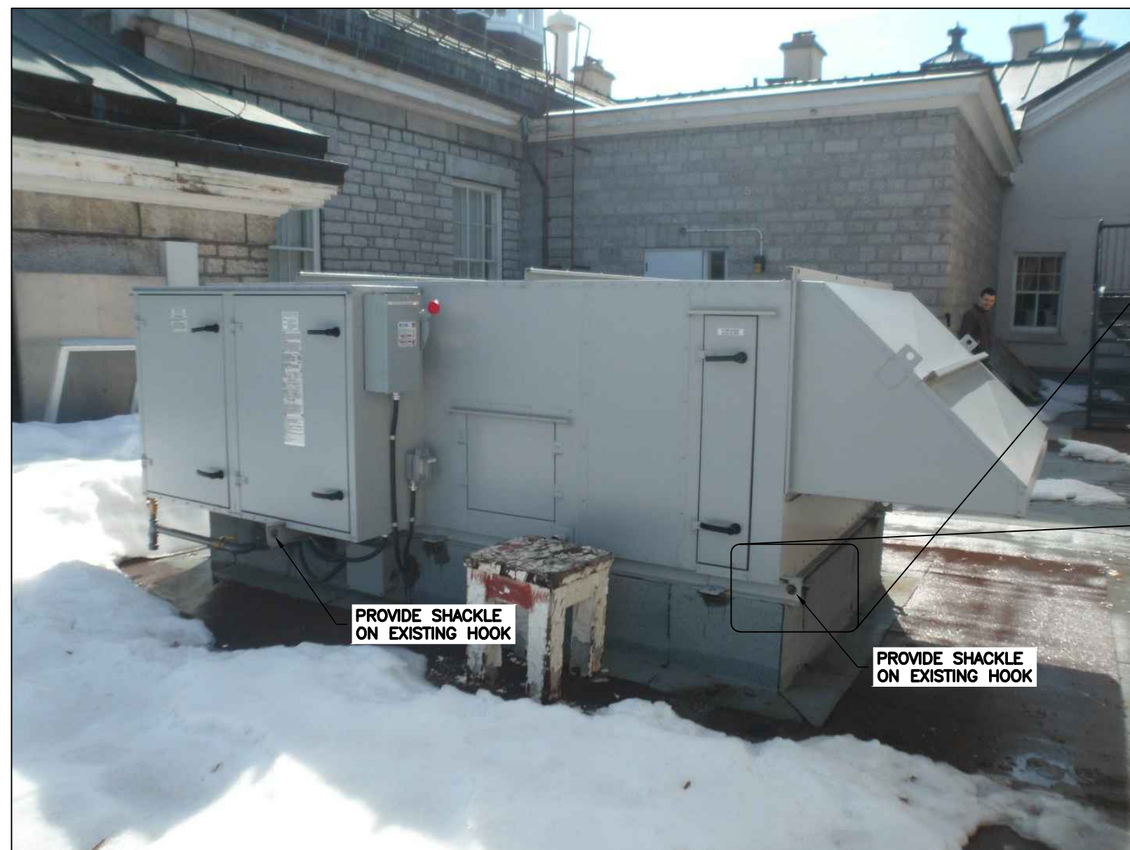
2 ROOF TOP UNIT ANCHORS N.T.S.
