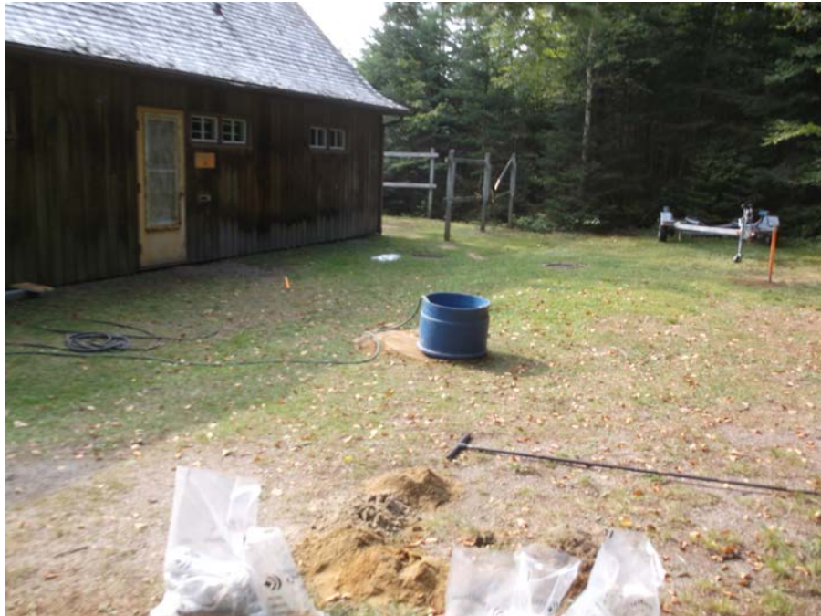
Photo 3 : Vue d'ensemble du site 6-2.
