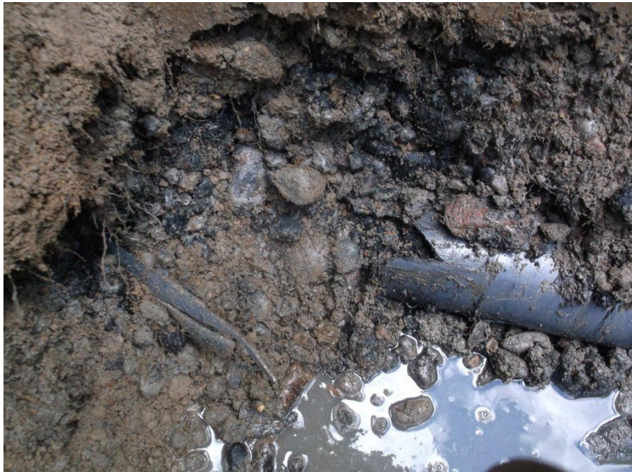
Photo 1 : Site 19-2 - Sondage S-19-2-3
