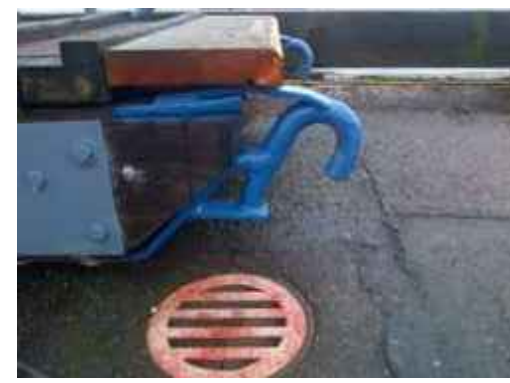
EXISTING GANGWAY HINGE DETAIL
