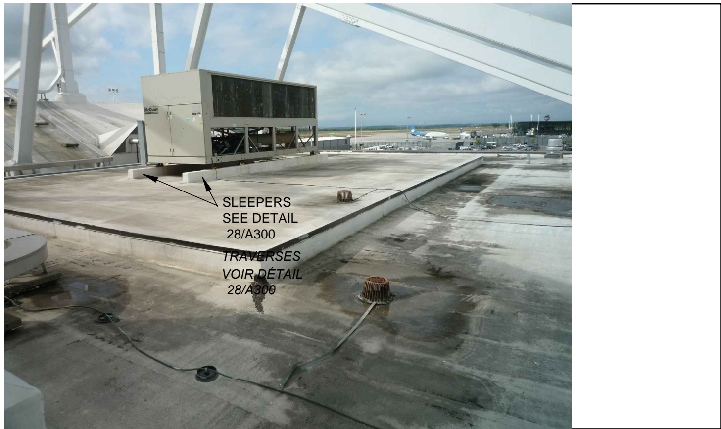
RAISED CHILLER PLATFORM A105/NTS PLATEFORME SURÉLEVÉE REFRIGÉRISSEUR
