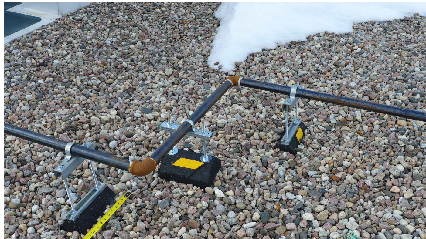
15 PHOTO OF GAS LINE SUPPORTS A115/NTS SUPPORTS POUR CONDUITS DE GAZ
