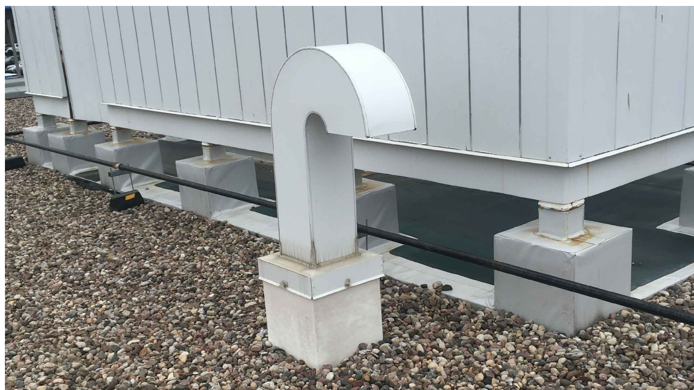
21 PHOTO OF GOOSENECK EXHAUST A115/NTS CONDUIT EN COL DE CYGNE
