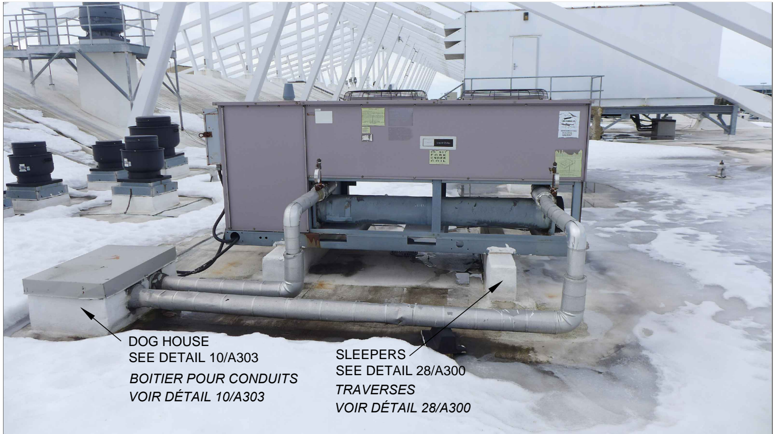
LIQUID CHILLER A105/NTS REFRIGÉRISSEUR DE LIQUIDES
