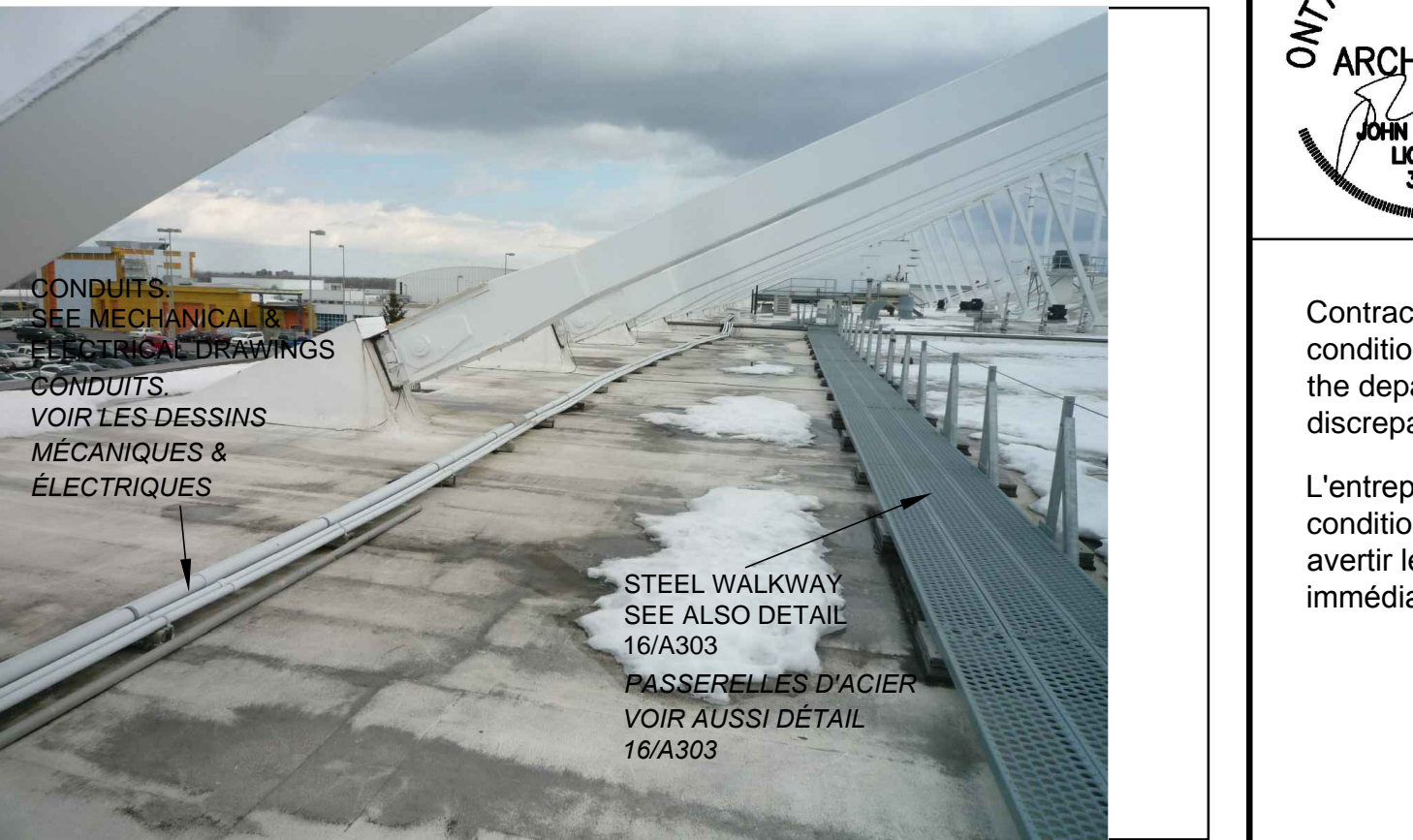
CONDUITS & STEEL WALKWAYS A105/NTS CONDUITS ET PASSERELLE D'ACIER
