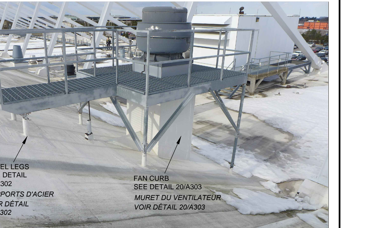
EXHAUST FAN & PLATFORM A105/NTS VENTILATEUR D'EXTRACTION ET PLATEFORME
