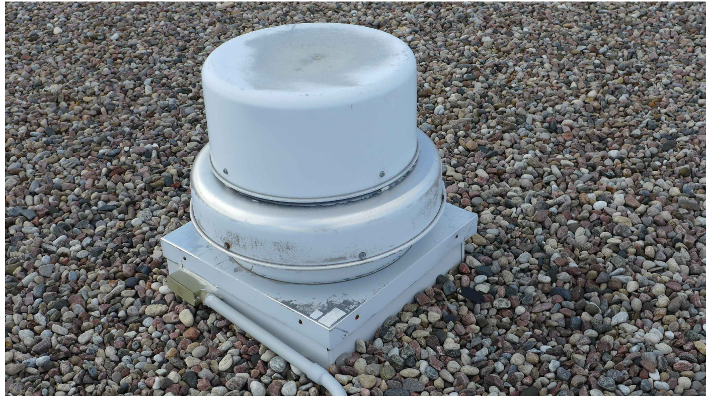
16 PHOTO OF EXHAUST FAN A115/NTS VENTILATEUR D'EXTRACTION
