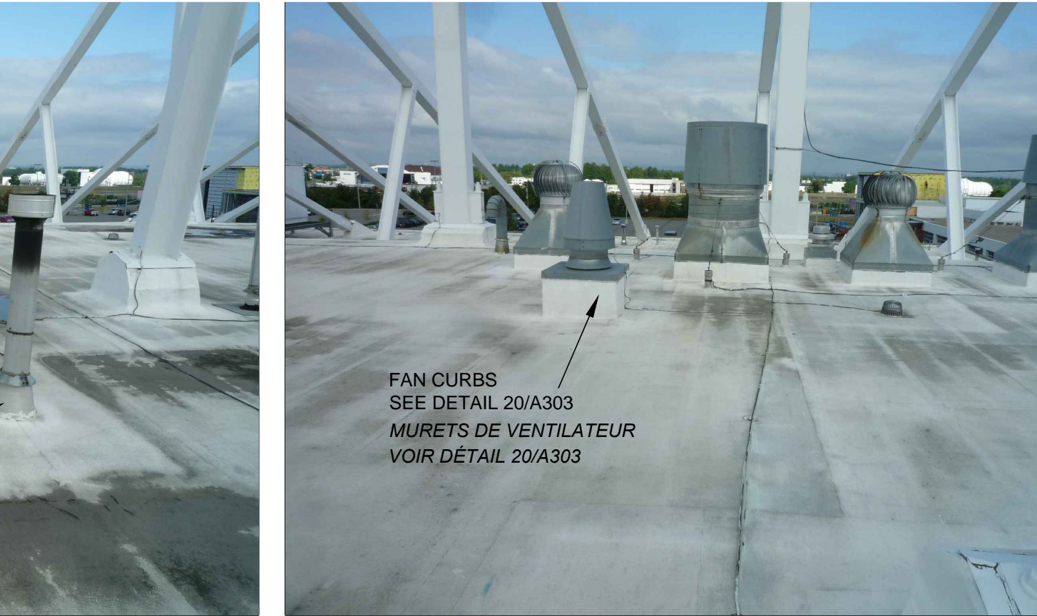
EXHAUST FANS & GUY WIRE ANCHORS A105/NTS VENT. D'EXTRACTION & ANCRAGE D'HAUBAN
