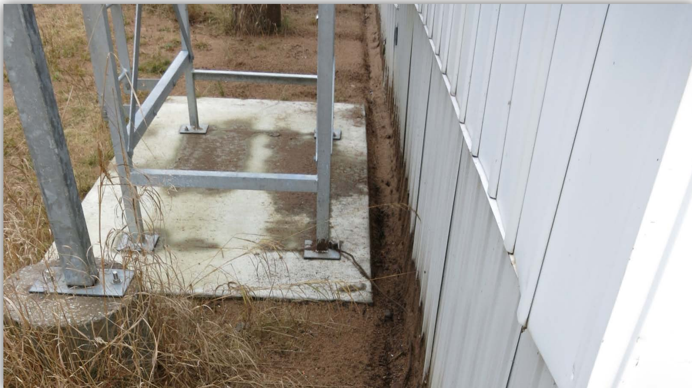
Photo 8 : Fondation du support du réservoir de diésel
