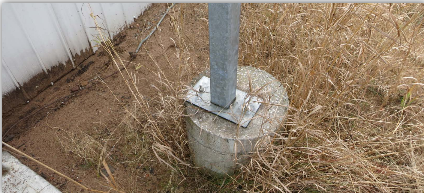
Photo 9 : Fondation du pare-glace de l'abri de la Garde côtière canadienne
