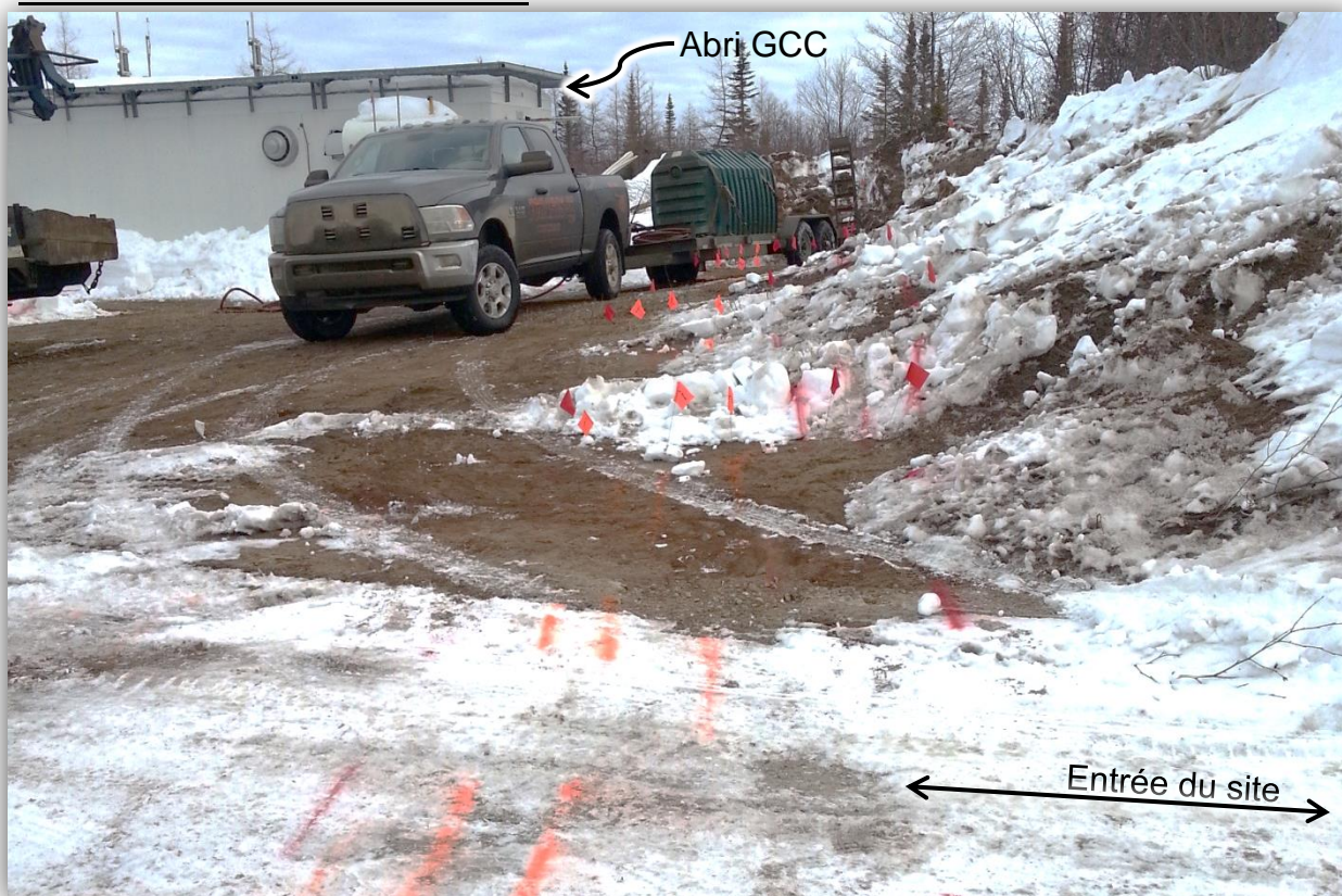
Photo 10 : Marquage temporaire de câbles souterrains
