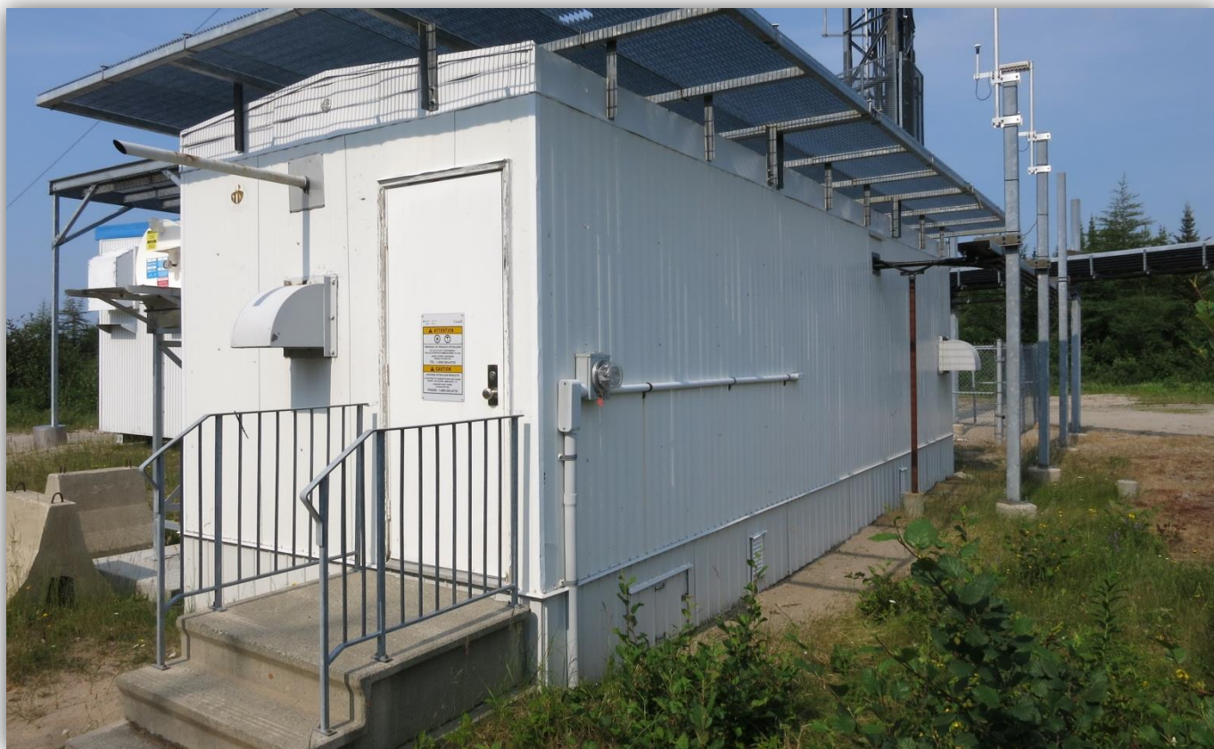
Photo 6 : Entrée électrique souterraine et chemin de câble aérien de l'abri existant
