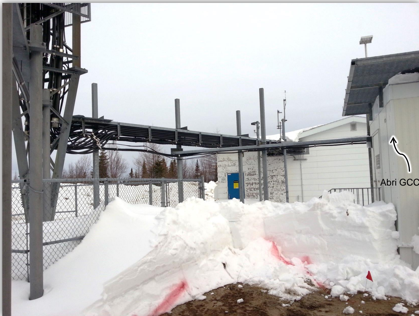
Photo 13 : Marquage temporaire de câbles souterrains
