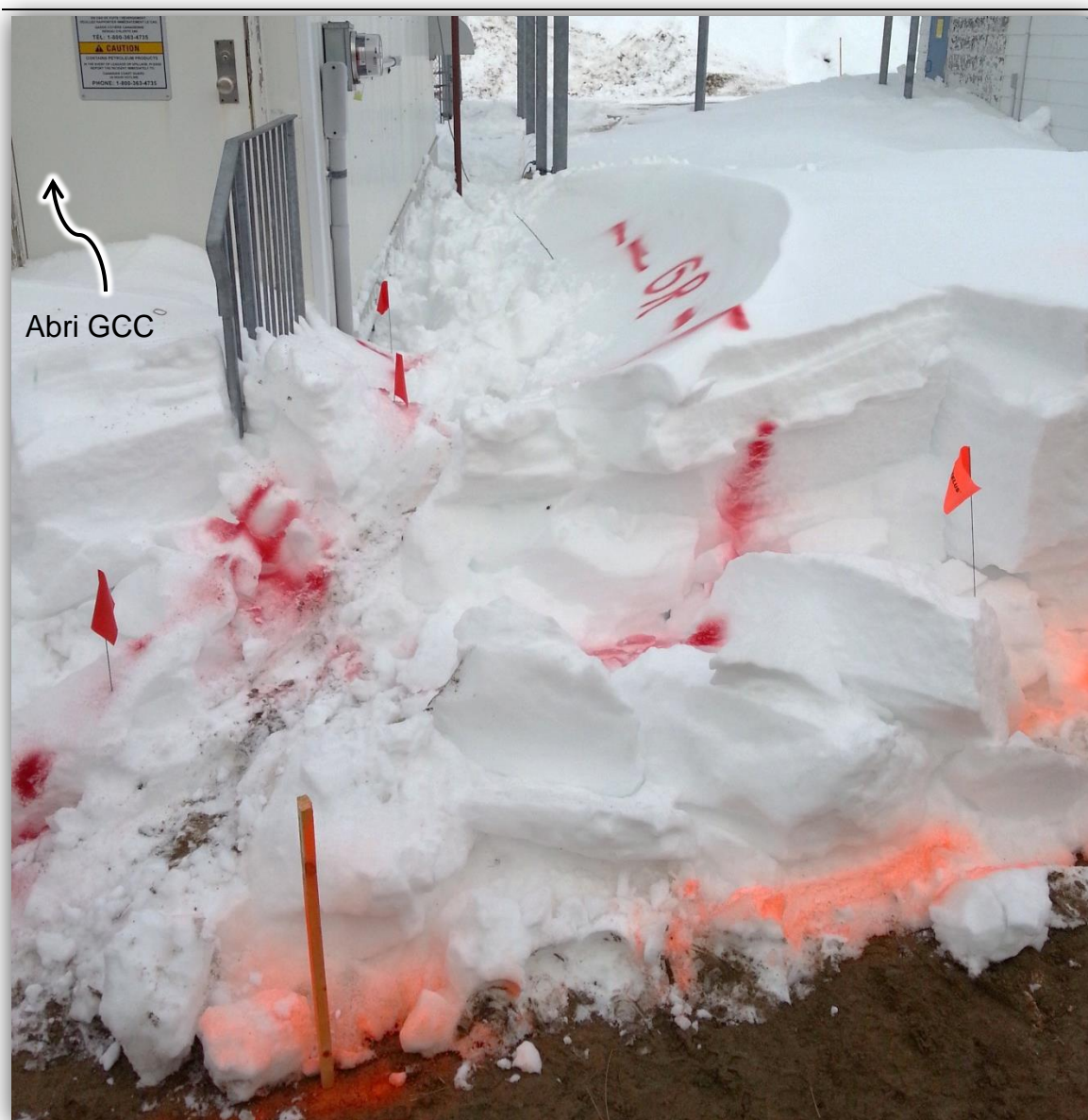
Photo 12 : Marquage temporaire de câbles souterrains
