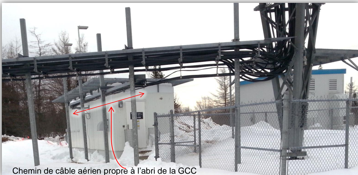
Photo 7 : Chemin de câble aérien de l'abri existant
