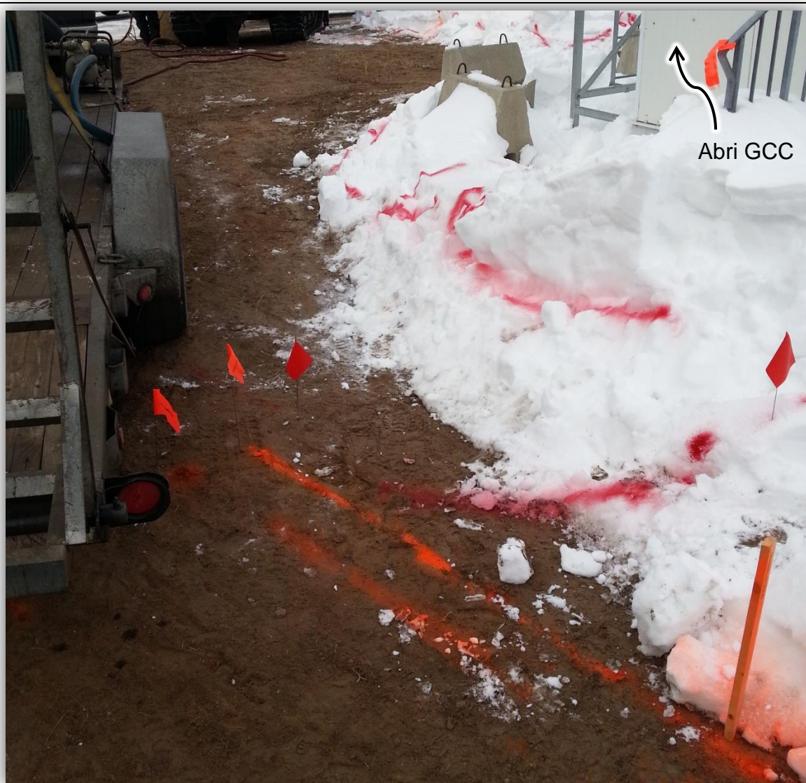
Photo 11 : Marquage temporaire de câbles souterrains
