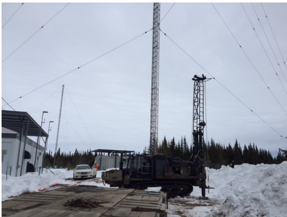
Photo 1 – Foreuse installée sur le forage F-1
