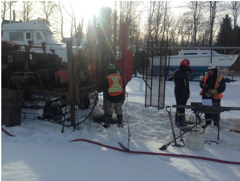
Photo 7 – Emplacement du forage F-3
