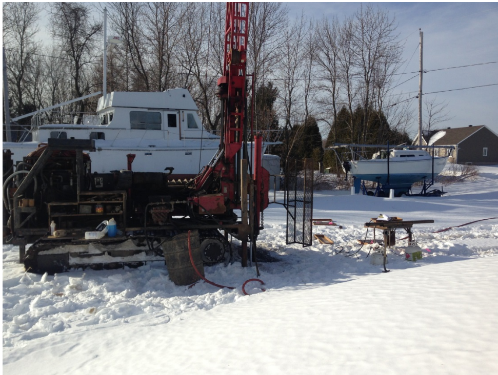
Photo 3 – Emplacement du forage F-1
