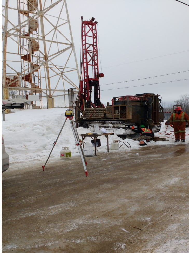
Photo 6 – Emplacement du forage F-2
