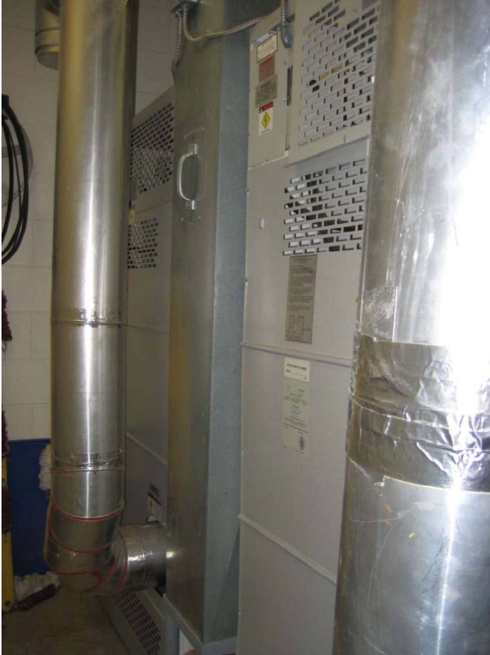
Le retour des deux séchoirs. Cette photo montre la 20,32 cm (8 po) de diamètre de ventilation utilisé.
