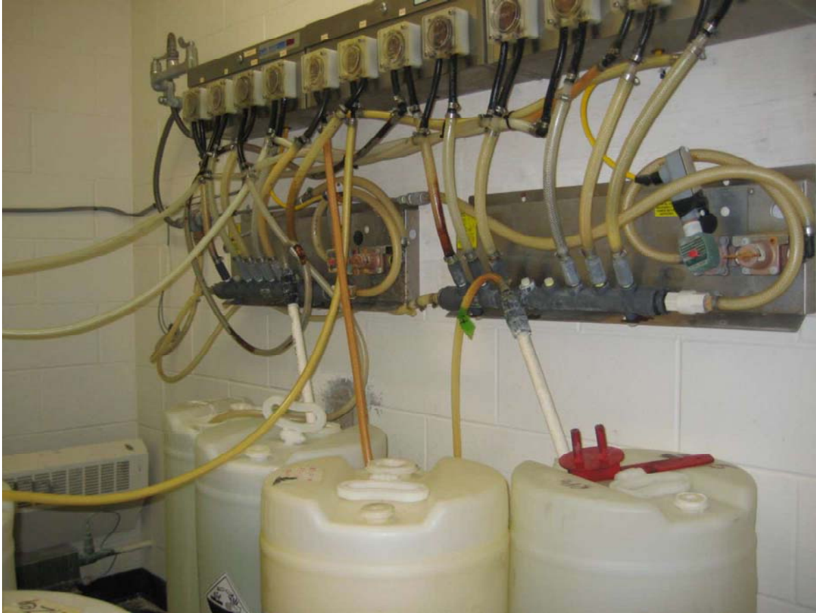
Photo de la plus humide du système de distribution Knight MPL-1000, Knight TRAC II - Contrôleur PLC.
