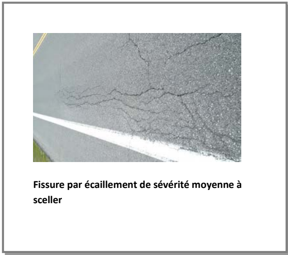
Fig. 3&4: Type de fissures observées sur la promenade Aviation
