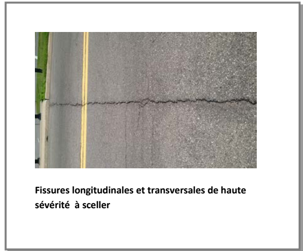
Fig. 3&4: Type de fissures observées sur la promenade Aviation
