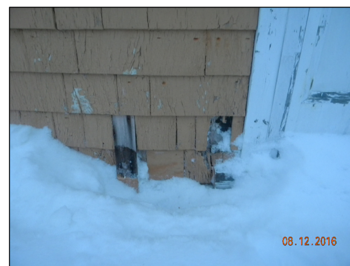
PHOTO 2 - PAREMENT DE BARDEAU DE CÈDRE
