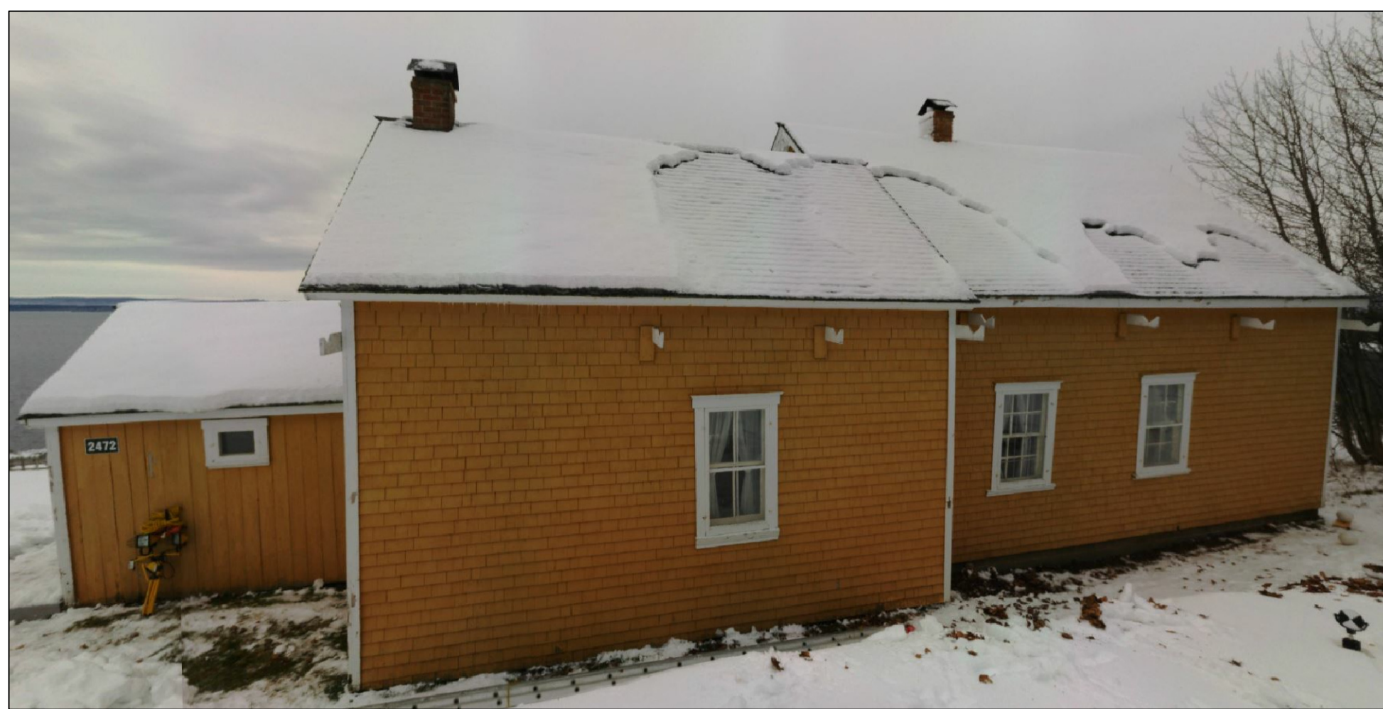
ÉLÉVATION ARRIÈRE - PHOTO
