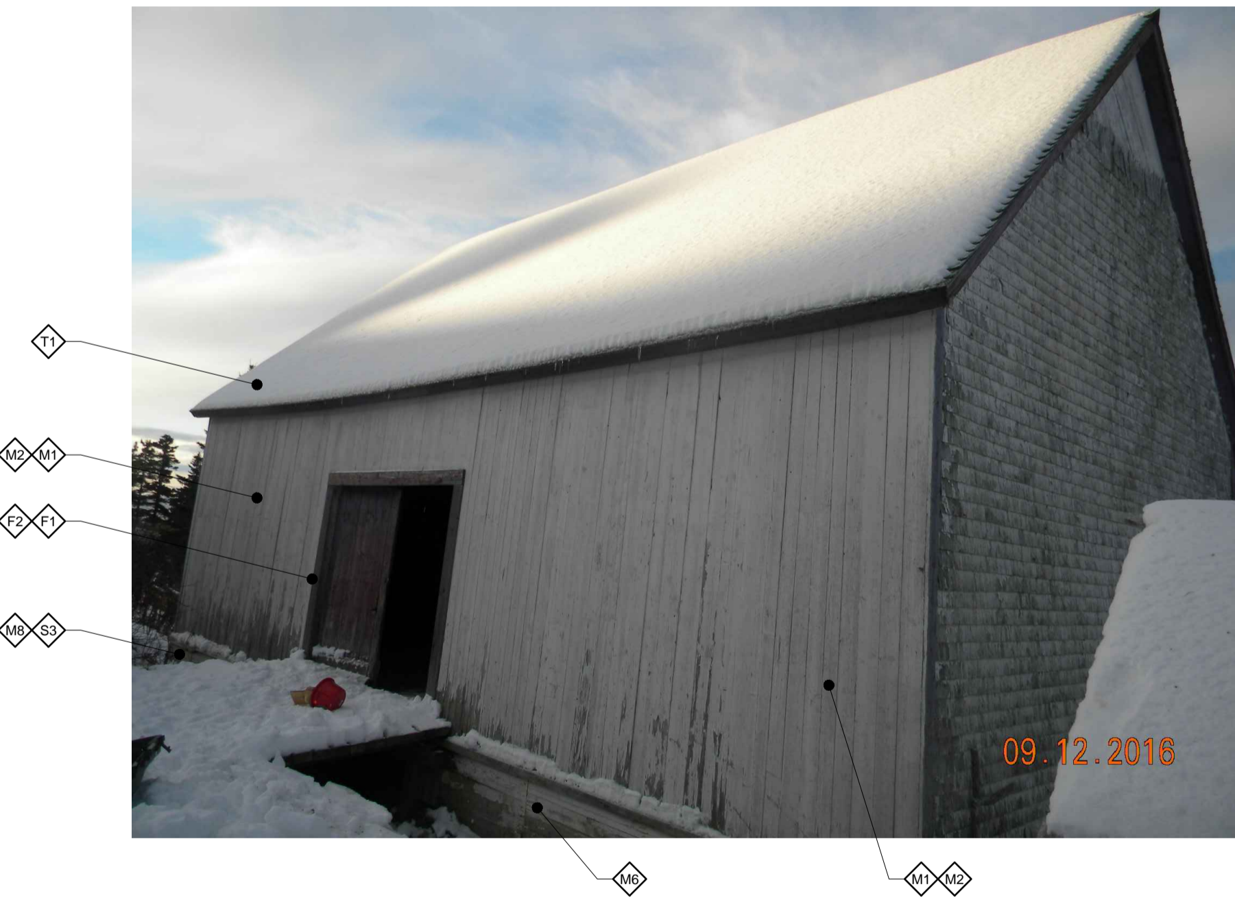
3 A20 ÉLÉVATION EST (CÔTÉ ROUTE) - PHOTO AUCUNE ÉCHELLE
