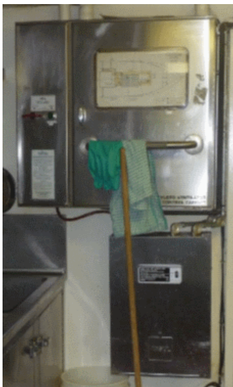
Armoire de commande de la hotte d'extraction et système d'extinction des incendies
