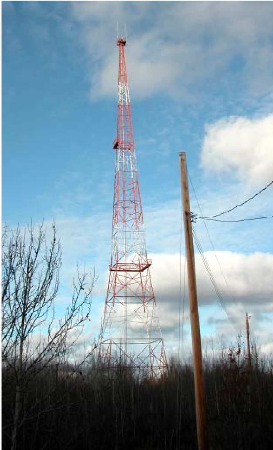
Tour existante à enlever
