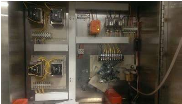
Commandes du château d'Eau, commutateur alternatif des pompes, contacteur au mercure
