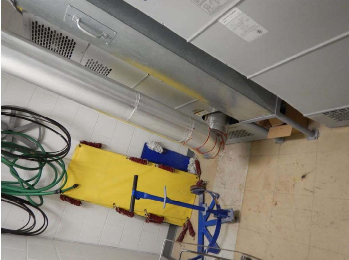
Ceci est le dos de la sécheuse illustrant l'arrivée de l'air de combustion entre les deux sécheuses.
