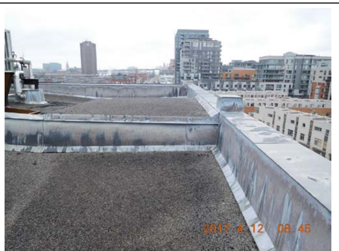
Photo 16 : Bassin 02 et 01, vers cour arrière
