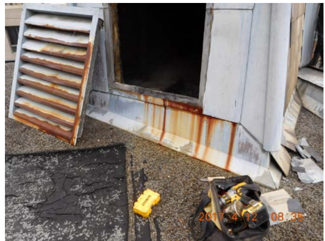
Photo 10 : Vue générale tourelle Grille de ventilation
