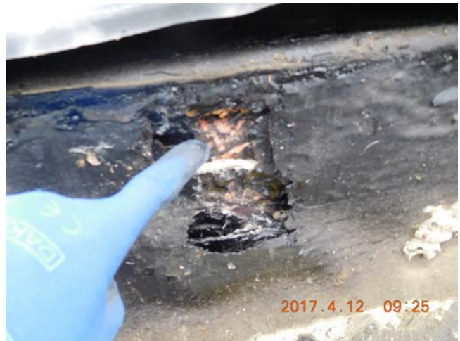
Photo 22 : Muret entre bassin 01, et 02, coupe exploratoire Composition du muret
