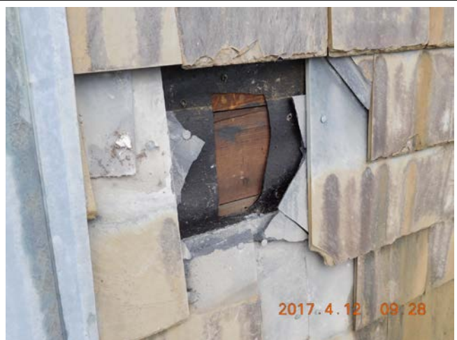
Photo 24 : Tourelle, coupe exploratoire Composition du mur de la tourelle sous l'ardoise
