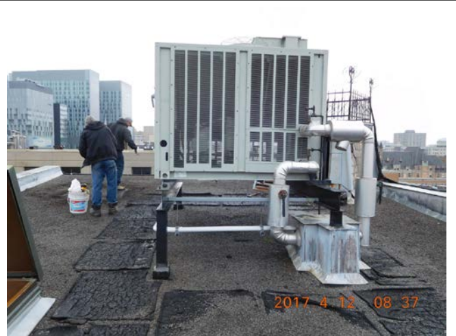
Photo 14 : Bassin 01 Unité au toit
