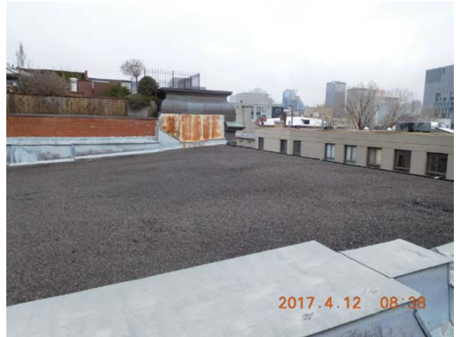
Photo 26 : Mur de maçonnerie, Bassin 02 Vue générale vers sud-ouest
