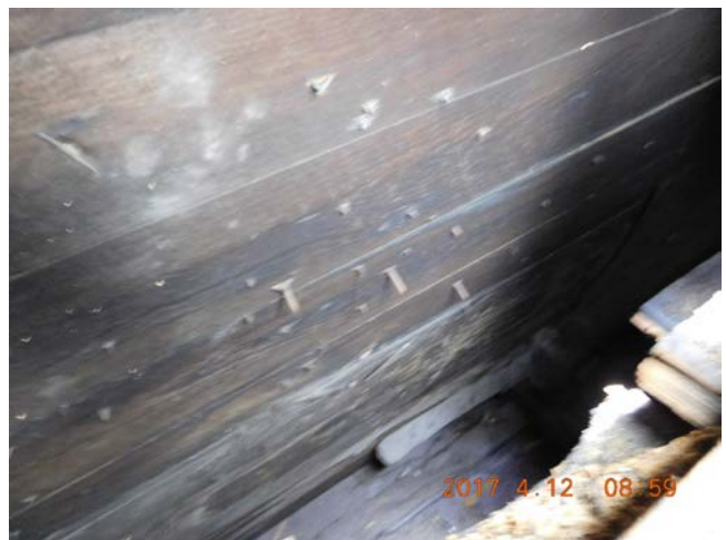
Photo 20 : Parapet- mansarde du bassin 01, coupe exploratoire Vue intérieure de la mansarde
