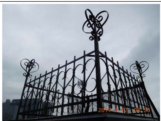
Photo 10 : Vue générale tourelle Détail crête faitière et solinage en cuivre étamé
