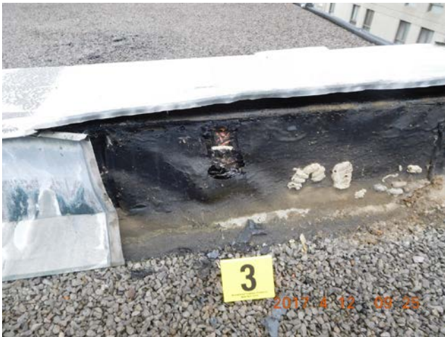
Photo 21 : Muret entre bassin 01, et 02, coupe exploratoire
