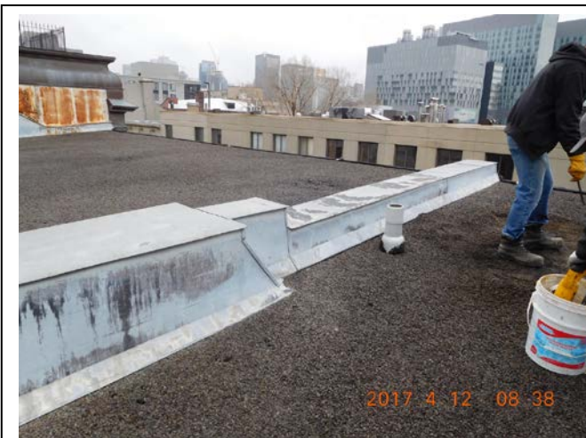
Photo 15 : Bassin 02 et 01, vers façade
