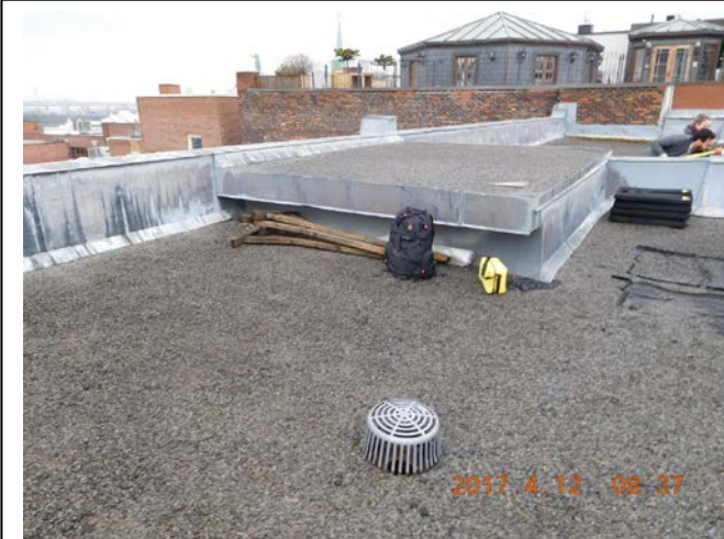
Photo 13 : Bassin 01 et 01-A
