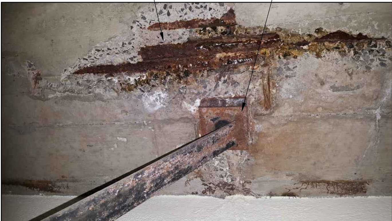
PHOTOGRAPHIE 3 – EXEMPLE DU BÉTON À RÉPARER. PHOTOGRAPHIE 3 – EXEMPLE D'UN CROCHET SUSPENDU À RÉPARER.
