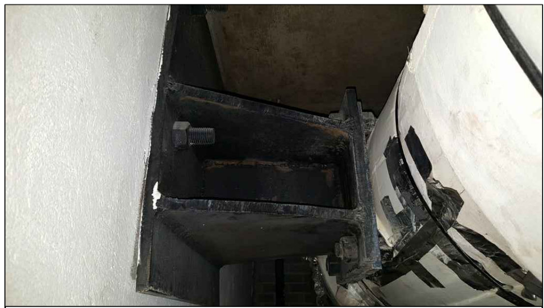
PHOTOGRAPHIE 1 – CROCHET LATÉRAL BR-1, À RÉPARER.
