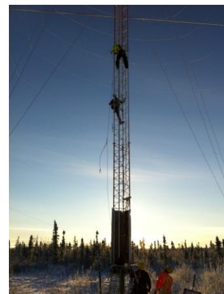
Ascension d'une tour à l'aide d'un crochet d'échafaudage d'échelle avec longe de sécurité à absorption
