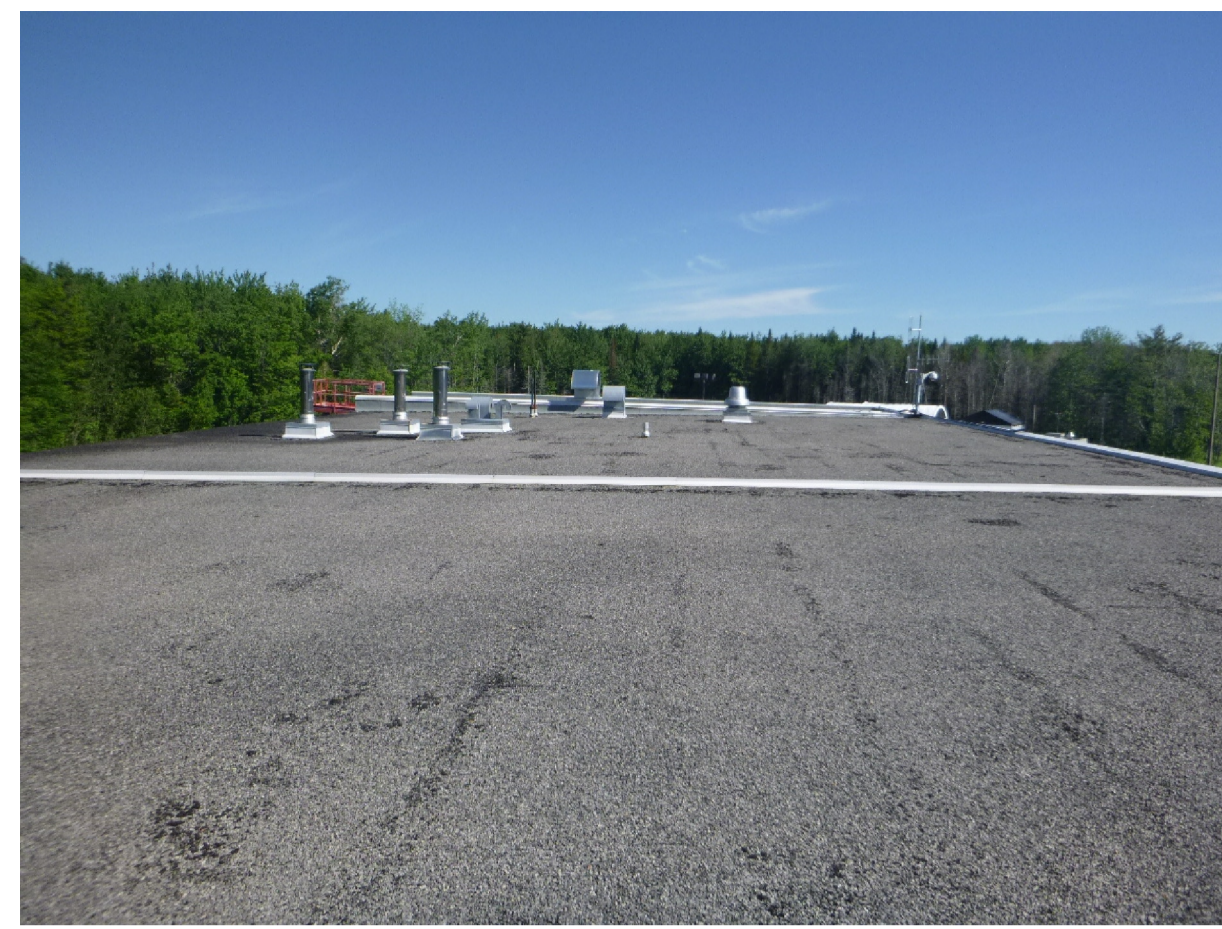
04 PHOTO - VUE D'ENSEMBLE ÉCHELLE: 1:100
