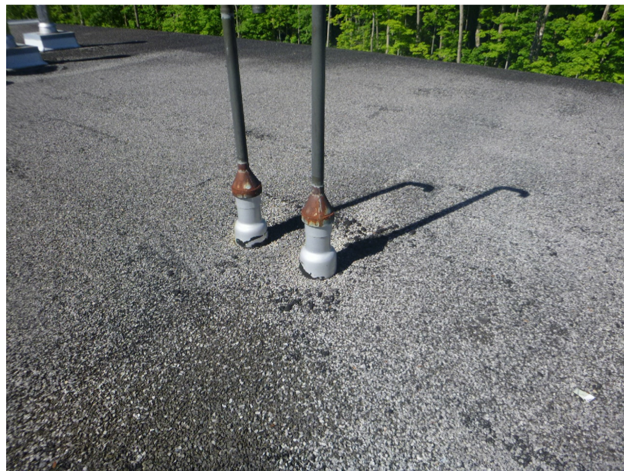
05 PHOTO - CHEMINÉE EXISTANTE ÉCHELLE: AUCUNE
