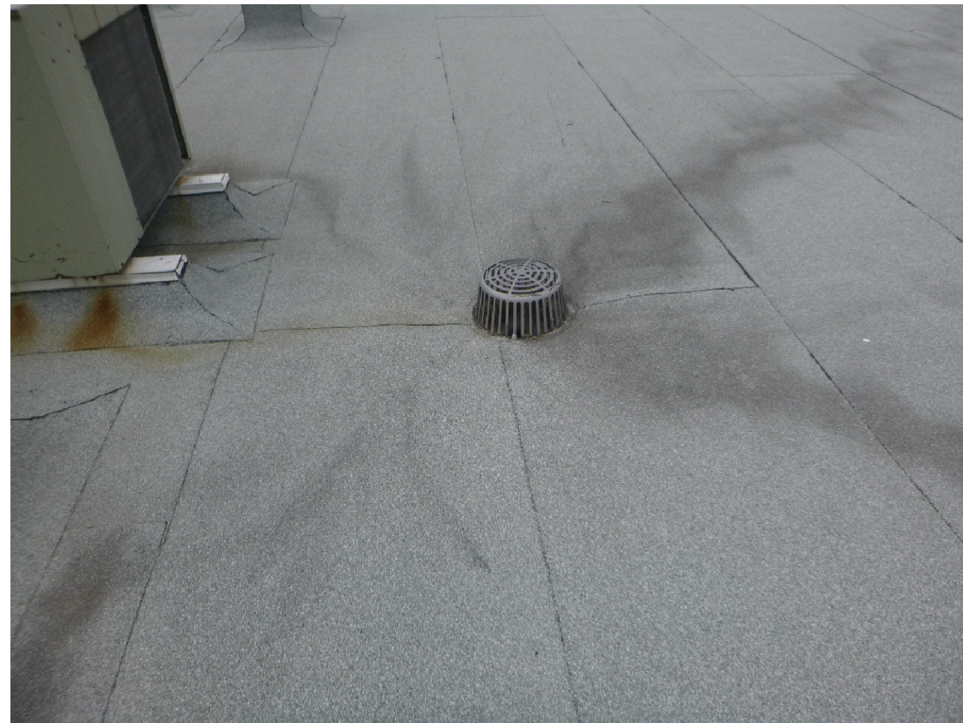
02 PHOTO - DRAIN ECHELLE: AUCUNE
