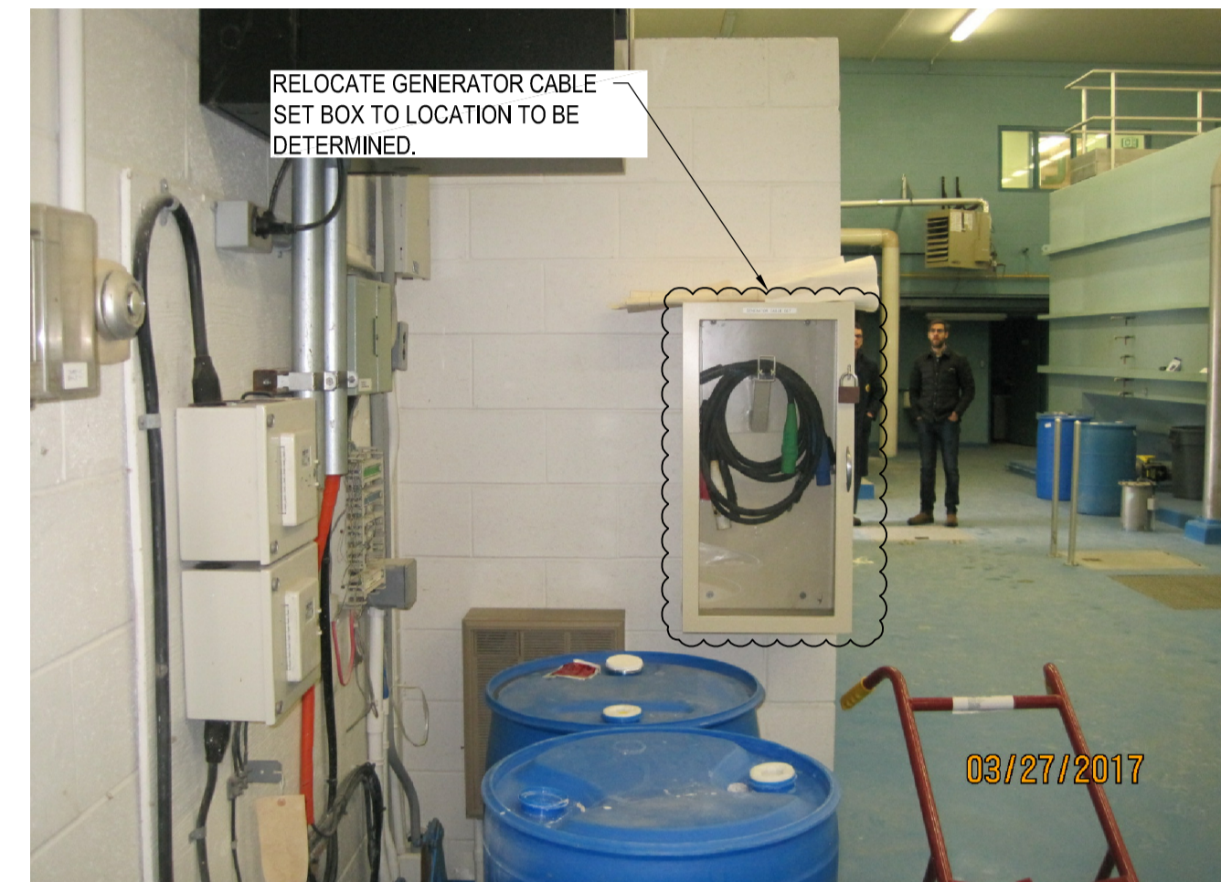
1 P001 GENERATOR CABLE BOX REMOVAL/RELOCATION SCALE: N.T.S.
