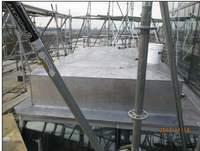
Construction de toiture semblable, à l'état terminé
