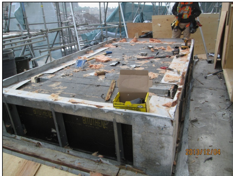
Toit semblable, avec ses éléments extérieurs enlevés
