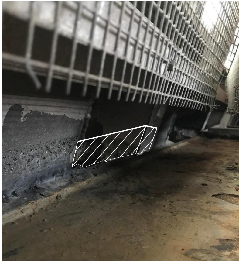
Photographie 1 : Raidisseurs du côté de la cheminée à couper
