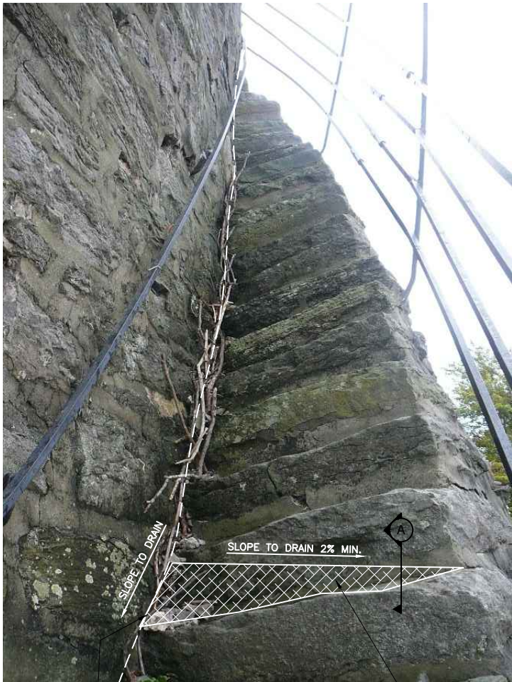
PHOTO 9 EXISTING STAIRWAY REPAIRS N.T.S.
