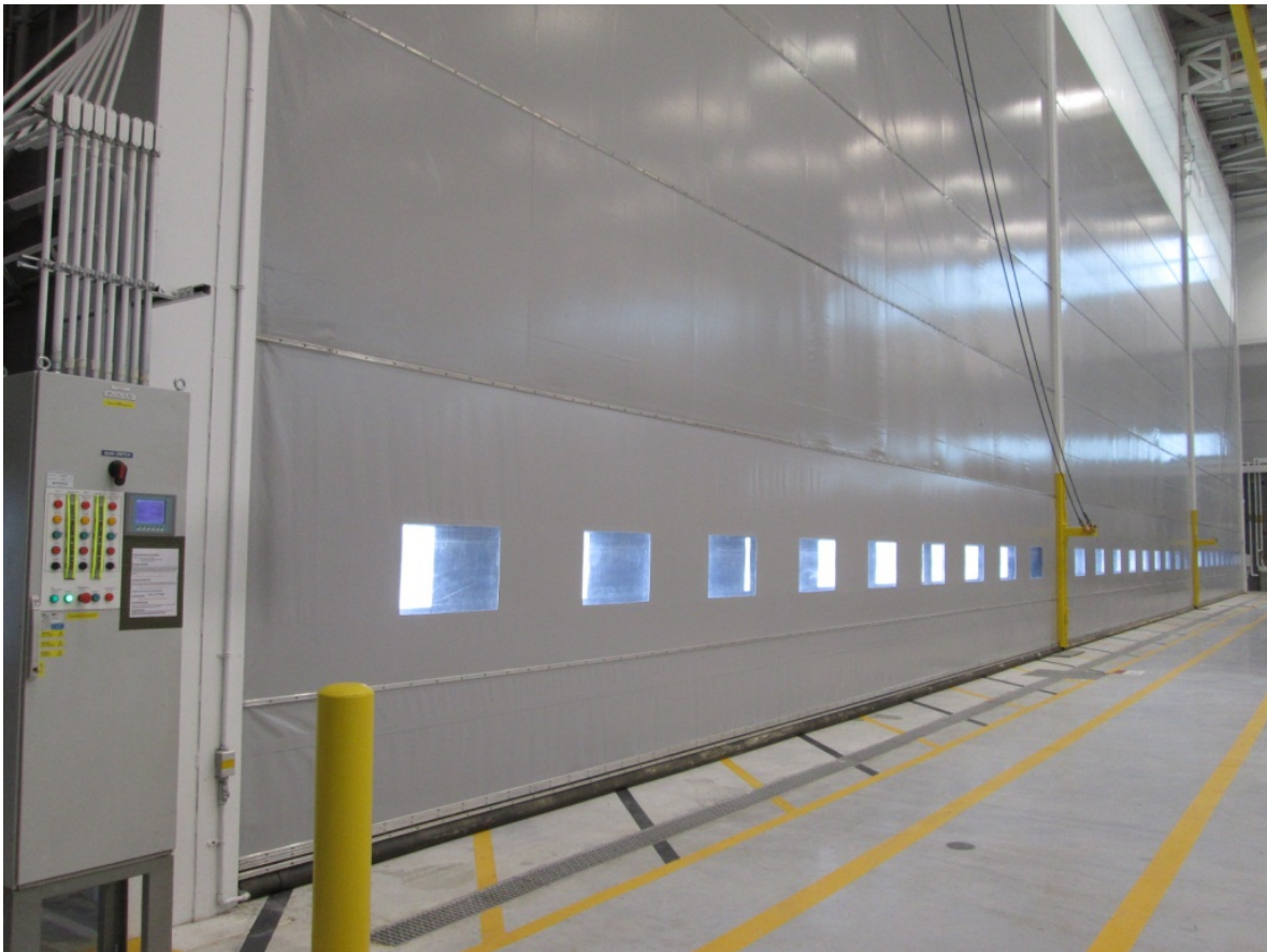
Fig. 2: Vertical Lift Fabric Door
