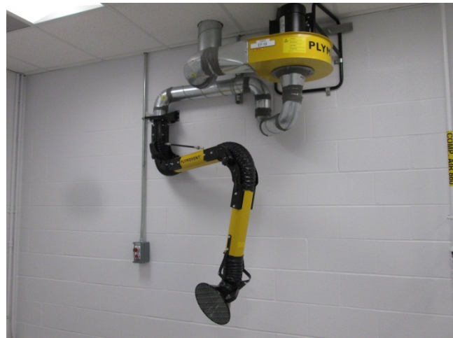
Fig. 19: EF-19 Fume Extraction Arm
