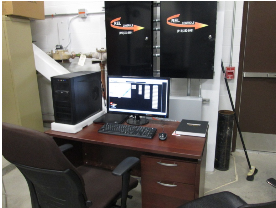
Fig. 35: BAS Workstation
