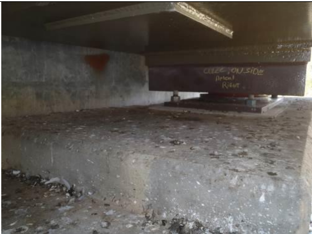
Photo 2 : Assise de la culée, en dessous de la poutre
