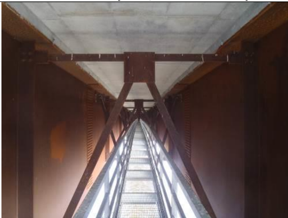
Photo 5 : Ames des poutres, contreventement et balustrade de la passerelle
