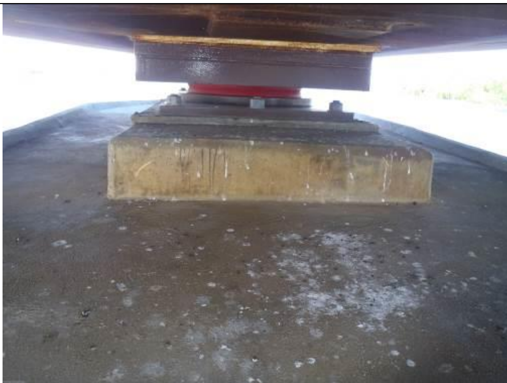
Photo 4 : Assise du pilier, en dessous de la poutre
