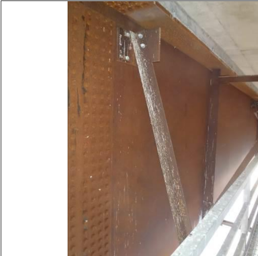
Photo 8 : Cadre de support de la passerelle
