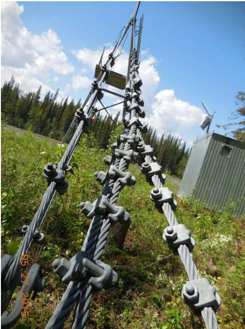
Photographie 5 : Serre-câbles au bout des câbles d'acier du « côté proche » du téléphérique de la rivière Finlay (en amont de la rivière Akie).
