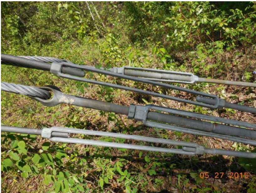
Photographie 4 : Tendeurs du « côté proche » du téléphérique de la rivière Finlay (en amont de la rivière Akie).
