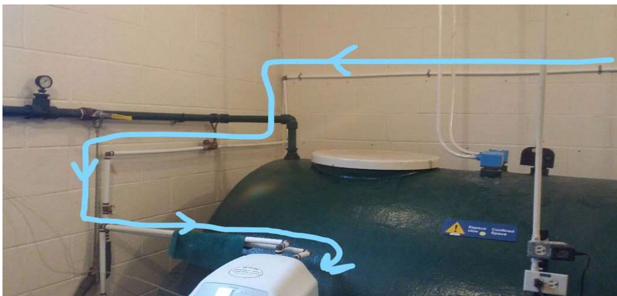
Photo 8 : cheminement de l'eau et installations du poste frontalier de Lacolle 221
