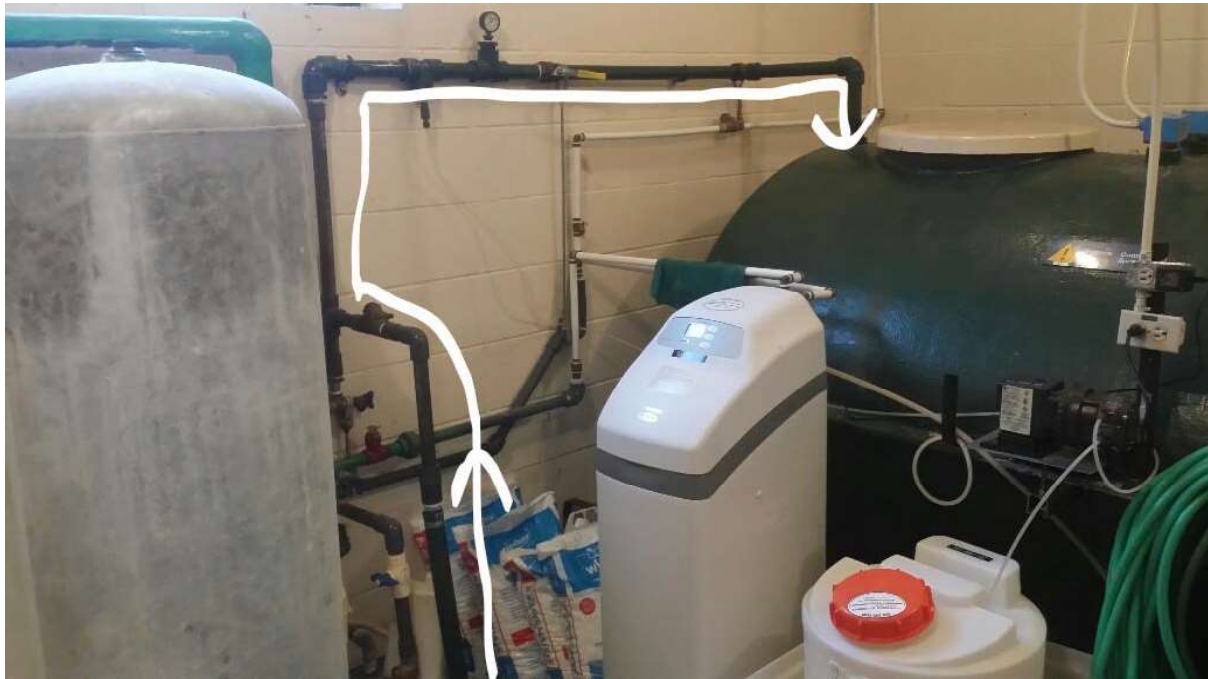
Photo 5 : cheminement de l'eau et installations du poste frontalier de Lacolle 221
