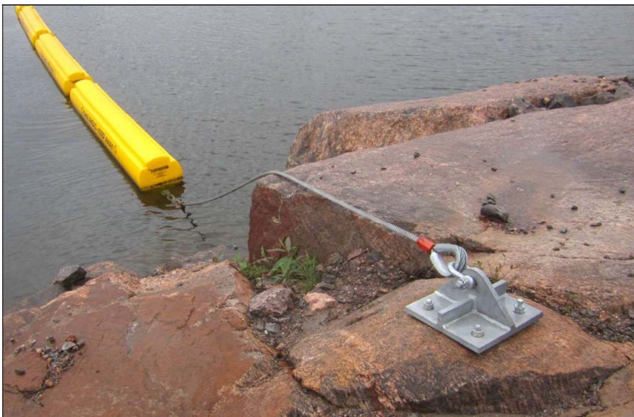
Figure 31: Ancrage de la voie de barrière navigable à la centrale hydroélectrique Okikendawt, adjacent au barrage de Portage. Image fournie afin de démontrer les conditions locaux du site.
