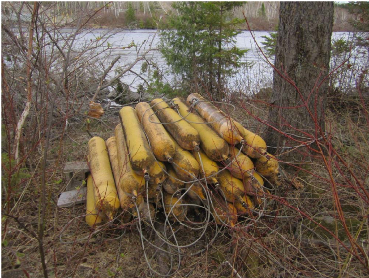
Figure 13 : Vue de la rive gauche actuelle (face à la rive droite). Les pièces d'estacades actuelles sont montrées dans la photo. L'ancrage actuel sur la rive gauche actuel est un câble attaché autour d'un arbre, montré à droite.
