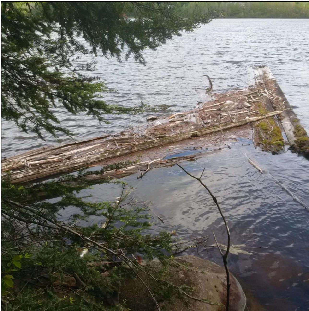
Figure 7 : Ancrage droit actuel. Le vieux bout de bois débité est relié par une chaîne à un tronc d'arbre, l'extrémité droite des bouées actuelles est reliée au moyen d'une chaîne au bout de ce morceau de bois débité. Ces billots sont en place depuis des décennies et n'ont jamais été enlevés. On peut voir une grosse roche dans le bas de la photo, l'une des nombreuses roches qui se trouvent sur la rive droite.
