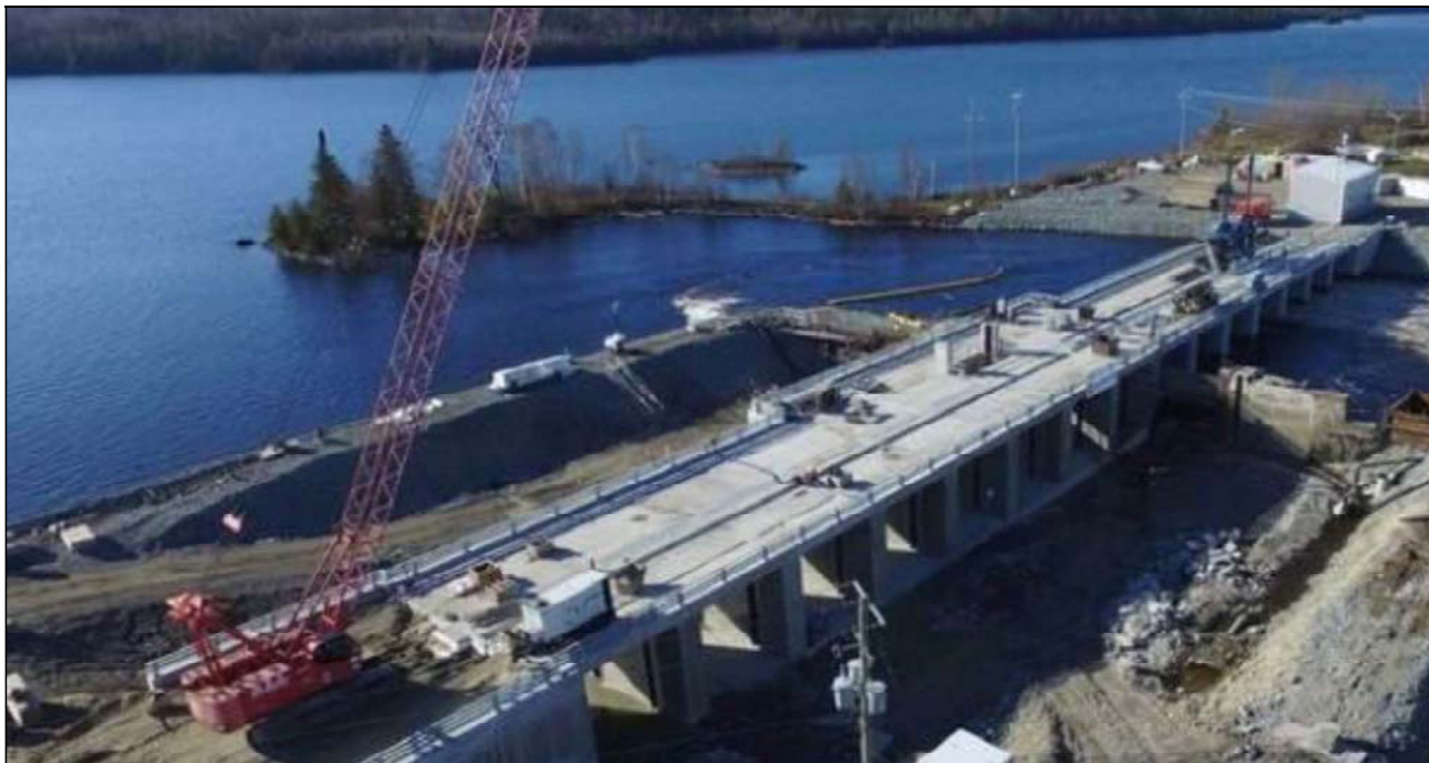
Figure 14 : Nouveau barrage Latchford en construction, montrant une autre vue de la bande de terre sur laquelle l'ancrage gauche de la nouvelle barrière de voie navigable sera fixé.
