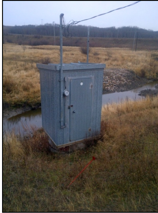
Photographie 5 : Abri typique au-dessus d'un puits de créosote
