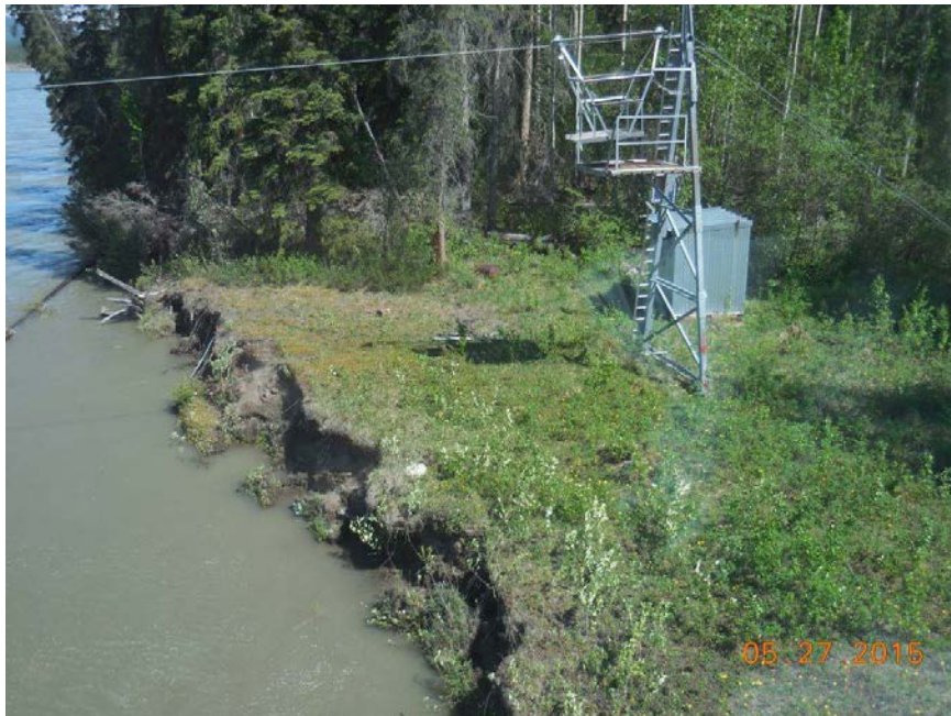
Photographie 2 : Pylône en A et plateforme typiques
