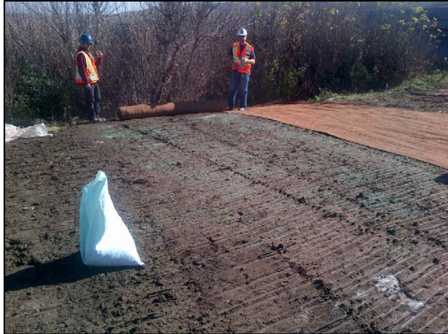
Photographie 9 : Textile antiérosion placé au-dessus de sol remanié compacté et de semences indigènes
