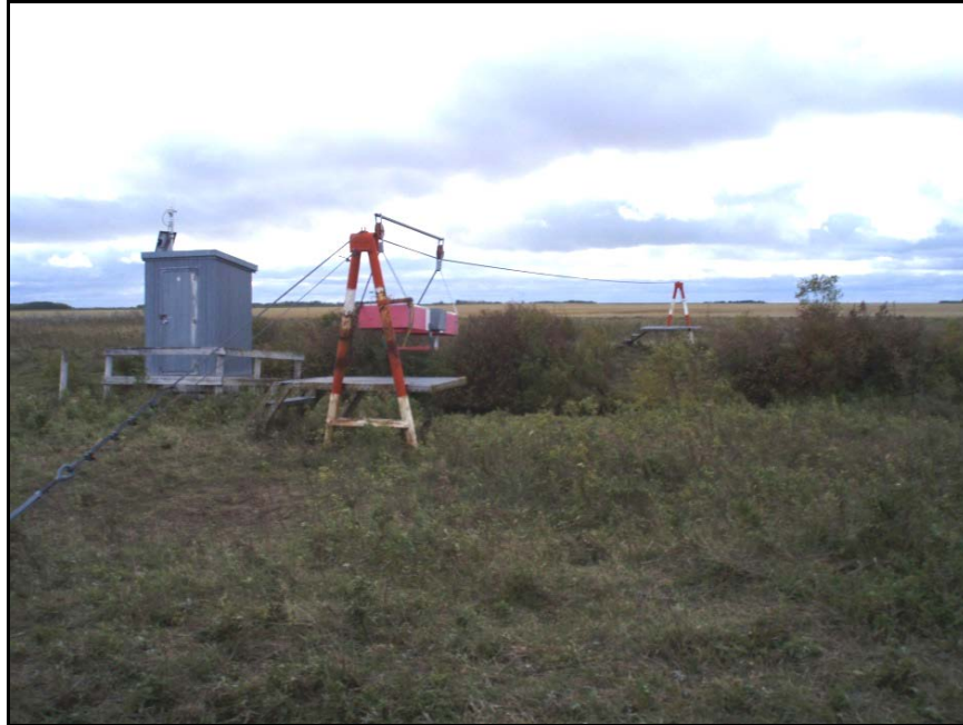
Photographie 1 : Téléphériques et pylônes typiques
