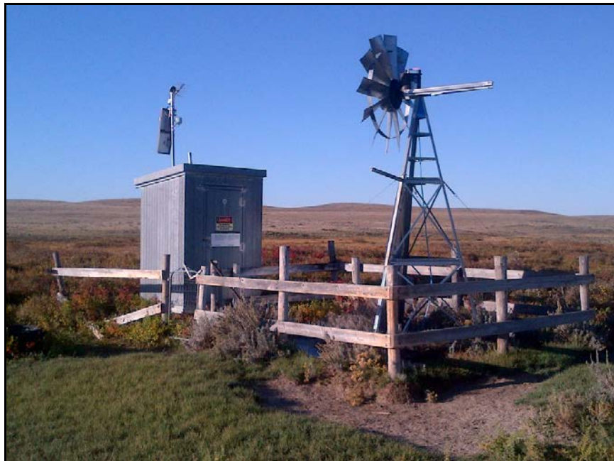
Photographie 8 : Abri typique avec éolienne et clôture
