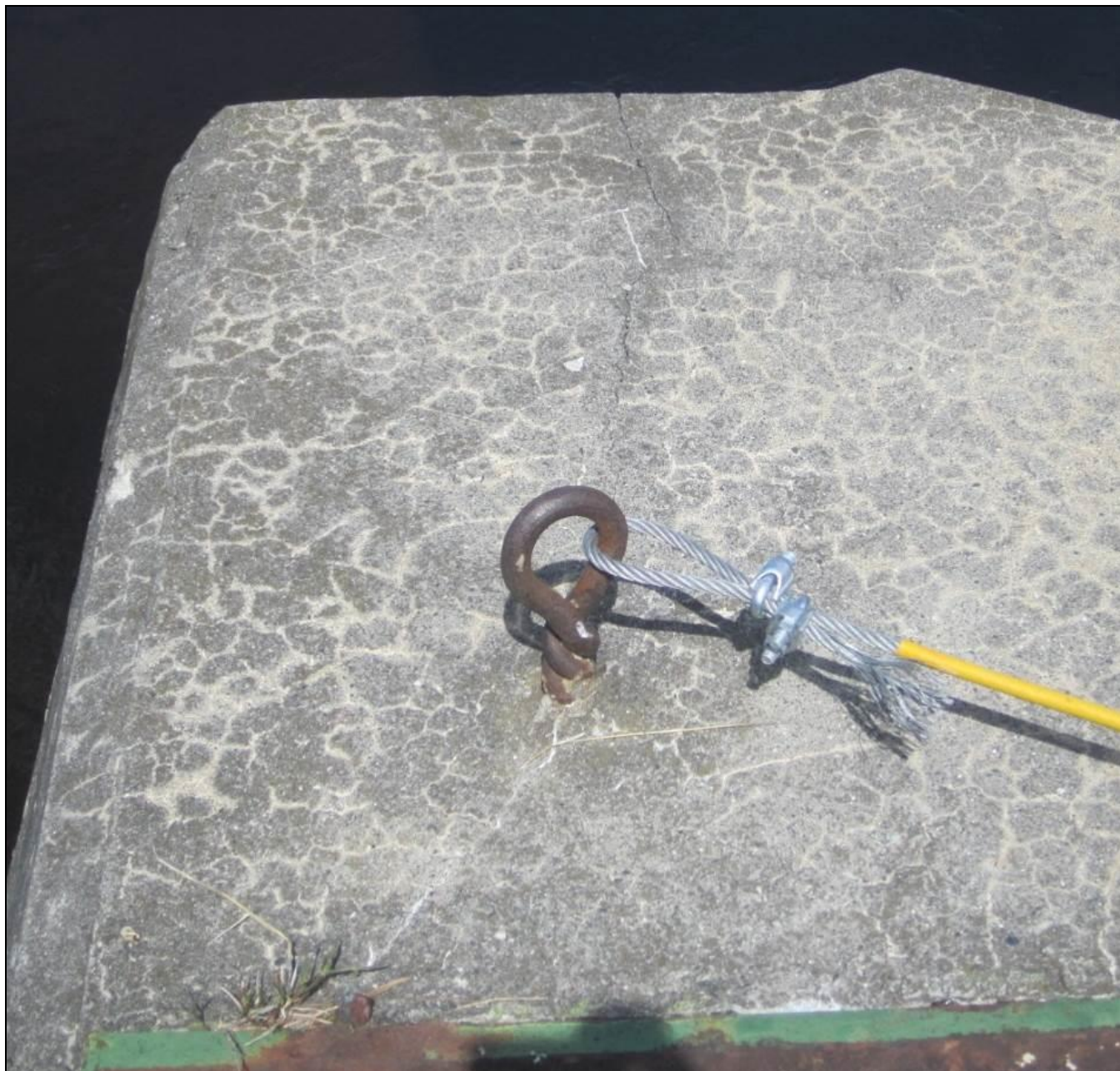
Figure 24 : Ancrage actuel au barrage de Portage, côté droit. La photographie est fournie uniquement pour illustrer la configuration générale : la nouvelle barrière de voie navigable doit être en amont de cet ancrage et la configuration du serre-câbles est inacceptable.
