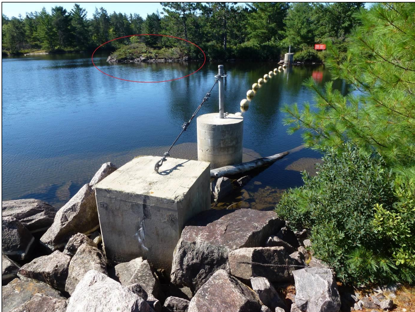
Figure 29: Barrage de Portage: barrière de voie navigable. Cercle rouge démontre l'emplacement approximatif de l'ancrage gauche de la nouvelle barrière de voie navigable; détails dans l'image qui suit (l'eau coule de gauche à droite dans l'image, malgré la courbe légère de la barrière de voie navigable).
