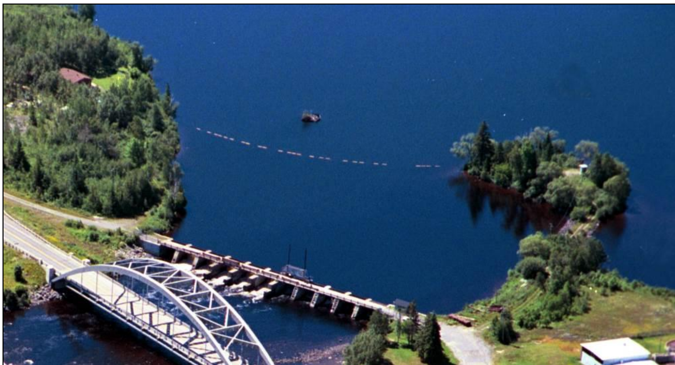
Figure 9 : Barrage Latchford qui montre l'ancien barrage et l'ancienne barrière de voie navigable (photo prise en 2001). Le nouveau barrage Latchford a été construit un peu en amont de l'ancien. La nouvelle barrière de voie navigable se trouvera au même emplacement que l'ancienne, l'ancrage droit est placé légèrement en aval de l'ancrage actuel.
