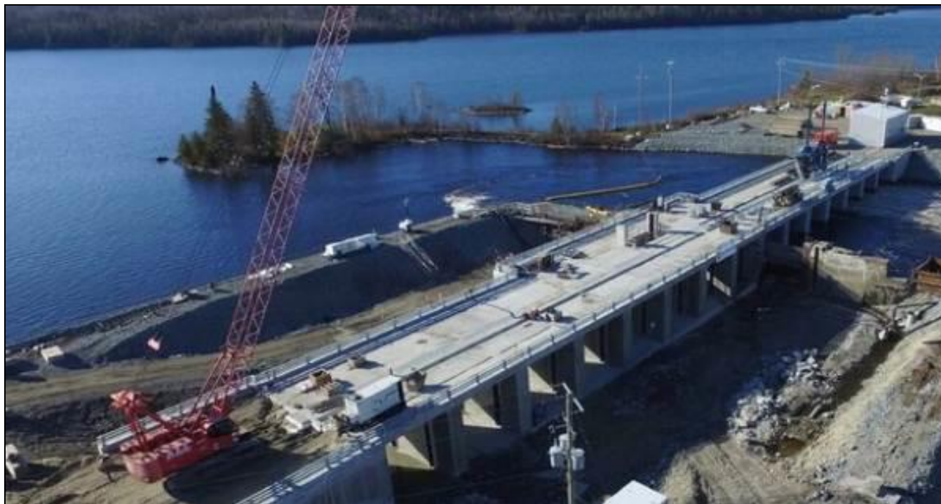
Figure 14 : Nouveau barrage Latchford en construction, montrant une autre vue de la bande de terre sur laquelle l'ancrage gauche de la nouvelle barrière de voie navigable sera fixé.
