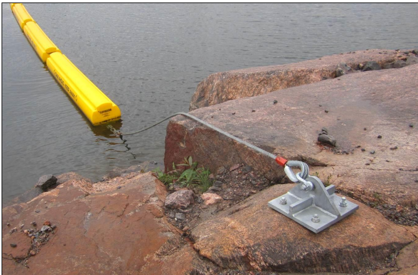
Figure 31: Ancrage de la voie de barrière navigable à la centrale hydroélectrique Okikendawt, adjacent au barrage de Portage. Image fourni afin de démontrer les conditions locaux du site.
