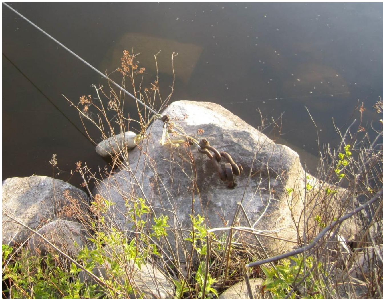
Figure 6 : Barrage Témiscamingue, ancrage gauche actuel de la barrière de voie navigable.
