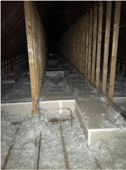
Q9, Photo 1 – Cloisons du grenier
