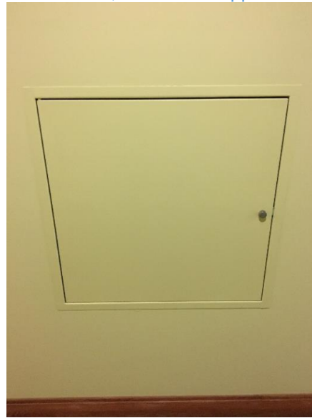
Q10, Photo 2 – trappe d'accès existante
