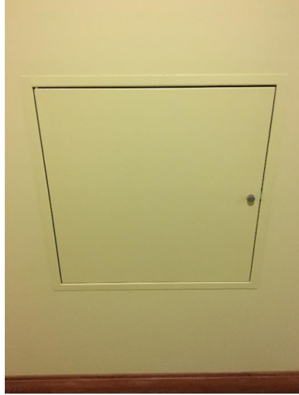
Q10, Photo 2 –existing access hatch
