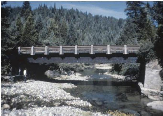
Figure 4.2 Les produits de préservation à l'huile sont souvent utilisés pour le traitement des poutres en bois lamellé collé comme on le voit sur cette photo d'un pont (Lebow et Tippie, 2001).
