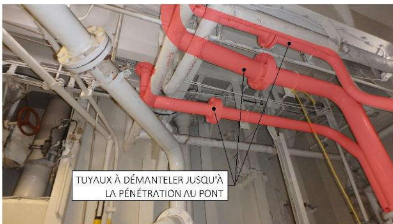
Figure 26 Tuyau d'eaux grises sous le pont à 17 pi
