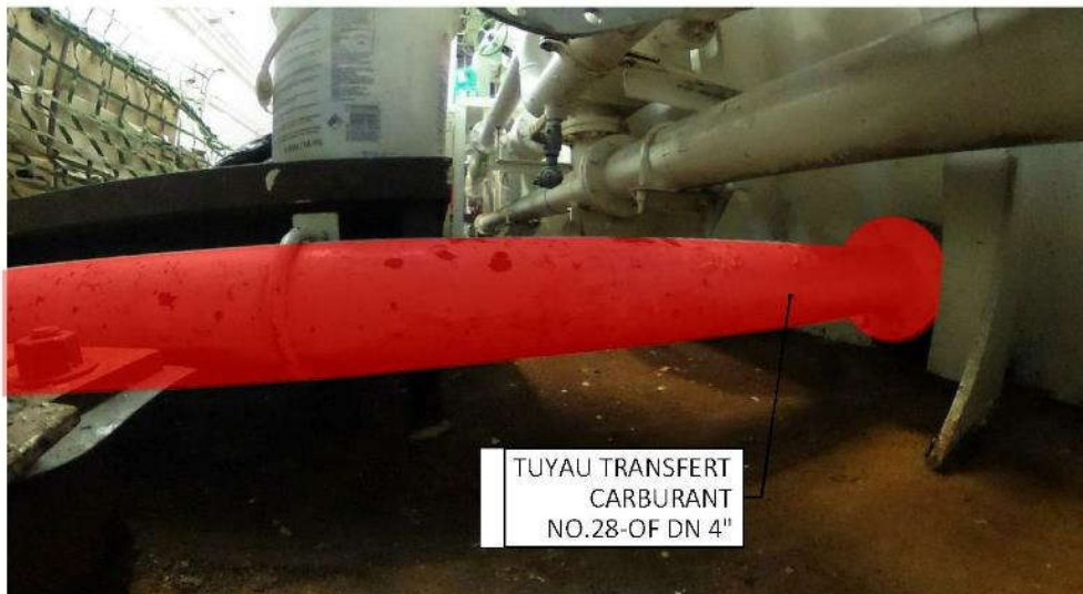
Figure 17 Transfert de carburant, raccord à la cloison 138
