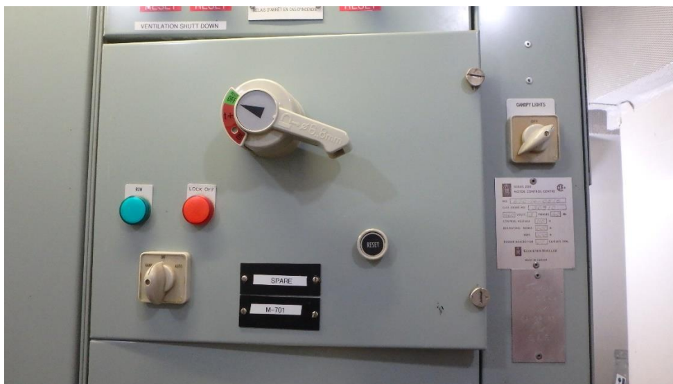
Figure 7: Panneau de l'alimentation principale (460 V)
