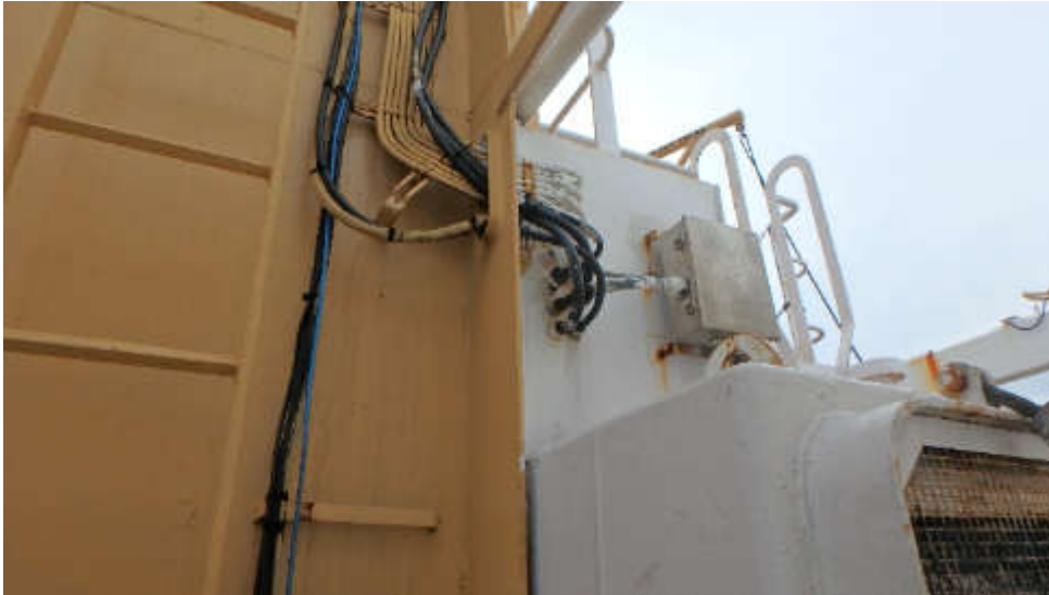
Figure 36 Passage de câbles existant entre le mât arrière et la salle de la génératrice d'urgence
