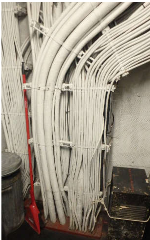
Figure 37 Chemin vertical dans la salle des onduleurs statiques
