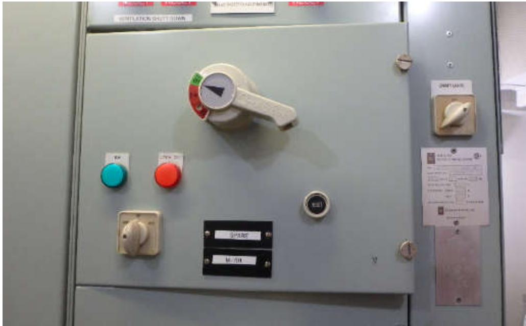
Figure 41 Disjoncteur M-701 dans la Salle équipement
