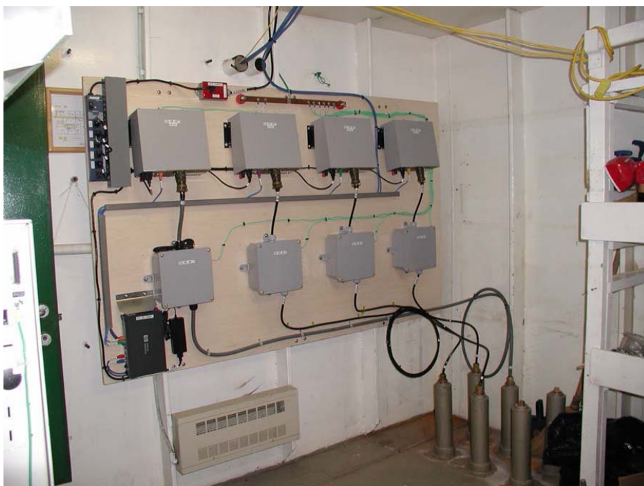
Figure 1. Unités d'émission-réception, boîtes de jonction (sous les émetteurs-récepteurs polyvalents), conduits des transducteurs, câbles menant aux conduits des transducteurs et installation du commutateur de réseau.
