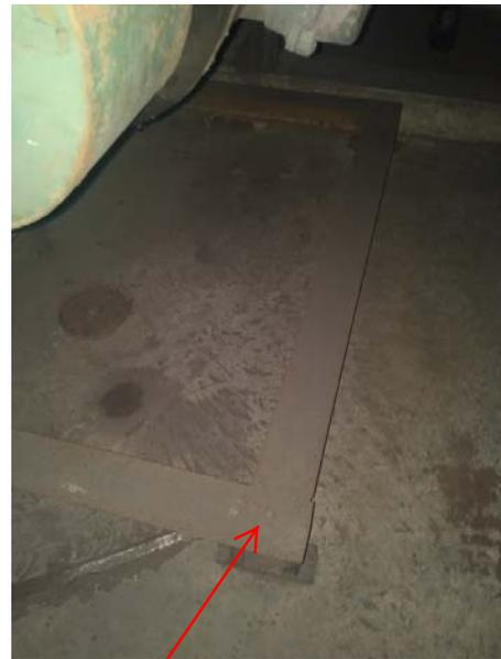
Les photos ci-dessus indiquent une section de la charpente en métal existante à enlever complète avec des points d'ancrage. Reportez-vous au détail 2 / A100 révisé ci-joint pour l'étendue.
