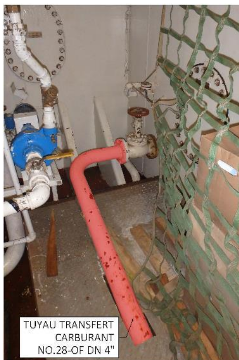
Figure 15 Transfert de carburant, raccord à la cloison 146
