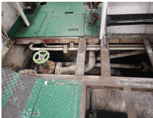
Valve #157 et tuyau de 14" du système d'assiette
