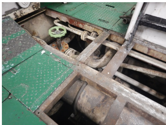
Valve #157 et tuyau de 14" du système d'assiette
