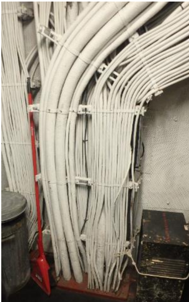
Figure 36 Chemin vertical dans la salle des onduleurs statiques
