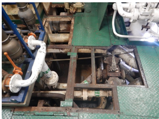
WQP aspiration et filtre duplex
