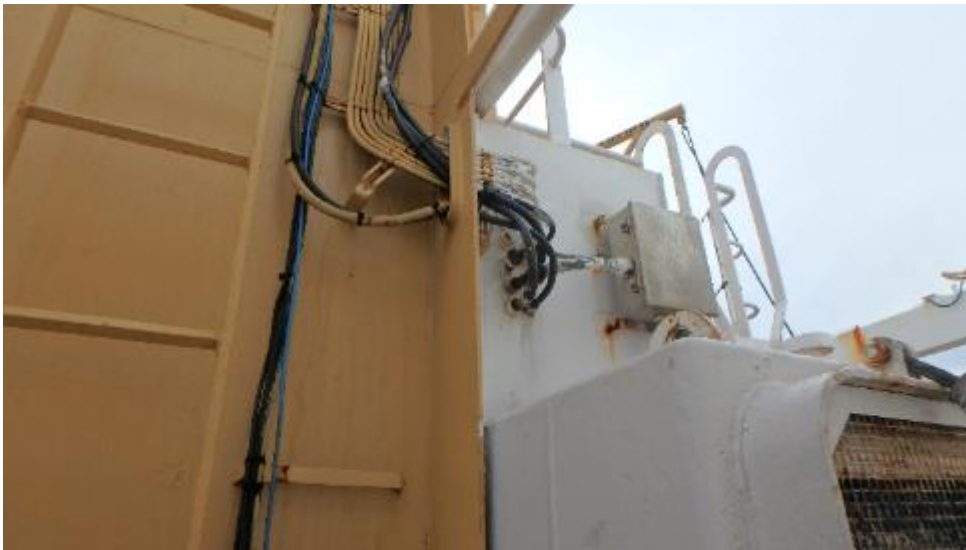
Figure 35 Passage de câbles existant entre le mât arrière et la salle de la génératrice d'urgence
