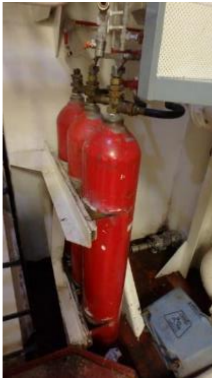
Figure 5 Système de CO2
