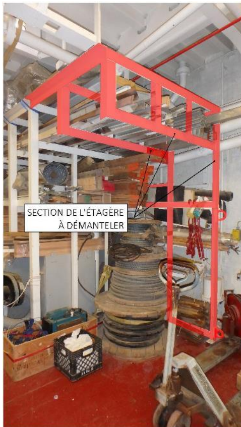
Figure 2 Section étagère à démanteler
