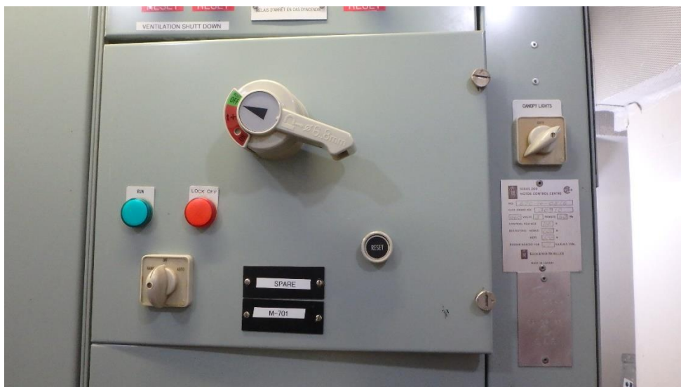
Figure 7: Panneau de l'alimentation principale (460 V)
