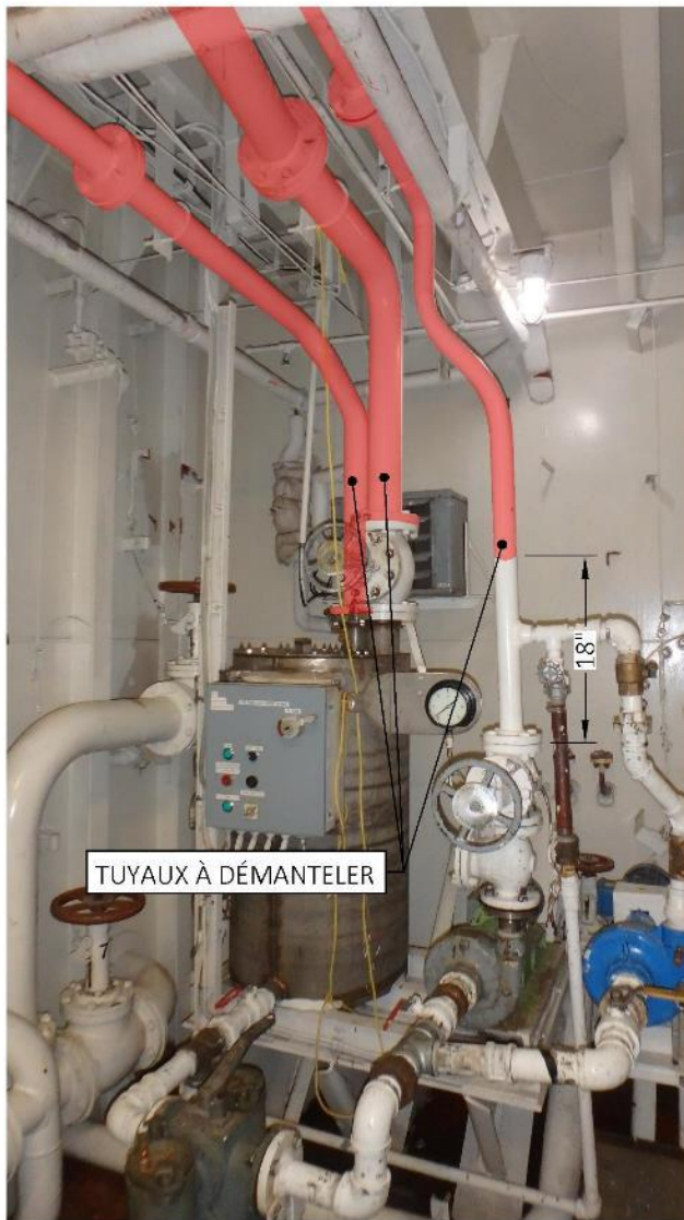
Figure 26 Système de collecte des eaux grises
