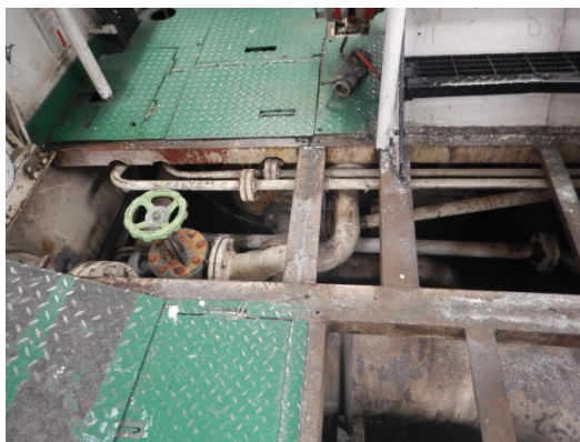
Valve #157 et tuyau de 14" du système d'assiette
