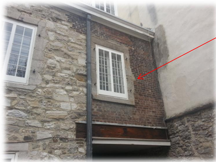
Photo 22 : Extension au sud de la maison en mur de brique
