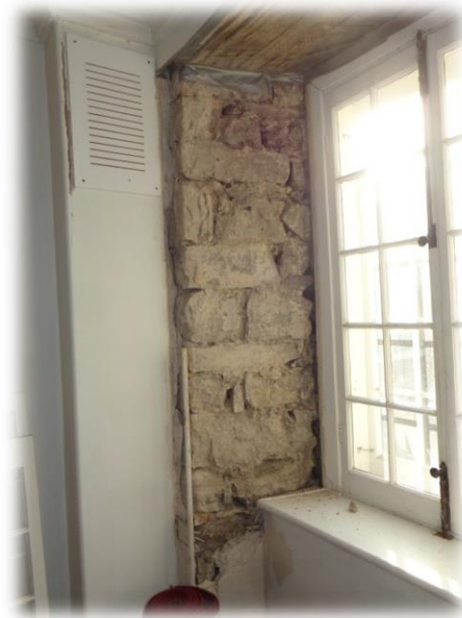
Photo 3 : Dégarnissage du mur
