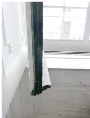
Fig.154 Rejette-eau sur les volets intérieurs – F26-N1
