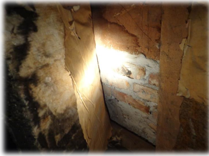
Photo 23 : Muret de brique
