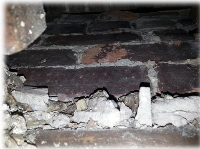
Photo 8 : Dégarnissage du mur du côté sud-est au 2 e étage
