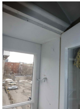
Fig.155 Entre-fenêtres et accrochage des contre-fenêtres - F24-N1
