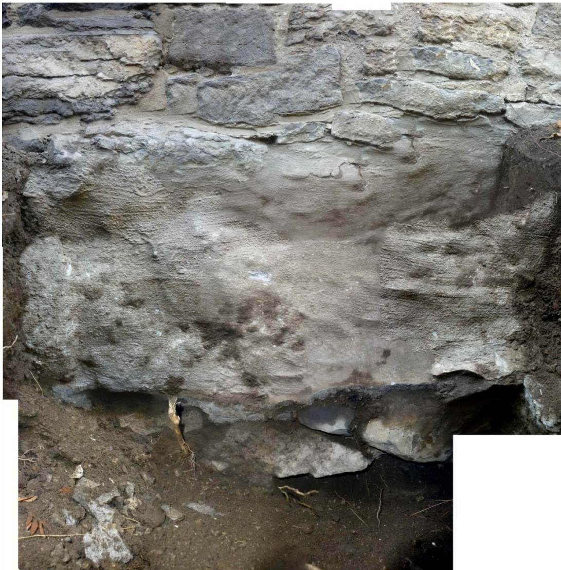
Fig.134 Fondation du Mur E3 – Cour arrière, excavation sur environ 1000 mm de profondeur et de largeur.
