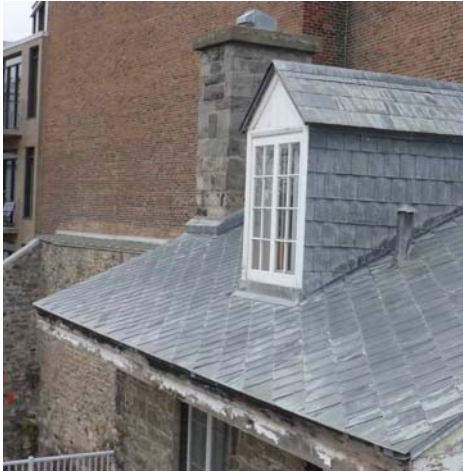
Fig.30 Vue générale de la toiture, annexe cuisine. – F41-E3
