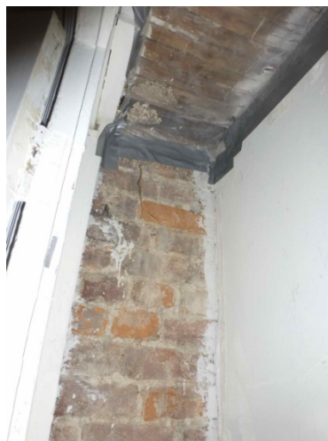
Fig.85 Face intérieure du mur mitoyen sud en brique.
