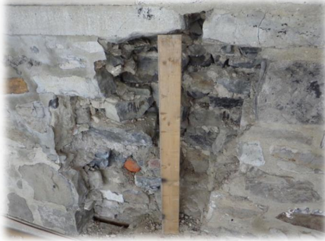
Photo 15 : Ouverture 11 au 2 ème étage - Élévation sud – Corps principal
