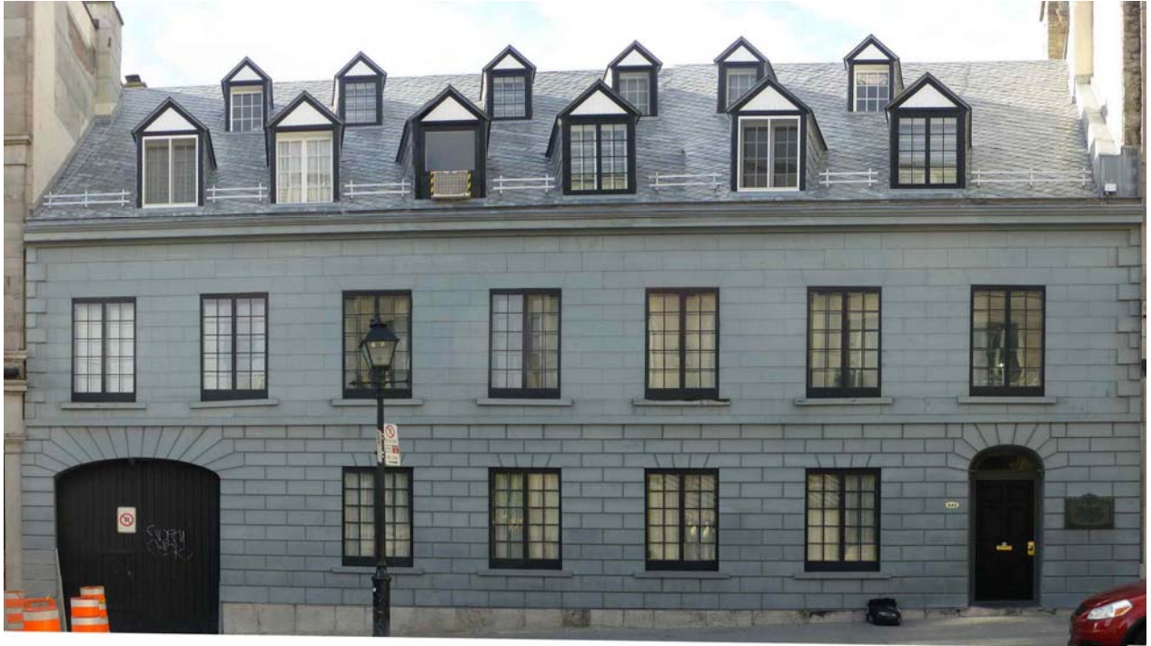
Fig.8 Élévation N1- rue Bonsecours
