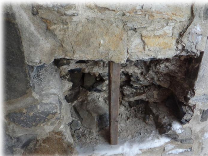
Photo 14 : Ouverture 10 au rez-de-chaussée - Élévation sud – Corps principal
