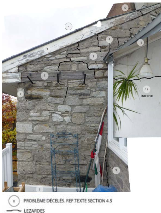
Fig.99 Élévation N2 – 3 e étage
