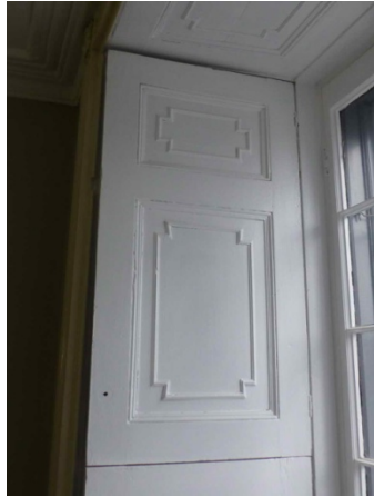
Fig.166 Volets d'intimité à démonter pour le dégarnissage - F27-N1
