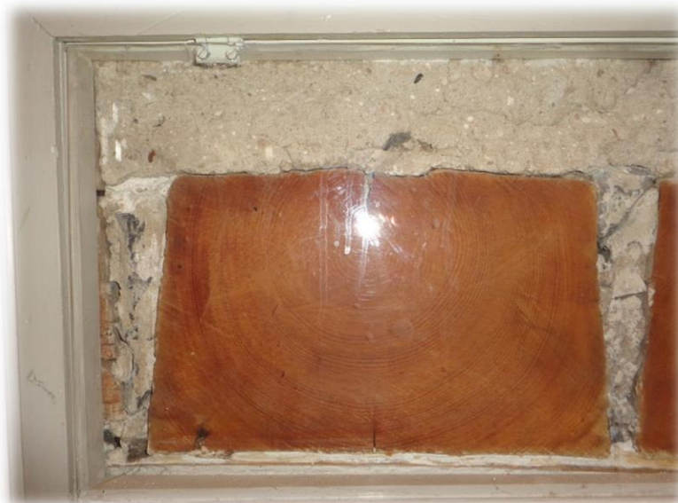
Photo 10 : Section du plancher du 3 e étage
