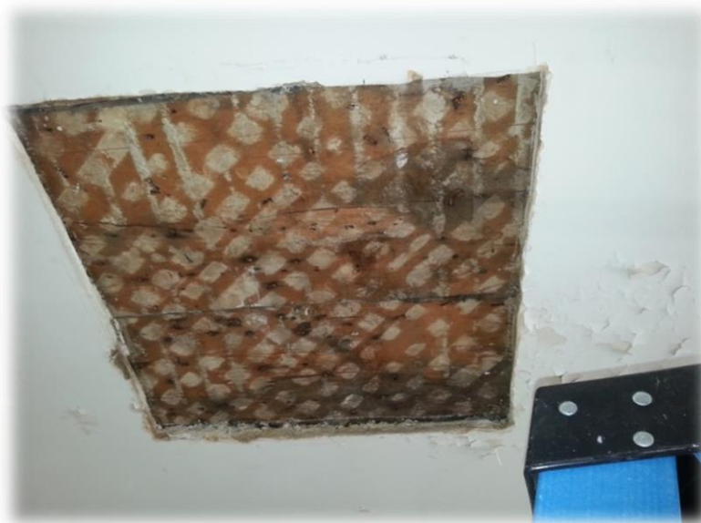
Photo 9 : Intrados du plancher du 3 e étage
