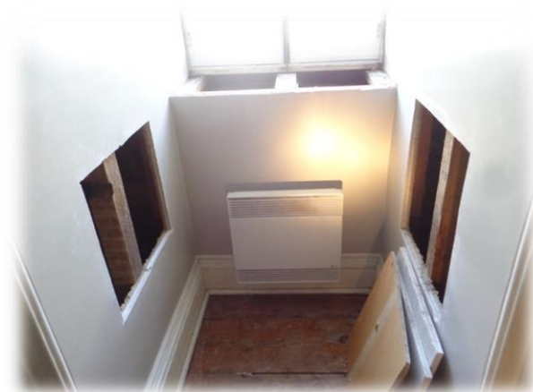
Photo 4 : Ouverture intérieure du mur côté nord au comble 1
