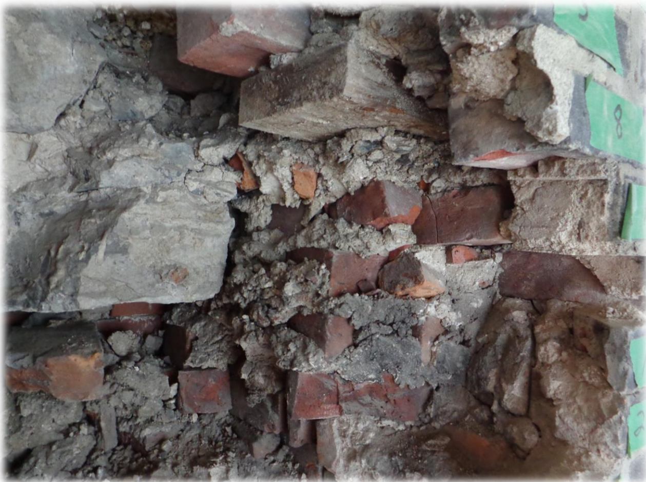
Photo 17 : Ouverture 13 au 2 e étage - Élévation sud – Corps principal
