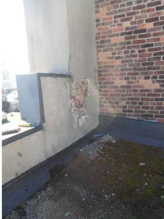
**Photo 8 – Crépi cimentaire contenant de l’amiante de type chrysotile appliqué sur la cheminée, située sur la toiture (secteur 1748)**
