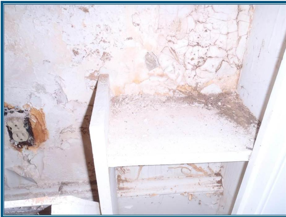
**Photo 10 : Mur en plâtre sur ciment au 1<sup>er</sup> étage – Échantillon # 1F**
