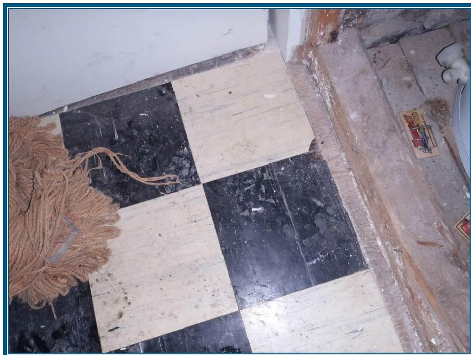
**Photo 8 : Tuiles de vinyle au plancher du 1<sup>er</sup> étage – Échantillons # 4 et 5**
