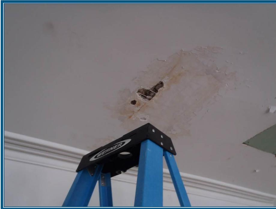
Photo 21 : Plafond en plâtre sur ciment au 1<sup>er</sup> étage – Échantillons #2H et I
