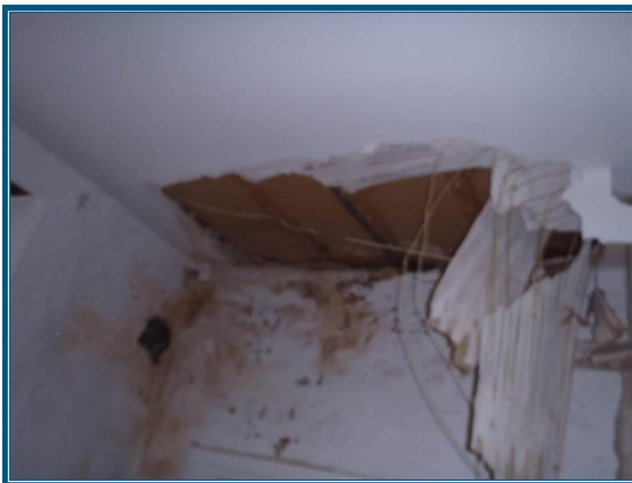
**Photo 15 : Plafond en plâtre sur ciment au rez-de-chaussée - Échantillons # 2D, E, F**
