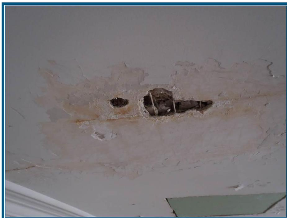
**Photo 20 : Plafond en plâtre sur ciment au 1<sup>er</sup> étage – Échantillon 2G**
