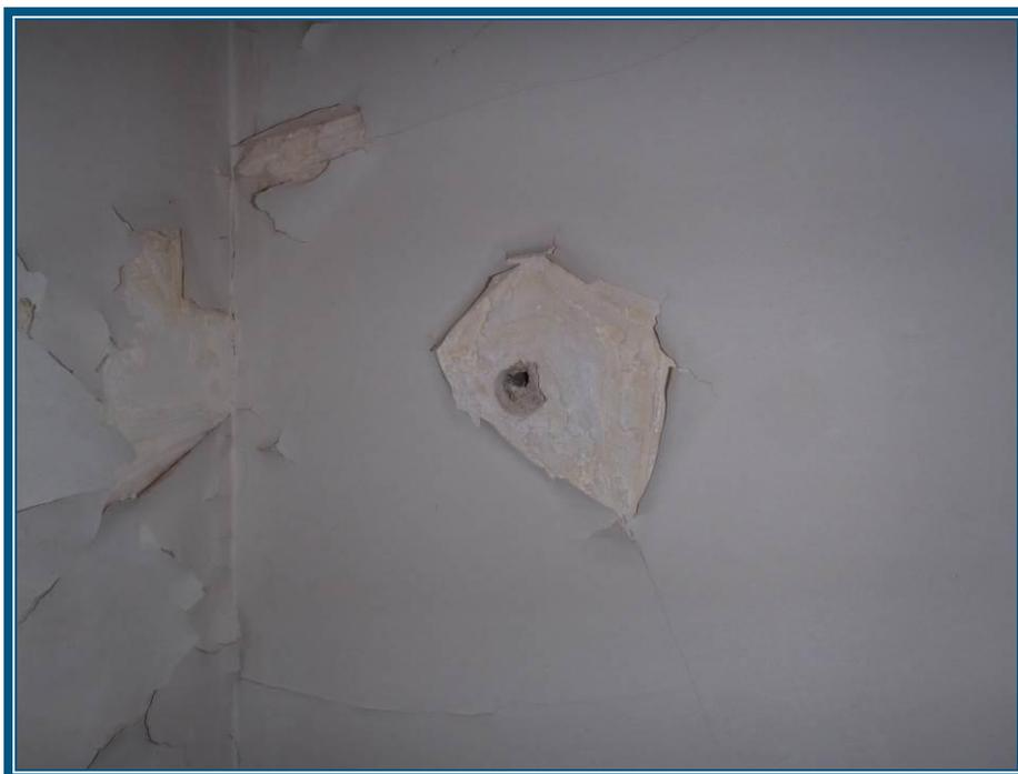
**Photo 13 : Plafond en plâtre sur ciment au 1<sup>er</sup> étage - Échantillon #2G**
