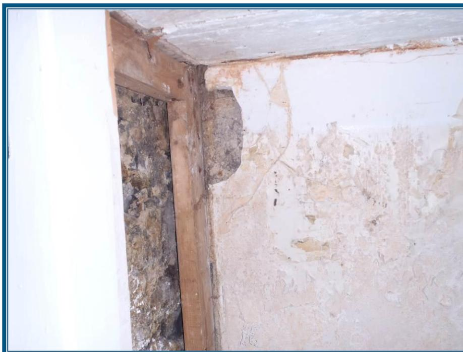
**Photo 16 : Mur en plâtre sur ciment au rez-de-chaussée - Échantillon #1 G**
