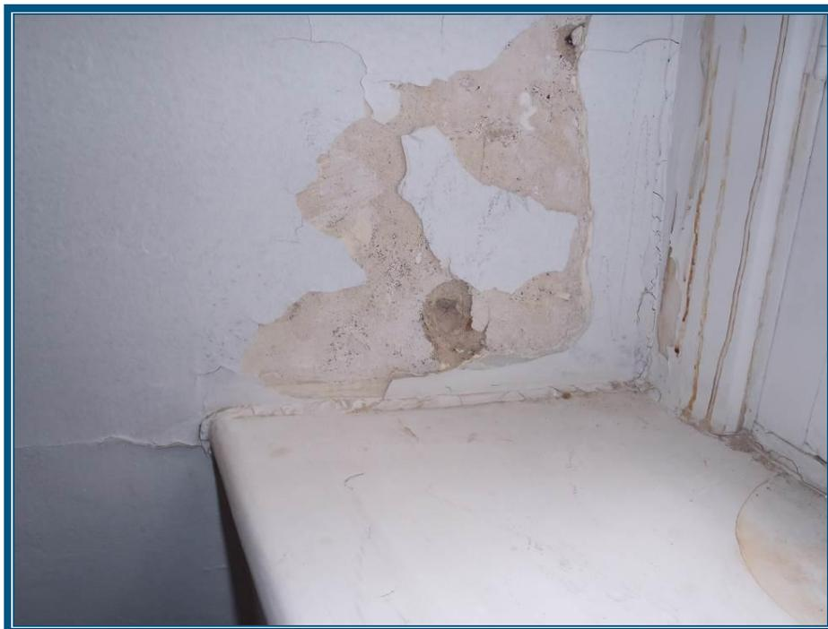
**Photo 7 : Mur en plâtre sur ciment au 1<sup>er</sup> étage – Échantillon #1D**
