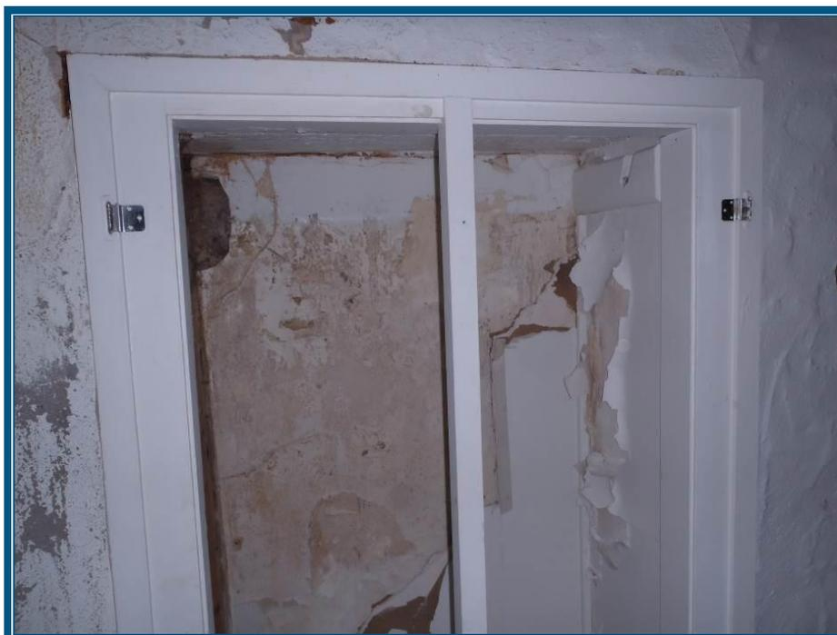
**Photo 17 : Mur en plâtre sur ciment au rez-de-chaussée – Échantillon #1 H**
