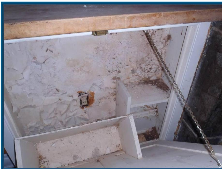
**Photo 11 : Mur en plâtre sur ciment au 1<sup>er</sup> étage – Échantillon #1F**
