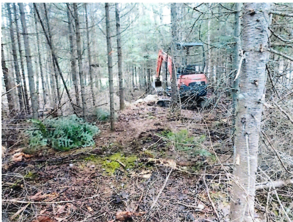
Position du sondage S-2
