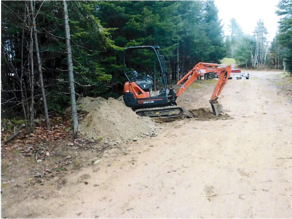
Position du sondage S-1
