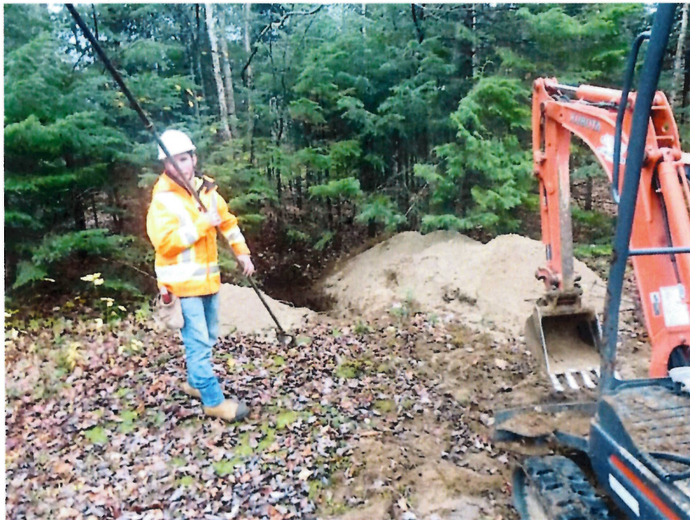
Position du sondage S-4
