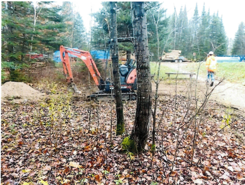
Position du sondage S-4
