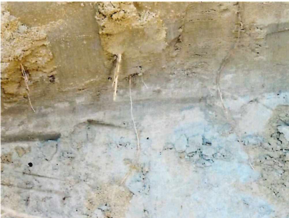
Vue de la stratigraphie des sols au sondage S-2
