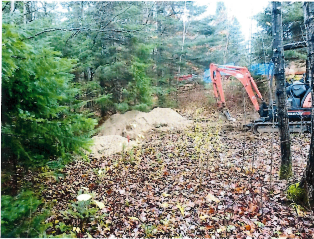
Position du sondage S-4
