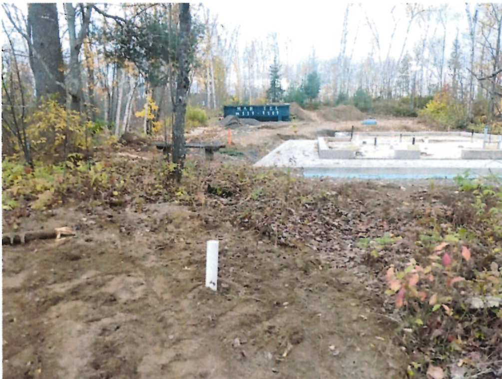
Position du sondage S-5
