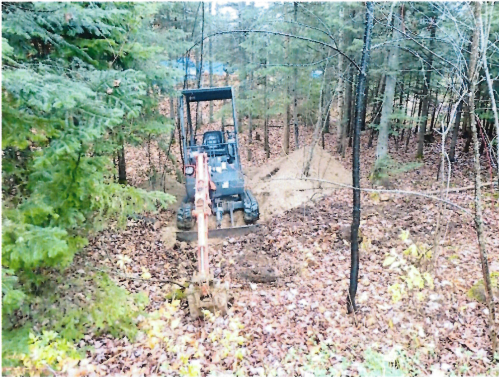
Position du sondage S-3
