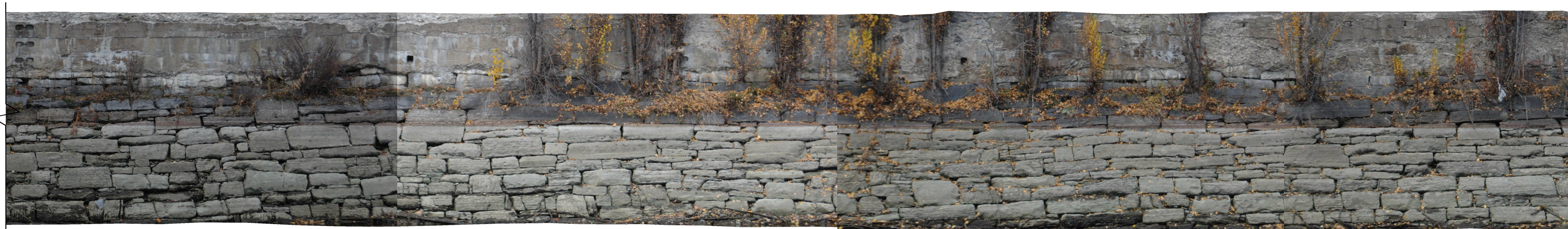
BIEF 3 - NORD - 18 - C
