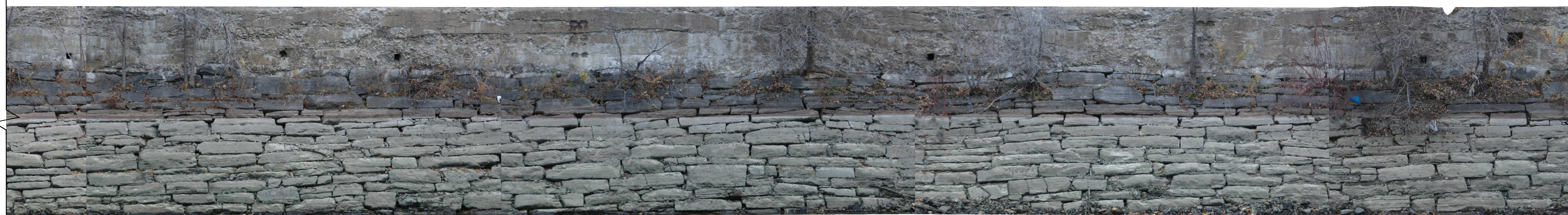
BIEF 3 - NORD - 16 - C
